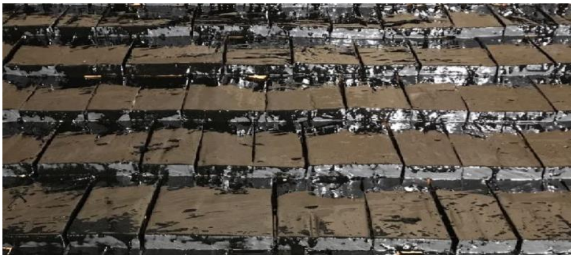
Figur 32: nysmort spåntak på Tiondeboden i Ingatorp. Förtjockad tjära som varar över tid. Foto: K. Melin.
