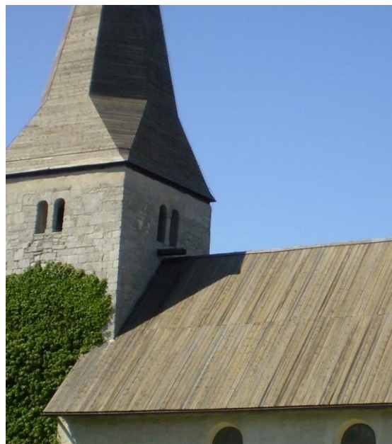
Figur 31: Fröjel kyrka med tjärat tak som solen sliter hårt på.
