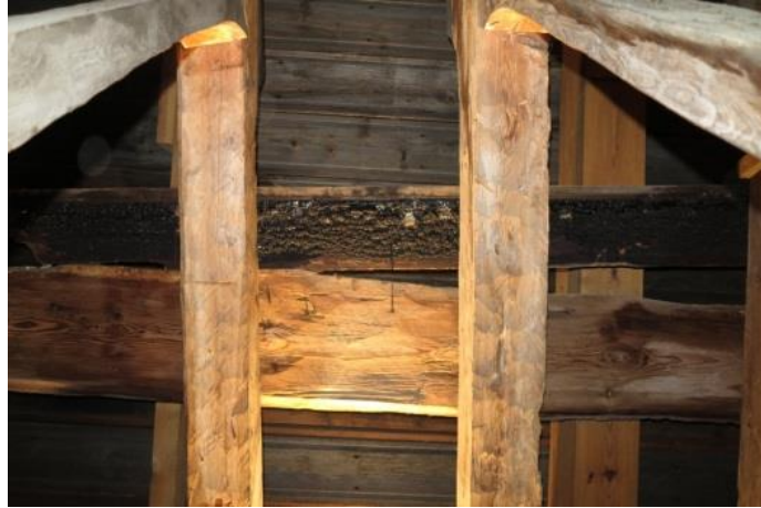
Figur 33: Återanvänt virke med tjockt tjärlager på Garda kyrkvind. Är den från det gamla taket?
