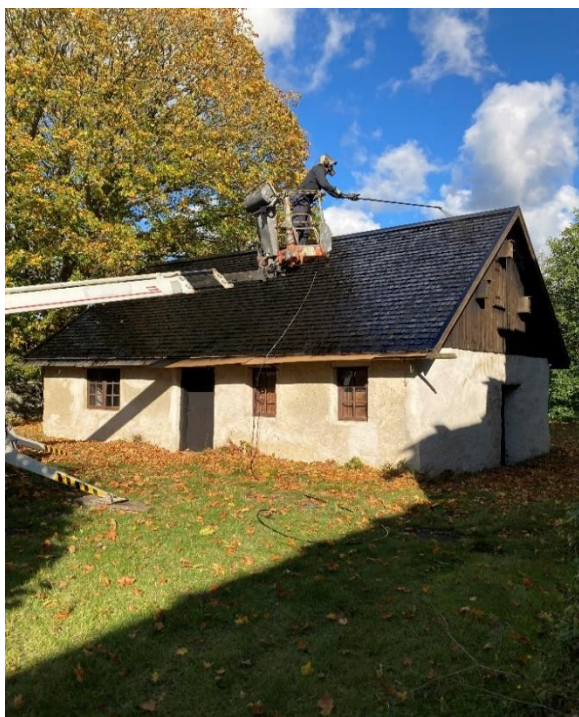
Figur 69: Tjärstrykning av smedjans spåntak med spruta. Figur 70: Till höger, tjärstruket faltak på ladugården.
