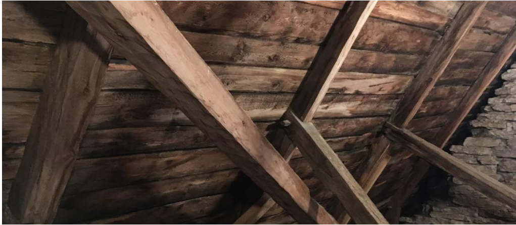
Figur 62: Underpanel till ett faltak tillverkade av ramsågade bräder.
