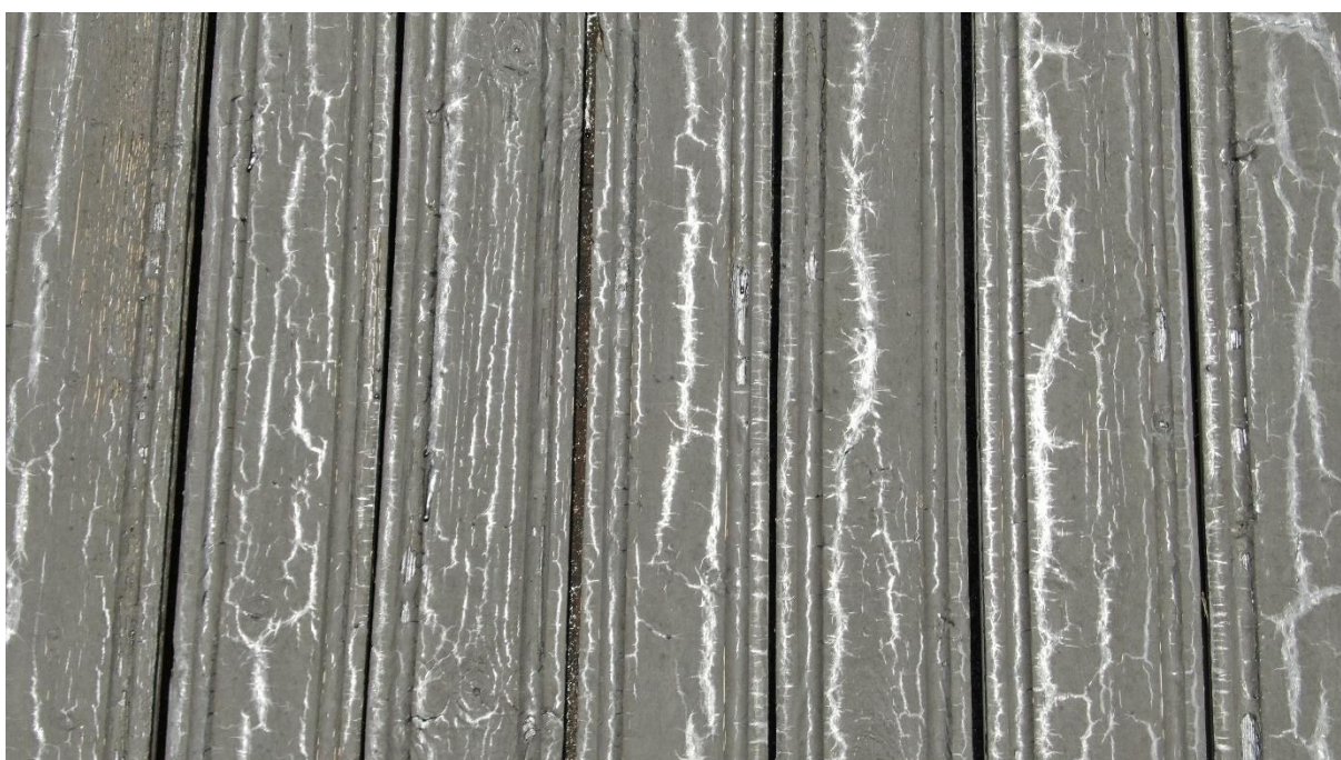
Figur 38: Närbild södra takytan. På falbrädan längst till vänster har solen redan tärt på tjärlagret så träet kan skönjas. För tunt tjärlager? Bräda av sämre kvalité?
