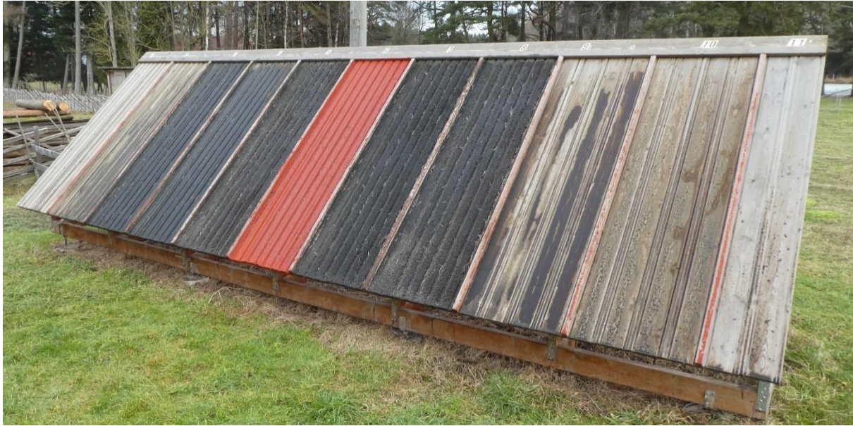
Figur 24: Provtaket fotograferat i februari 2021.
