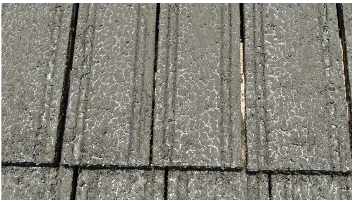
Figur 48: Närbild på södra takfallet.
