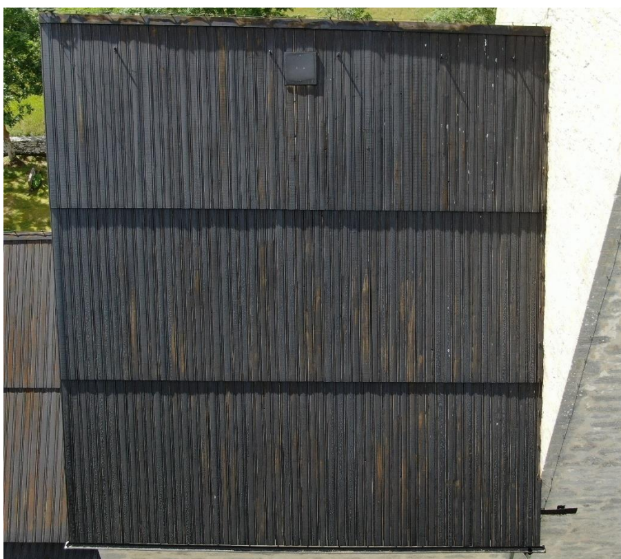
Figur 34: Långhusets norra takfall efter grundning.
