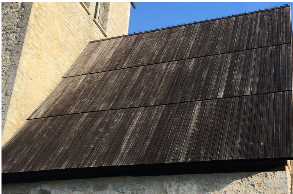
Figur 31: Långhusets södra takfall innan påbörjad tjärstrykning.
