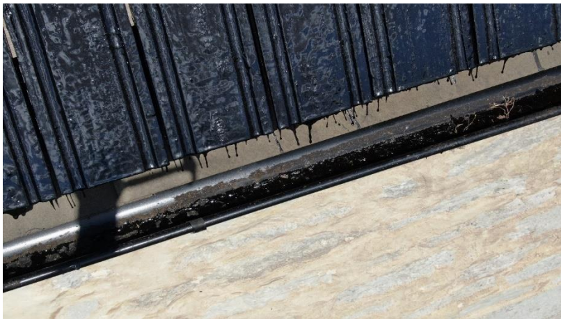
Figur 57: Långhustakets takskägg och avrinning i hängrännan.
