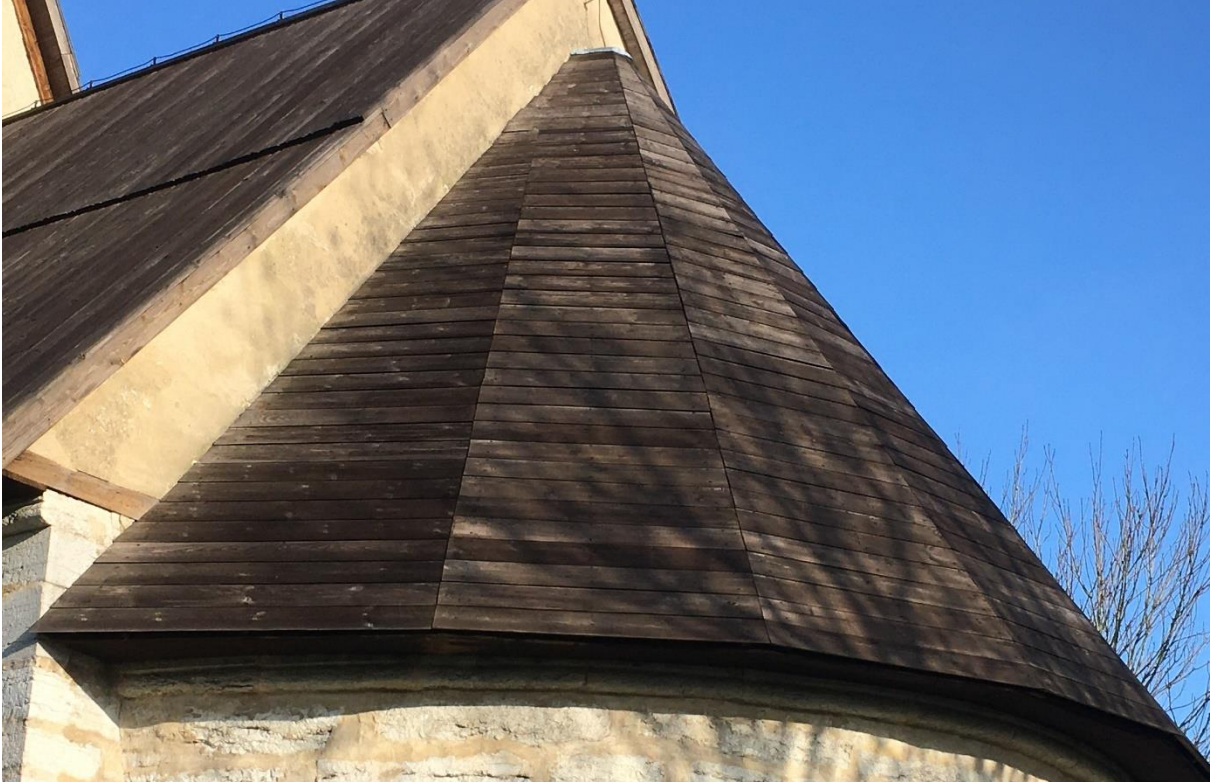
Figur 51: Korabsiden innan åtgärd.
