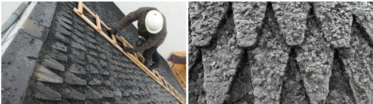
Figur 60 och figur 61: Närbilder på spåntaket i Røros
