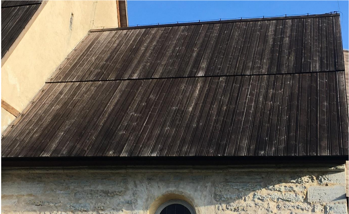
Figur 41: Korets södra takfall.
