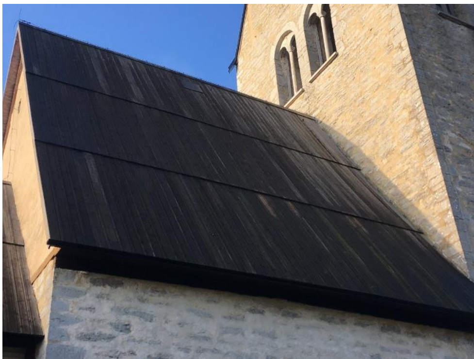
Figur 32: Långhusets norra takfall innan påbörjad tjärstrykning.
