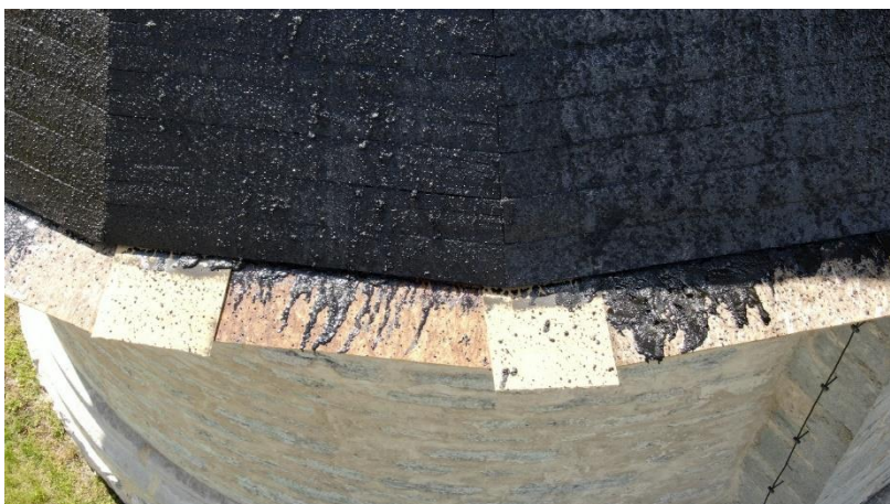
Figur 58: Nederdelen på korabsidens takfall.
