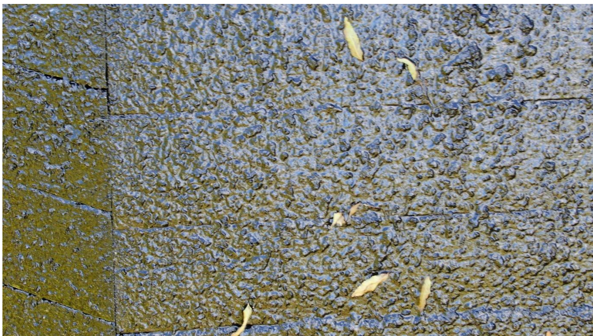
Figur 53: Närbild av nytjärad yta, sista strykningen.
