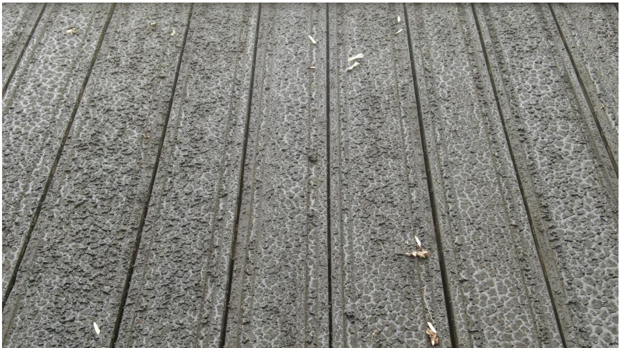
Figur 50: Närbild på norra takfallet.
