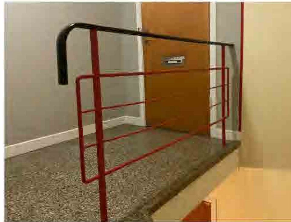
Vilplan i grå terrazzo, räcke i rödmålat smide med överliggare i svart plast.
