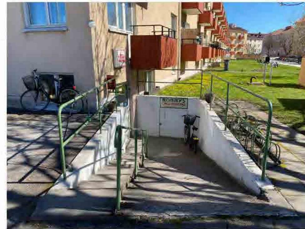
Ramp ned till cykelverkstad.
