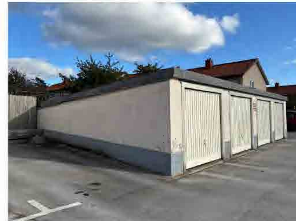
Garagebyggnad under pulpettak.
