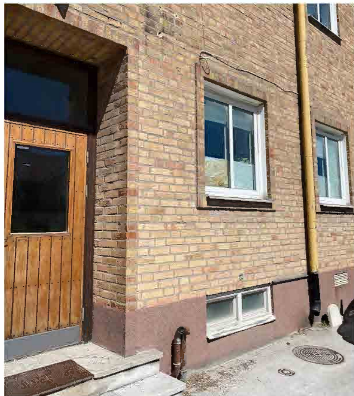
Gatufasaden med fönsteromfattningar i tegel.
