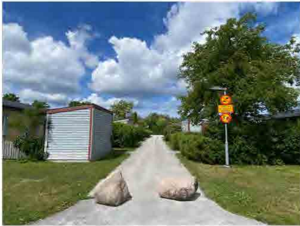
Området är trafikseparerat och genom det löper en asfalterad gångväg från vilken respektive lägenhet nås.
