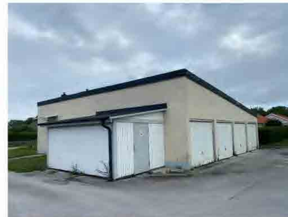
Garagebyggnad under pulpettak.
