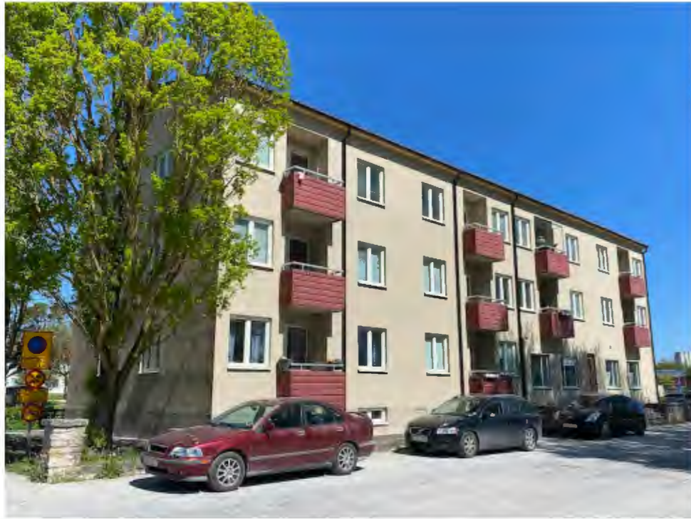
Balkongerna ligger indragna från fasad, med utbytta fronter.
