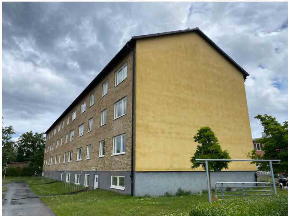
Huskroppens gavlar är helt täta, putsade och avfärgade i en gul kulör. Framför gaveln syns en piskställning
