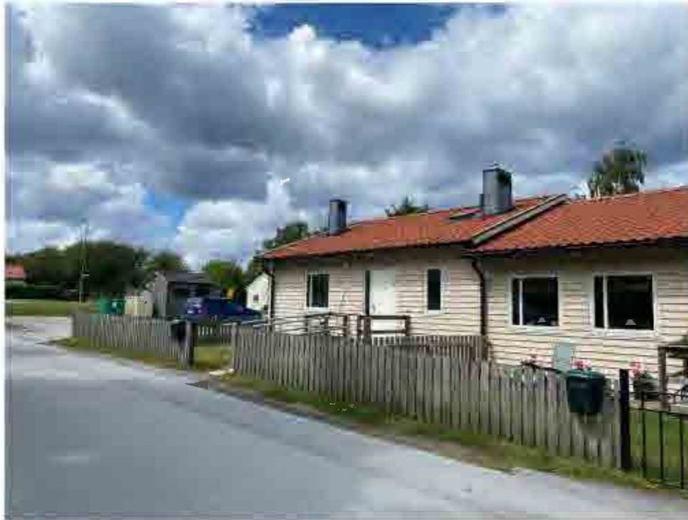
Fasaderna är klädda med förändringspanel, fönstren är utbytta till moderna, pivothängda i lättmetall.
