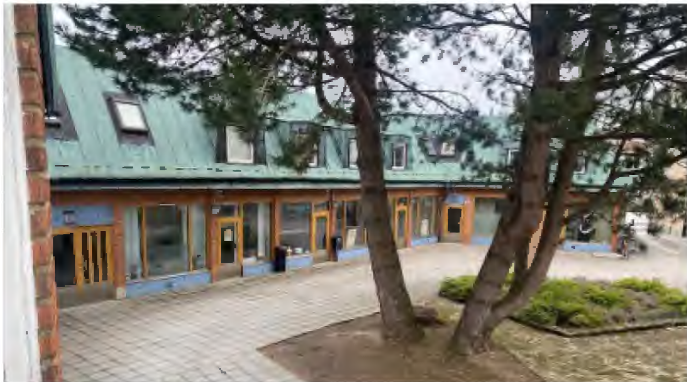
Del av centrumhusets fasader mot det lilla torget.
