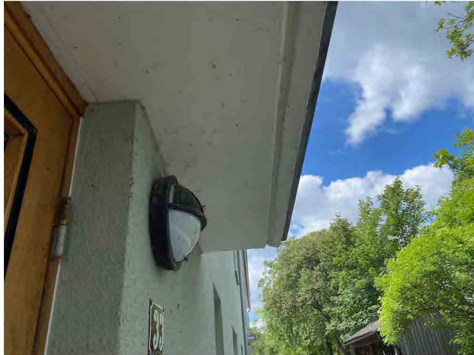
Skärmtaket har en gjuten skära längs underkanten.
