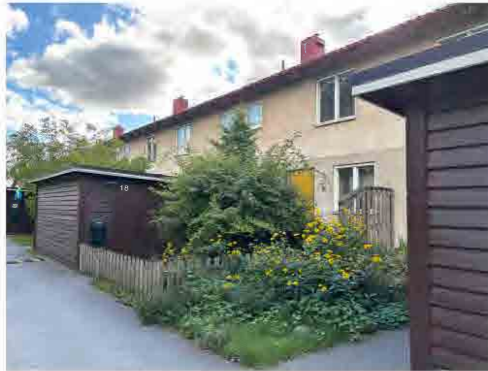
Husen har ursprunglig puts, troligtvis i ursprunglig tvådelad färgsättning.
