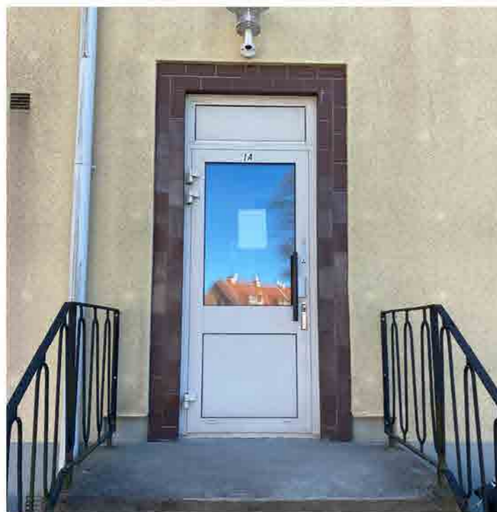
Trappusentré med dörrparti i aluminium.
