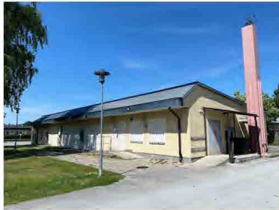
Centrumhusets ursprungliga fönsterytor har delvis ersatts med vitmålad träpanel.
