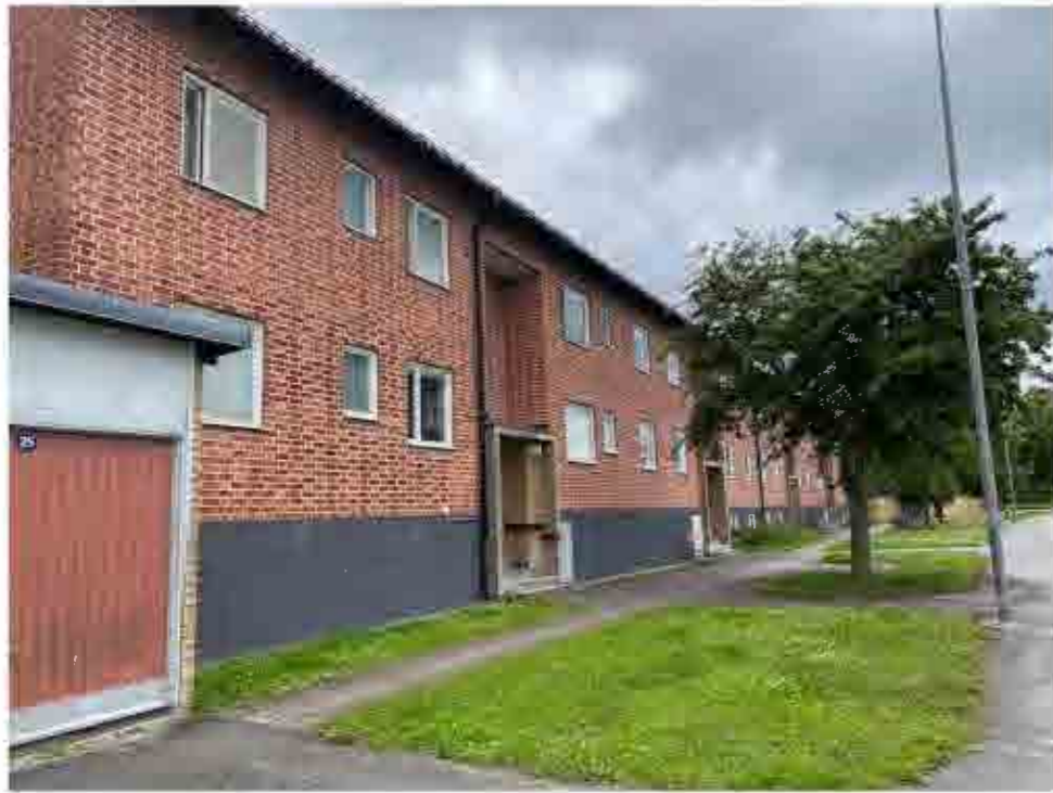
Entréfasaden i röttegel. Trapphusen är markerade med indrag från fasadliv.
