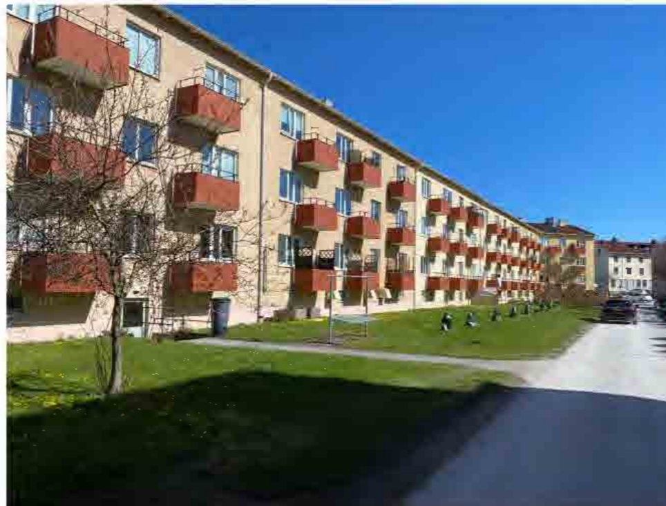
Västra fasaden med balkonger mot gårdssidan.
