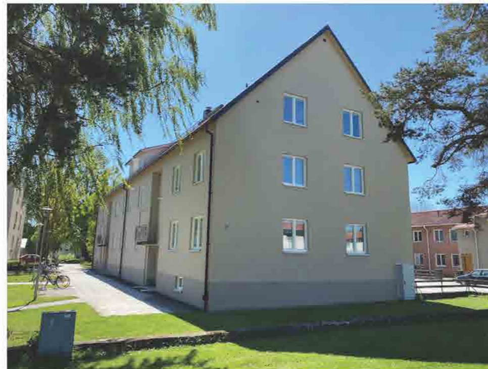
Vy över fasaden åt väster.
