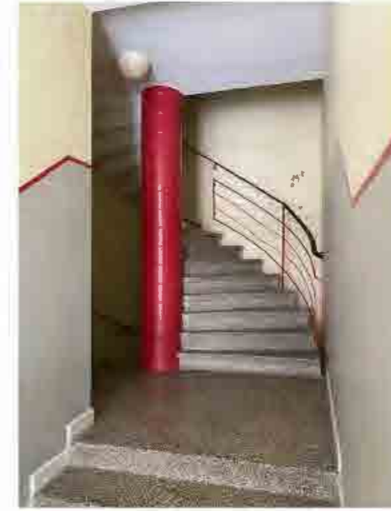
Vy mot trapplopp från förstuga.
