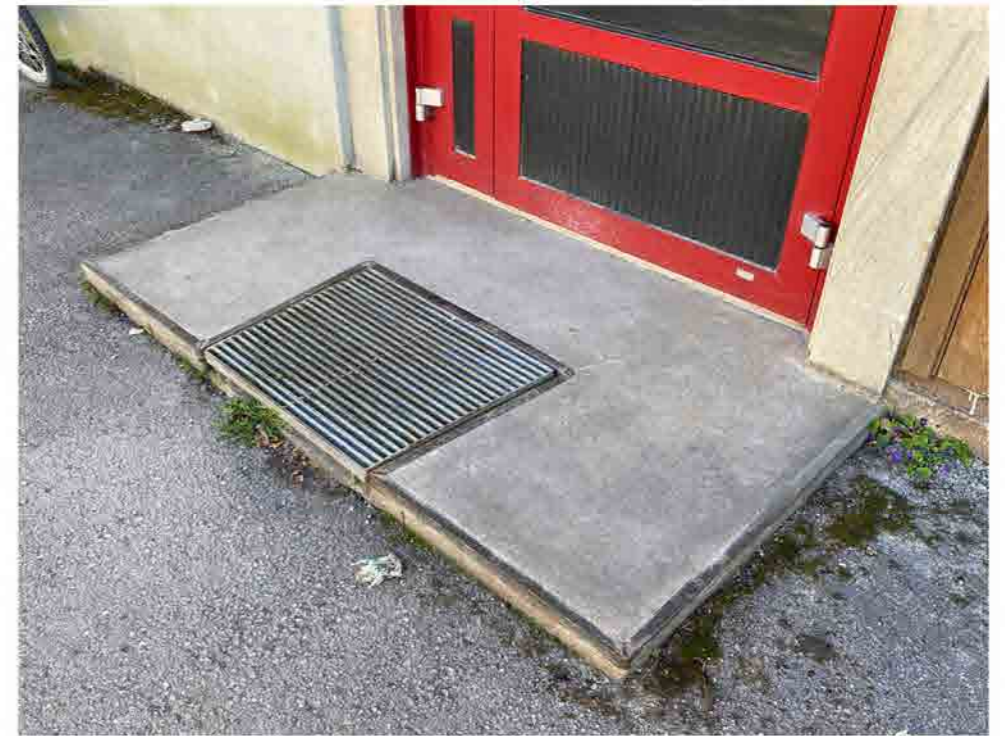
Trappsteg med metallskodd kant.
