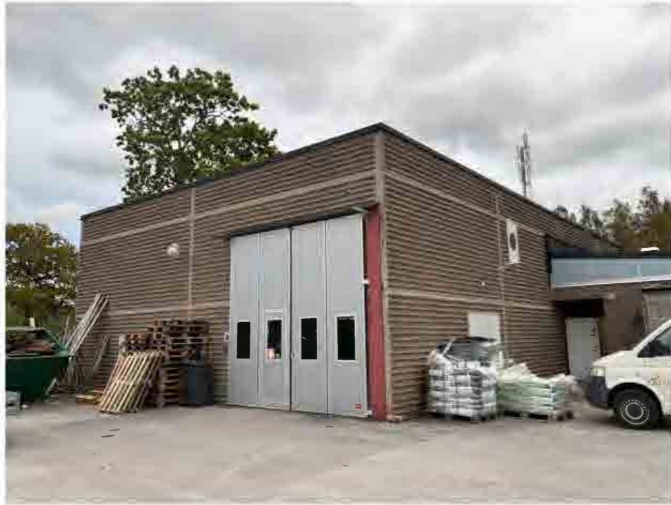
Exempel på bevarade fasadelement i formgjuten sjöstensbetong.
