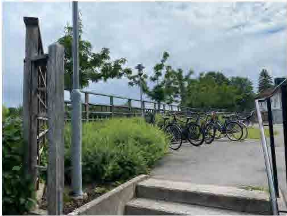
Detalj av trappa och räcke.
