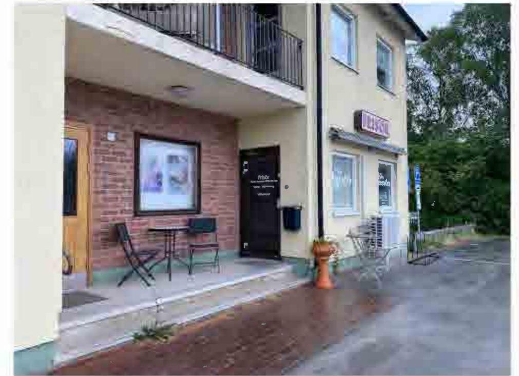
Entrépartier och ovanförliggande balkonger ligger indragna från fasadliv.
