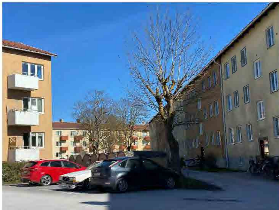
Gemensam gårdsyta med parkering, miljöstation och uppvuxna träd.
