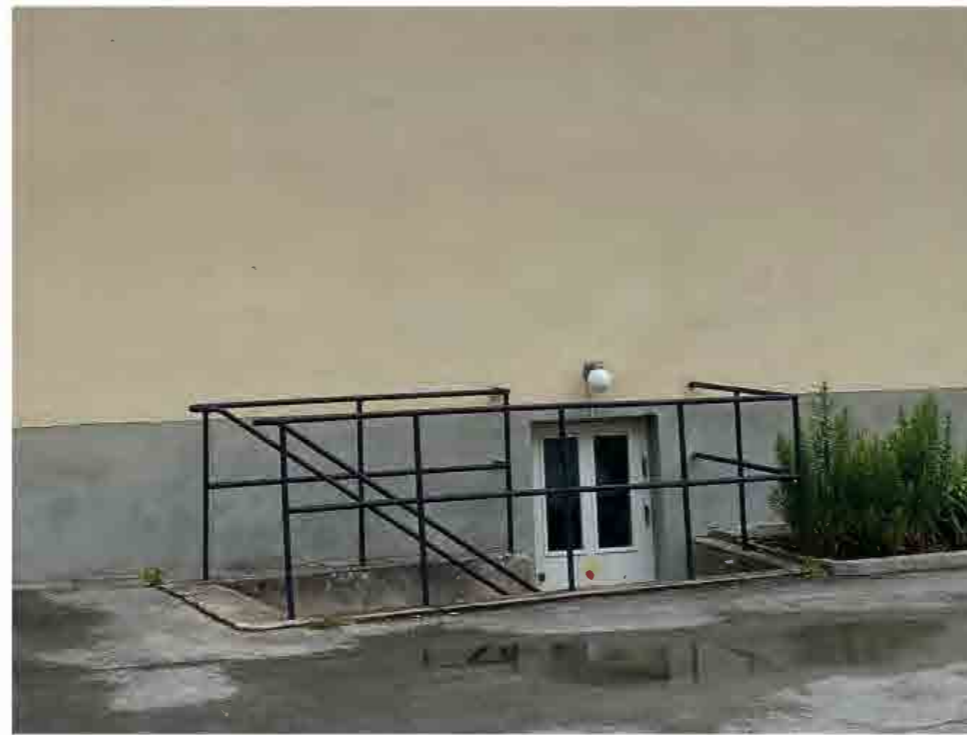
Trappa till källare, med ursprunglig armatur.
