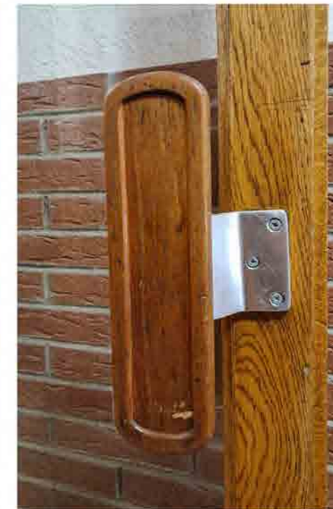
Detalj porttrycke hos vindsfångets pardör- rar.
