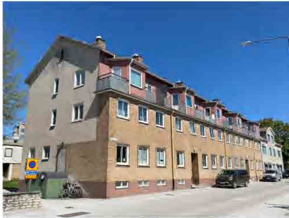
Fasad mot Storgatan.
