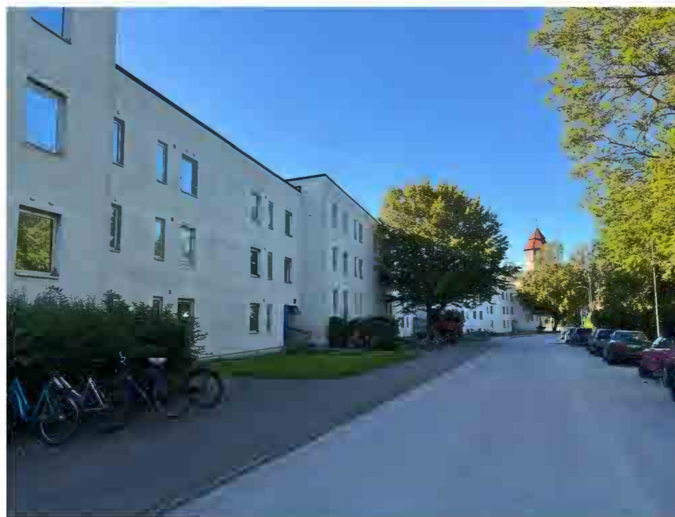
Vy längs med Torsgatan i västlig riktning.
