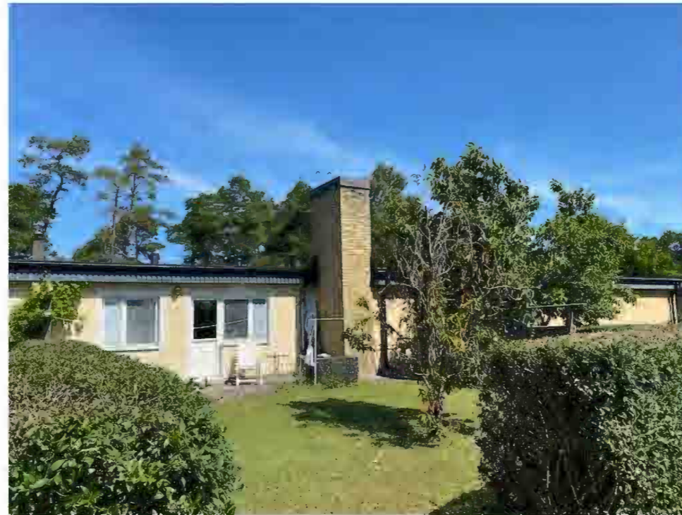
Skorsten murad i gultegel tillhörande den ursprungliga, gemensamma panncentralen.
