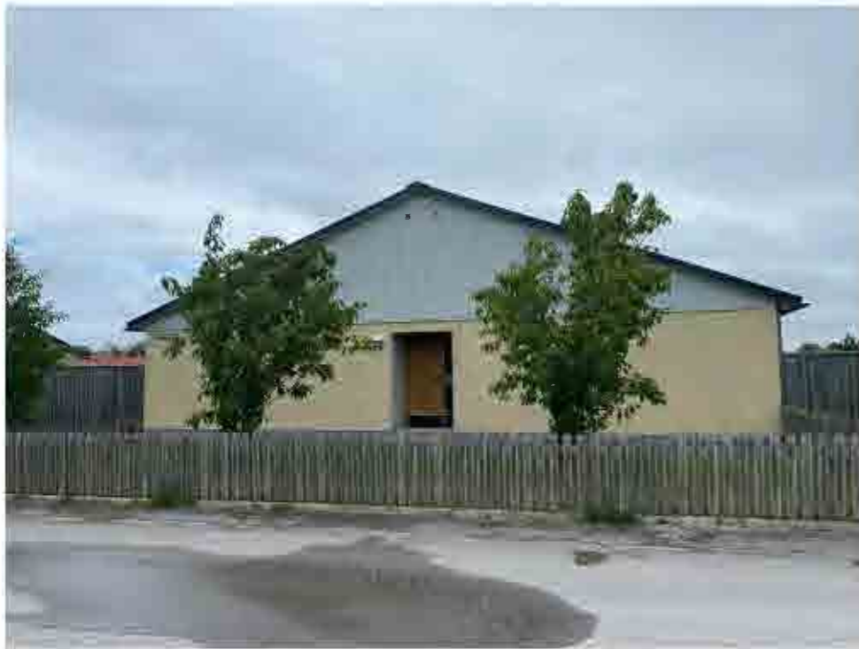
Putsad fasad med plåtinklätt gavelröste.
