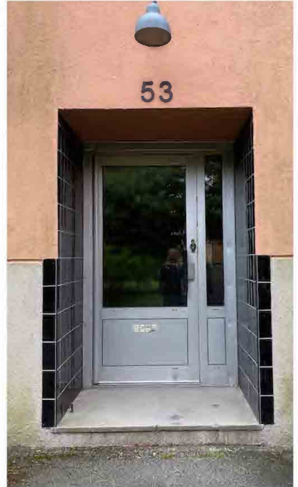
Områdets entréportar är utbytta till aluminiumportar.
