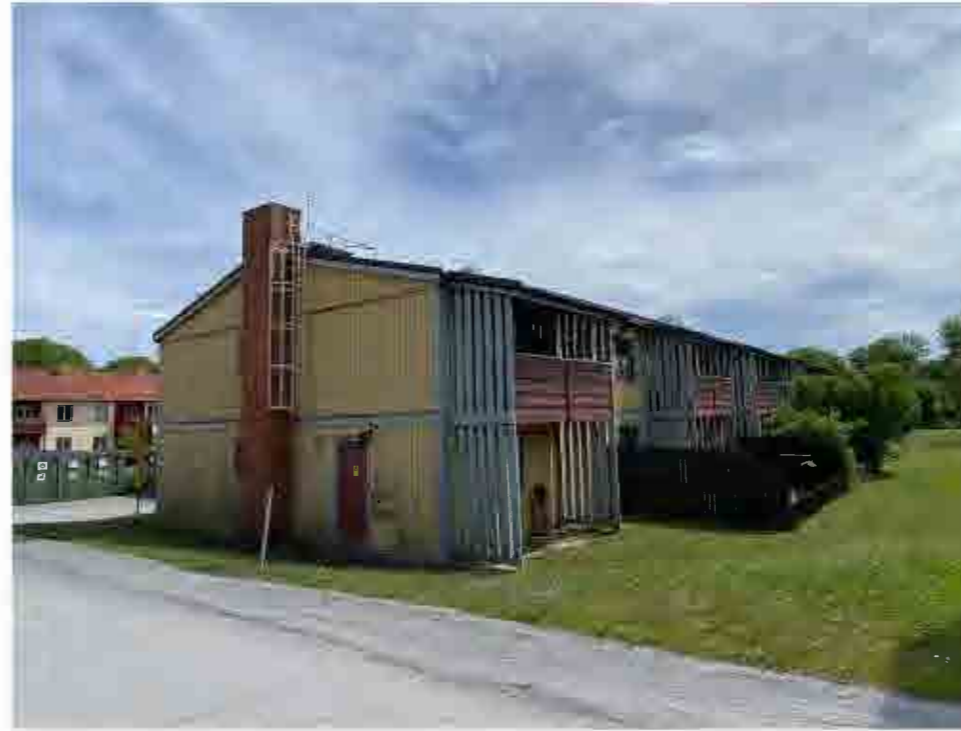
Balkonger och uteplats med vind- och insynsskydd i glesmonterad och blåmålad panel. Balkongfronterna är rödmålade. Pannskorsten murad i rödtegel.
