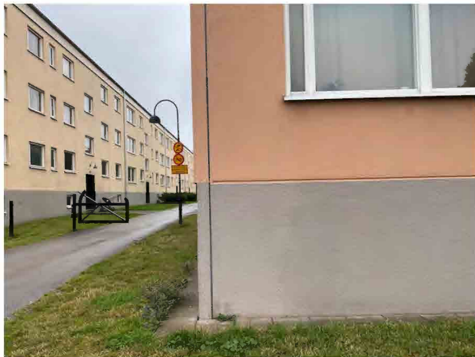
Husen har tilläggsisolerats utvändigt med putsade skivor.
