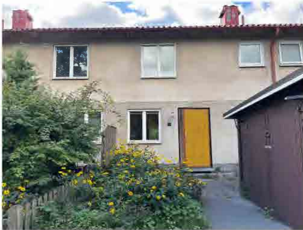
Exempel på entré med asfalterad och stenlagd gång fram till ytterdörr, flankerad av förrådsbyggnad respektive plantering.
