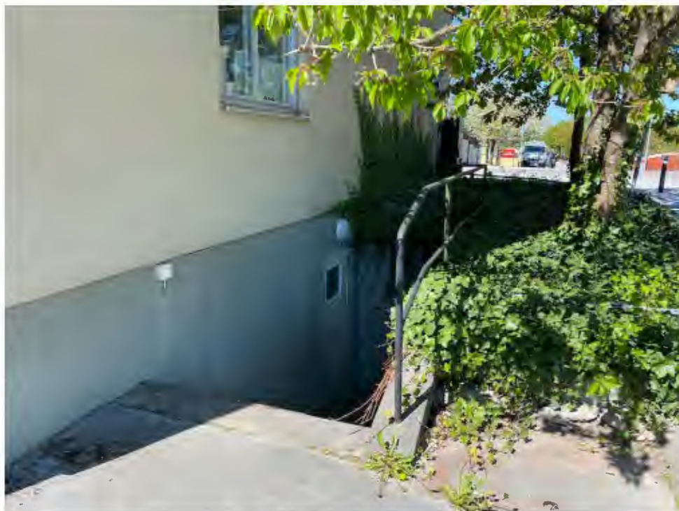
Nedgång till källarplan vid gaveln, huset vid Storgatan.
