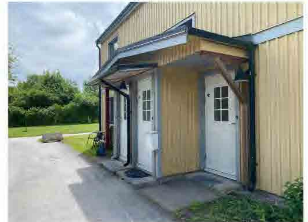
Bostadshusens fasader är klädda med gulmålad locklistpanel. Foder är täckmålade ljus blå och dörrbladen är vita.
