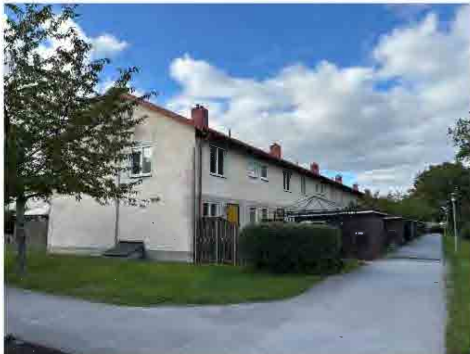
Vy längs med en av huskropparnas entréfasader. I anslutning till entréläget har varje hus en egen förrådsbyggnad.
