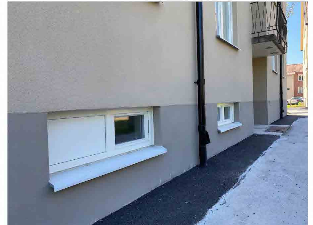
Huskropparna har nyligen renoverats och tilläggsisolerats.
