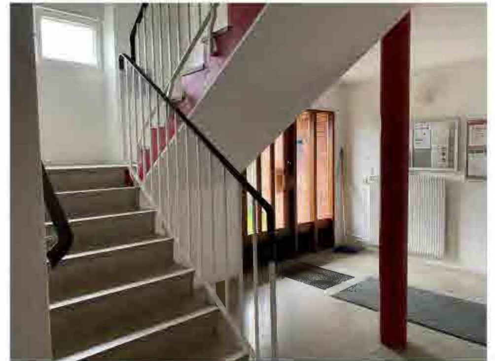
Bottenvåningen och trapplopp med ursprunglig golvbeläggning och räcken.
