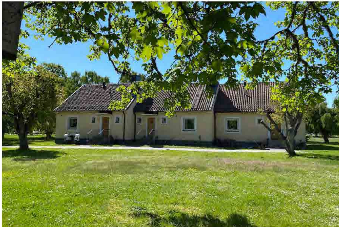
De tre bostadsenheterna har, trots ovarsamt byte av fönster och tilläggsisolering, fått bibehålla sin ursprungliga karaktär.
