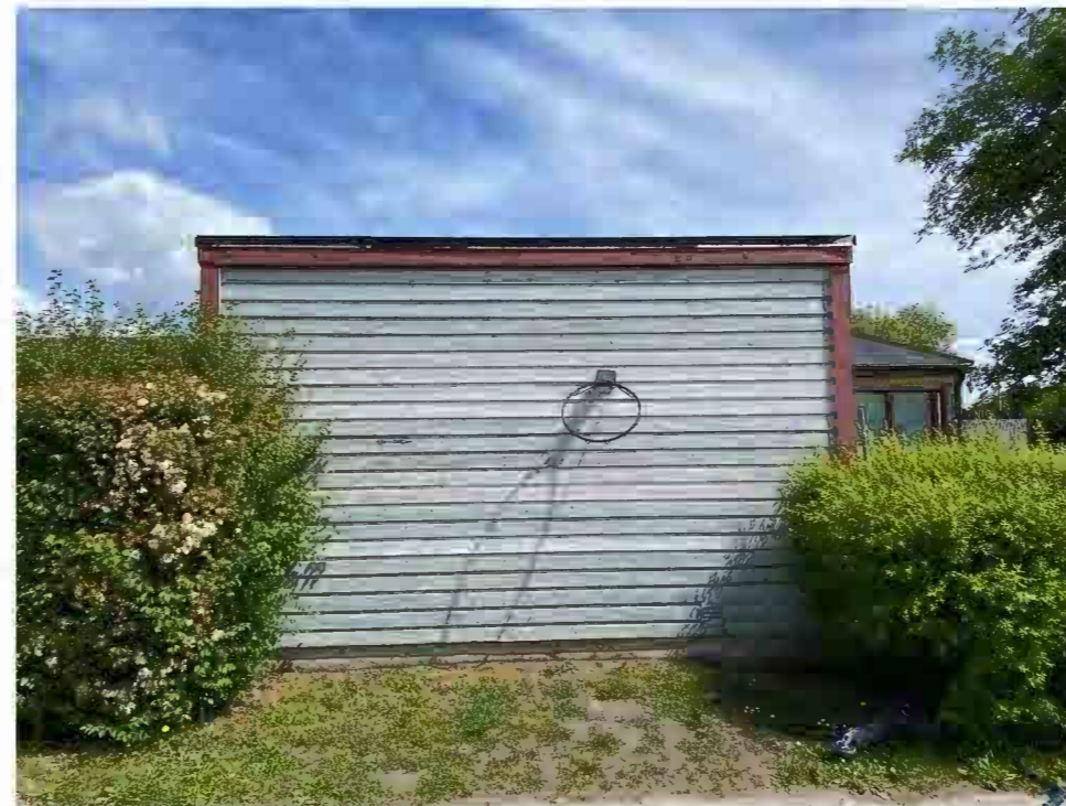
Varje bostadslägenhet har en egen förrådsbyggnad vid entrén. Fasaderna är panelklädda och täckmålade gult, blått och rött.
