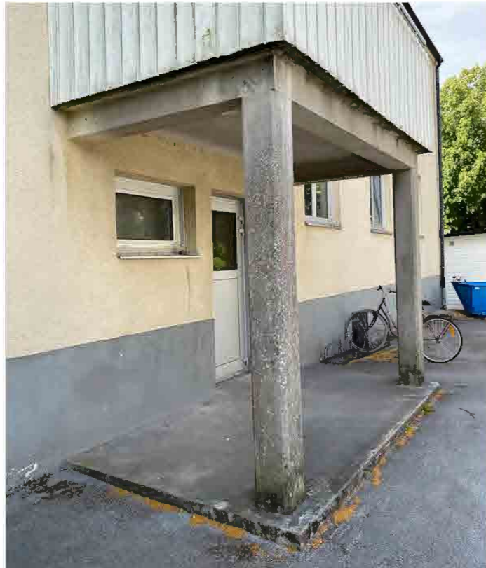
Gjutna stöpelare för balkong.
