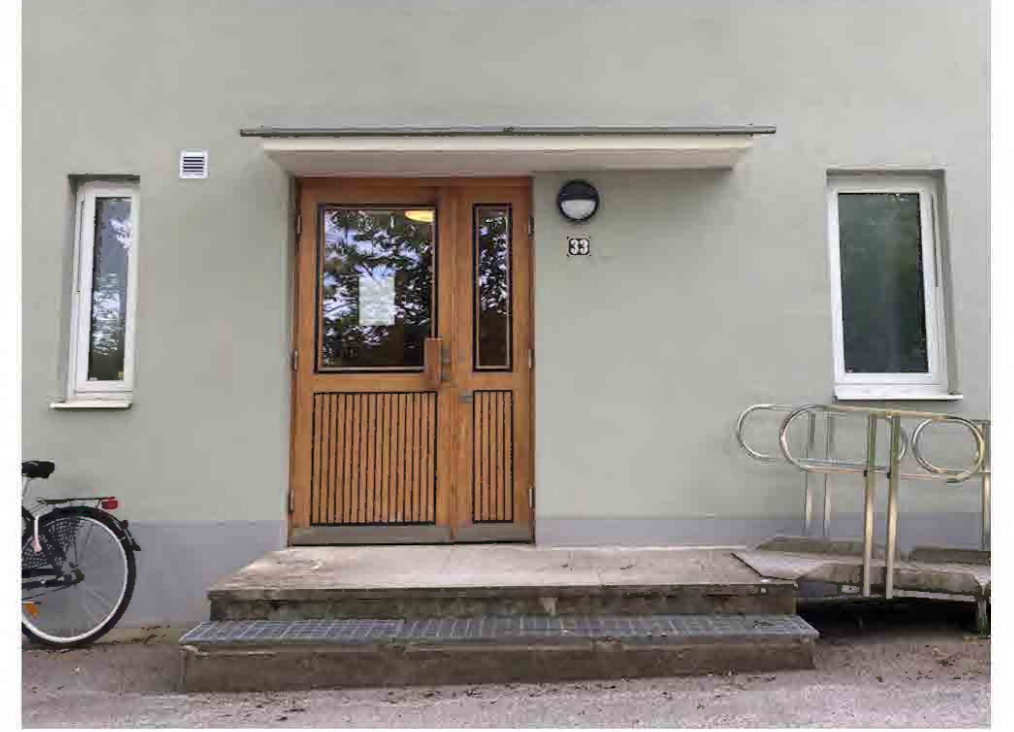
Entré till ett av trapphusen, med ursprunglig port och entrétrappa.
