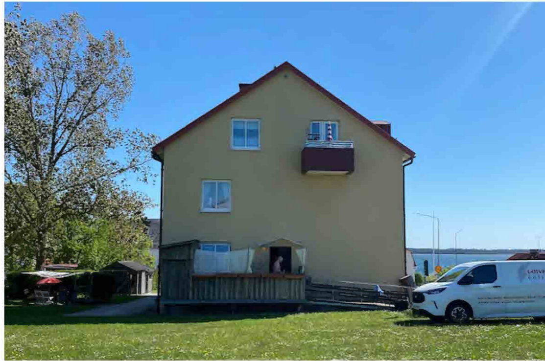
Gavelfasaden åt norr.
