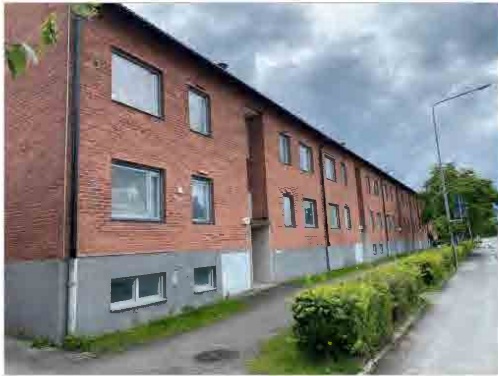
Flerbostadshuset uppfört i två våningsplan med källare.
