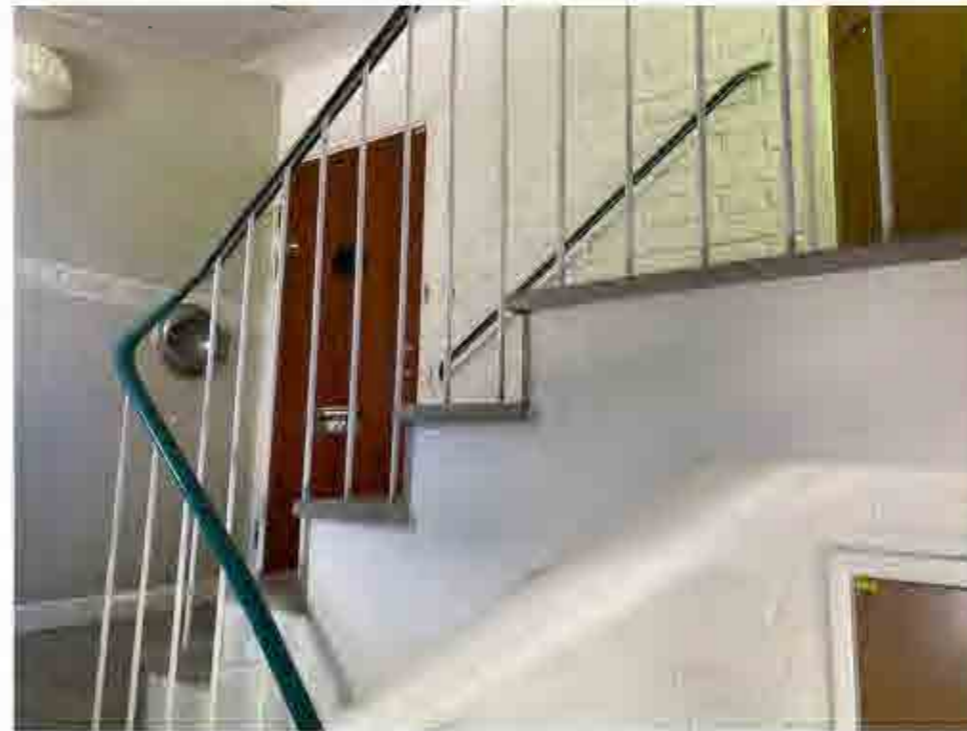
Trapphuset med bevarade ursprungliga detaljer som räcken och handledare, luckor för sopnedkast och golv- och vilplanens beläggning i kalksten.
