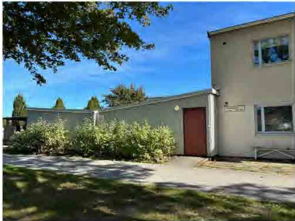
Motbyggd funktionsbyggnad med pulpettak.
