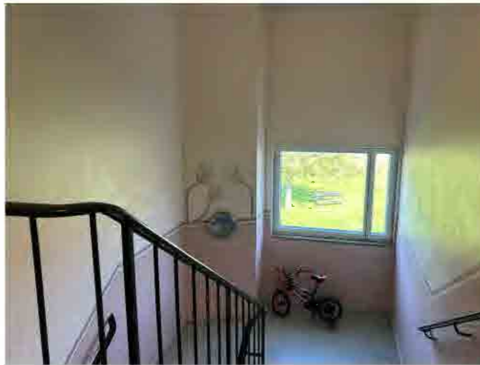
Vy över trapplopp. Luckorna till sopnedkassen är bevarade men plomberade.
