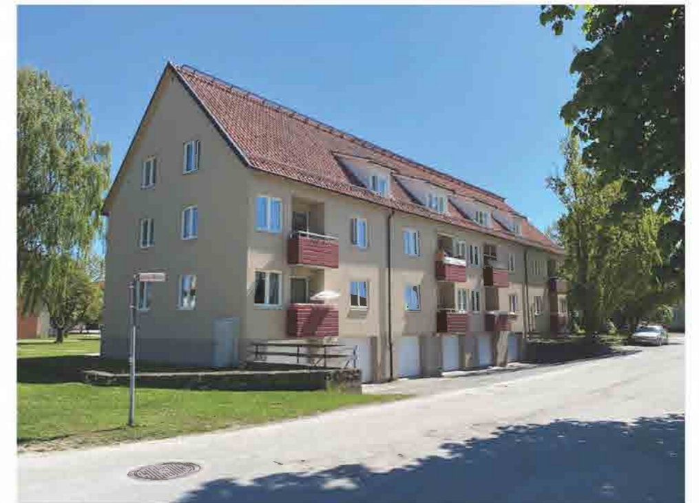
Fasaden mot söder, med garage och balkonger.
