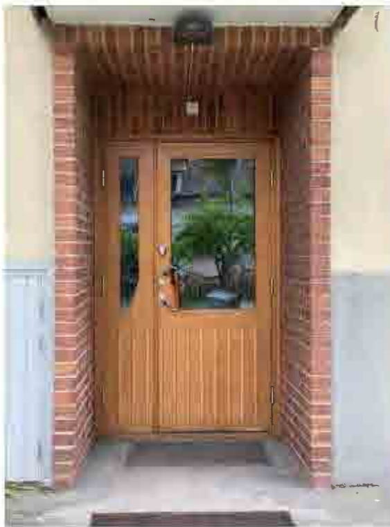
Bevarad ursprunglig entréport i trä och glas. Murad portomfattning i rödtegel.
