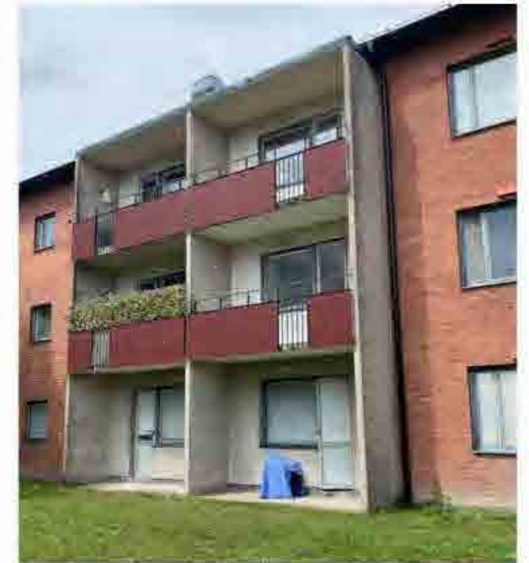
Balkonger med skiljeväggar i kalksandsten, fronter i plåt i rött och svart.
