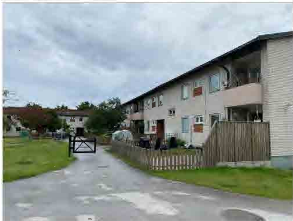
Vy över gården som kringgärdas av bostadshusen. Bottenvåningens lägenheter har uteplats i markplan med staket och insynsskydd.
