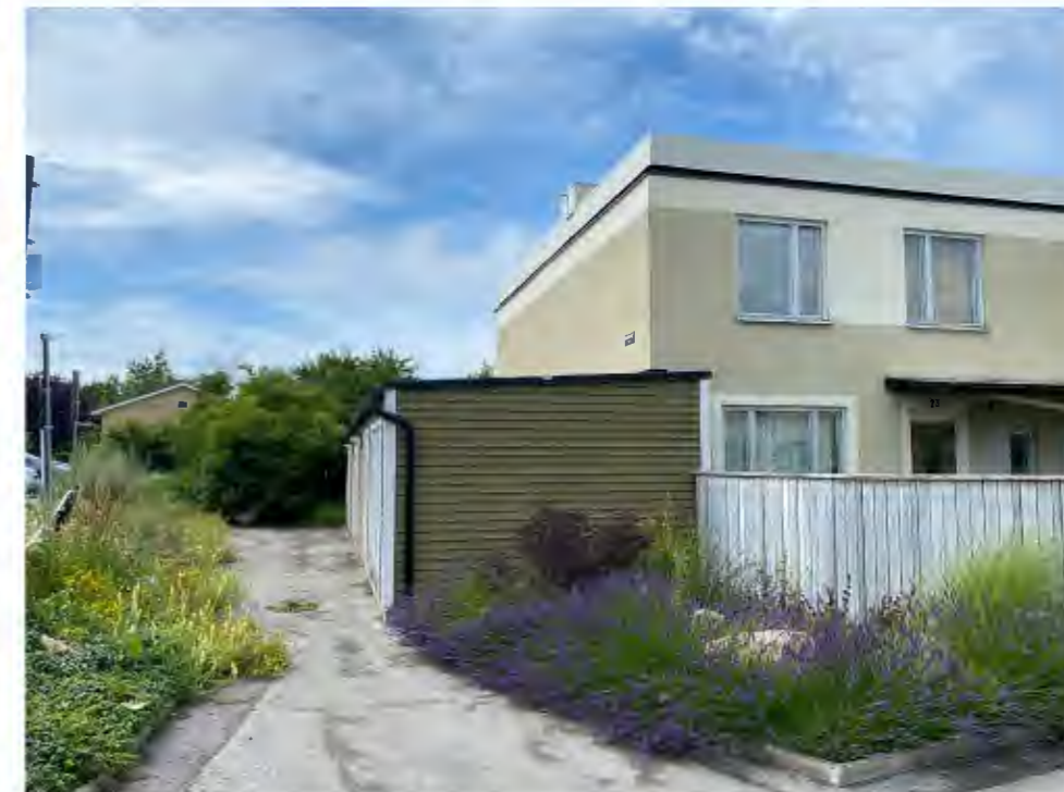
Planteringar med tåliga växter och förrådsbyggnader.
