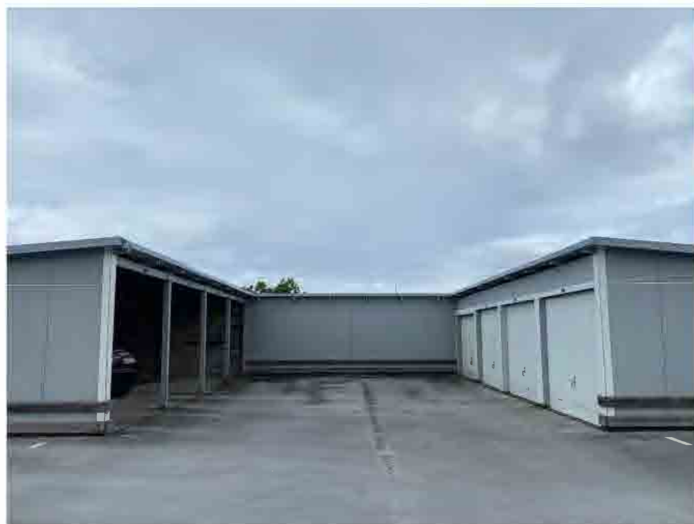
Garage- och carportbyggnader.
