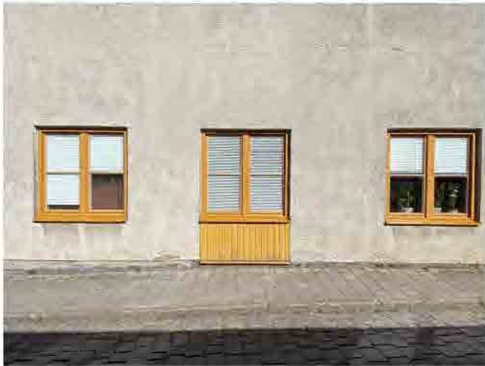
Låg fönstersättning var ett annat grepp för att anpassa den nya bebyggelsen till platsen.
