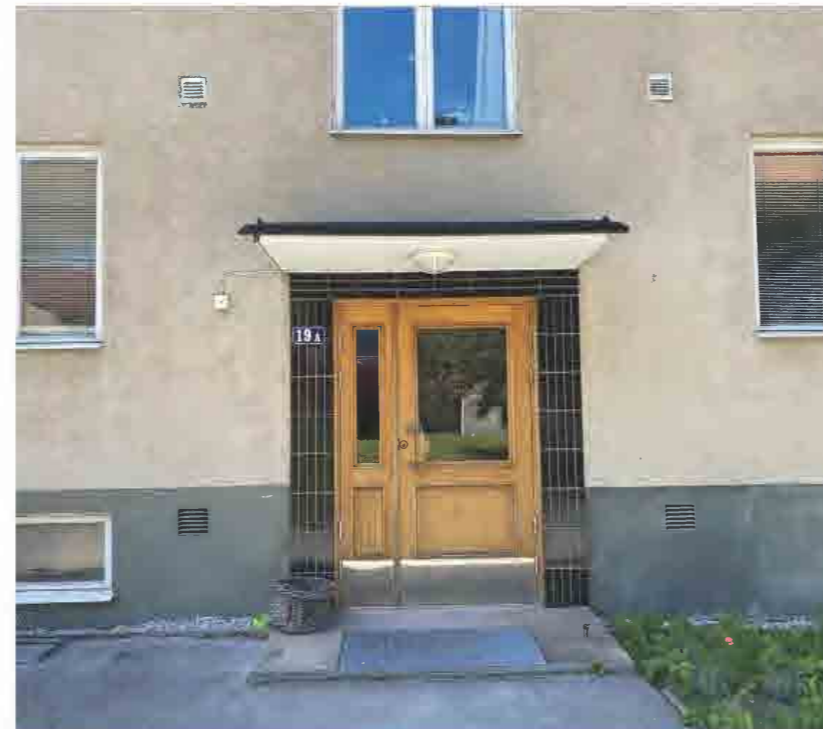
Ursprunglig entréport med portomfattning i svart kakel.
