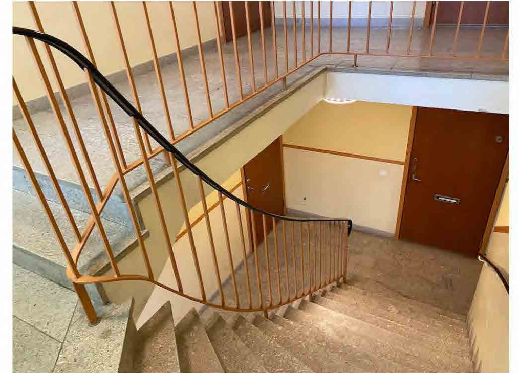
Trapphus med enkla svängda smidesräcken med handledare klädda med krympplast.
