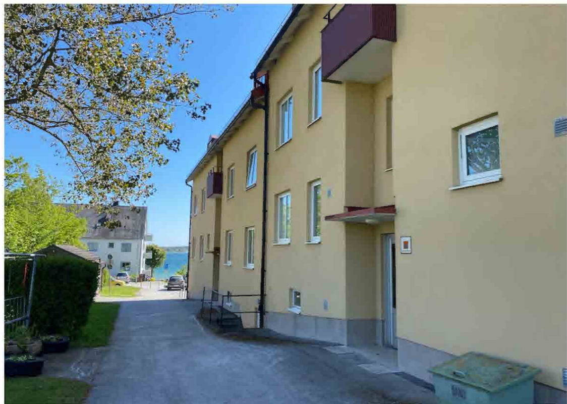
Trapphusentréerna ligger inåt fastigheten och är markerade med indrag från fasadliv.
