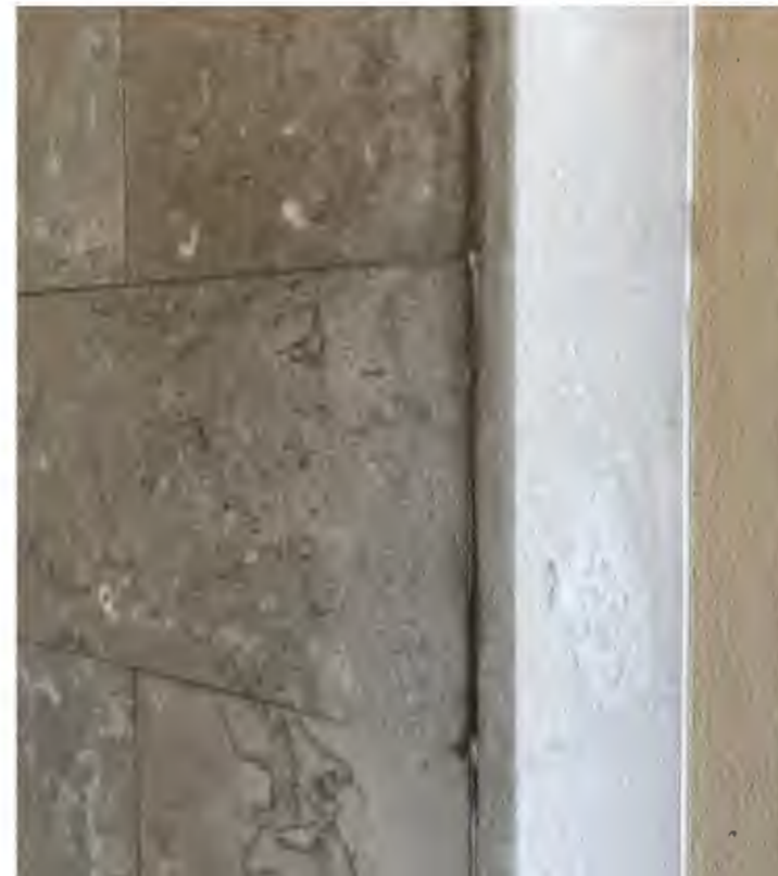
Portomfattning klädd med kalksten.
