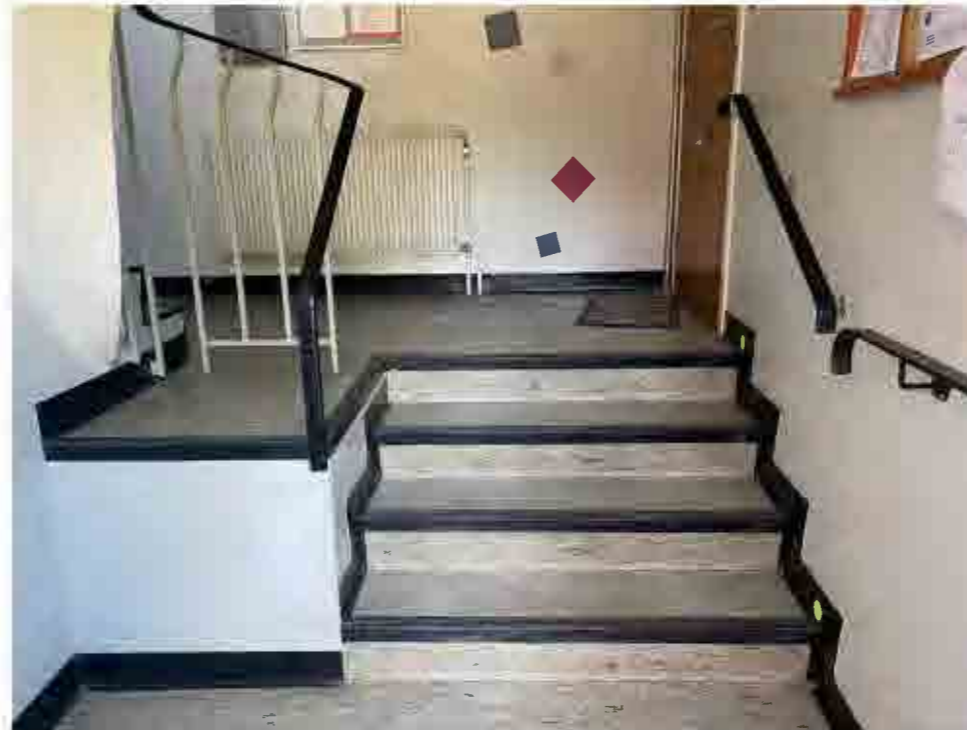
Vy mot trapplopp från förstuga.
