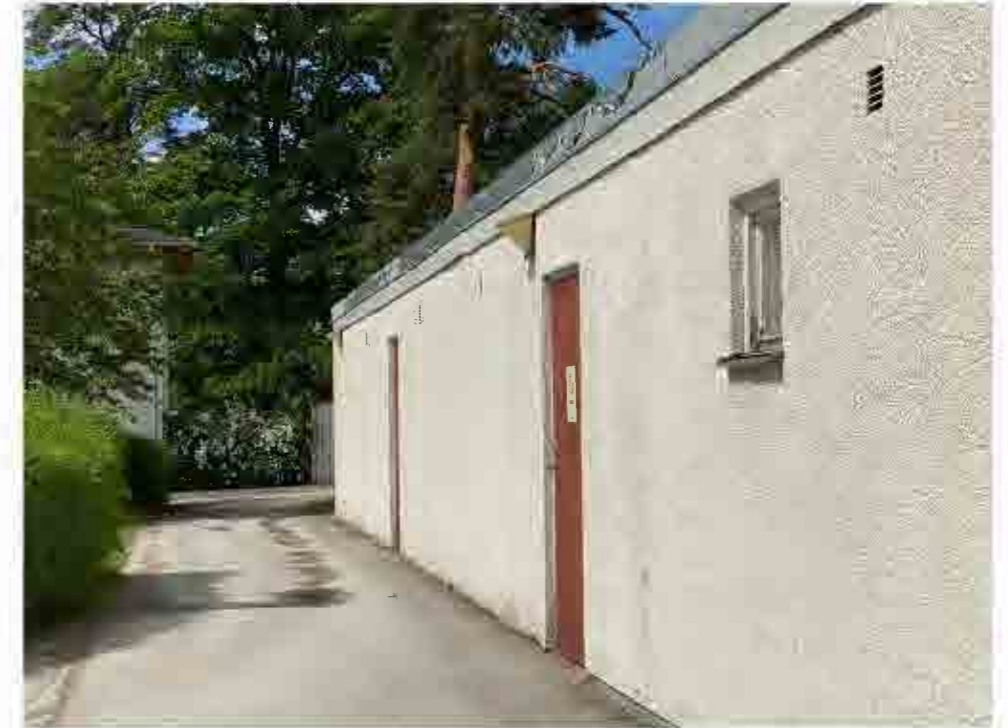
Servicebyggnad med ursprunglig puts.
