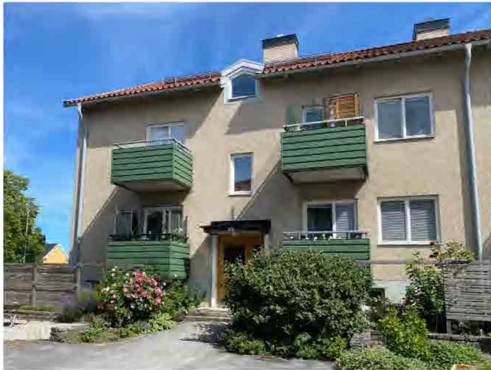
Del av entréfasad. Tidstypiskt lekfullt ljusinsläpp till trapploppet som bryter genom takfoten.
