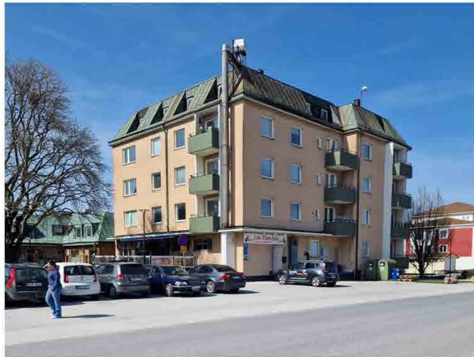
Byggnaden sedd från Signalgatan i söder.
