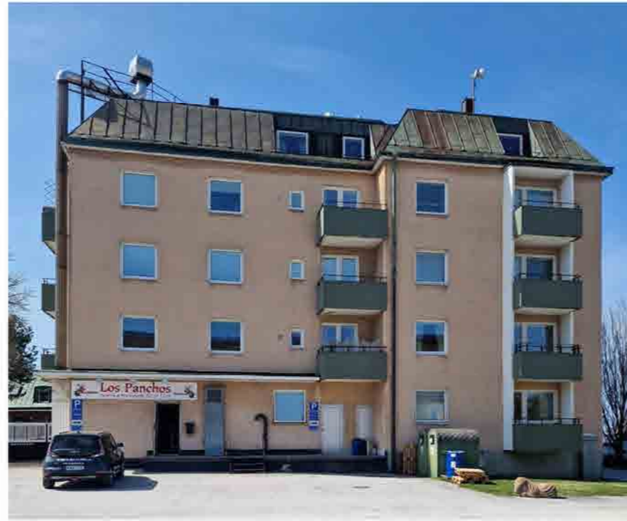
Lastkaj och balkonger mot Signalgatan.
