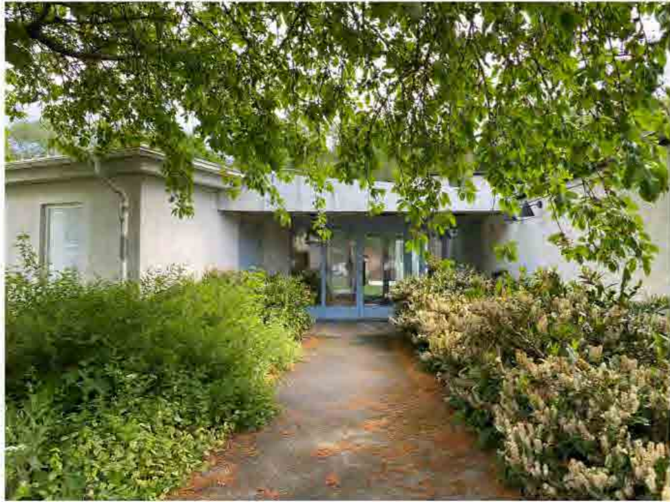
Gångväg flankerad av planteringar.
