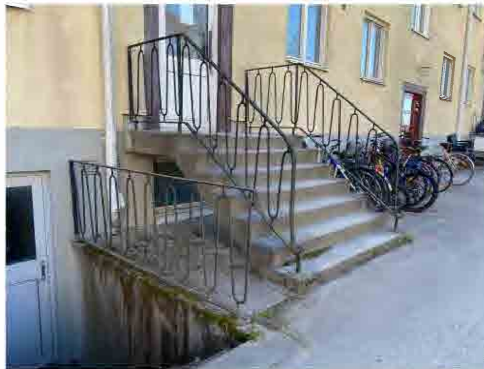
Smidesräcken i anslutning till entréer mot gårdssidan.
