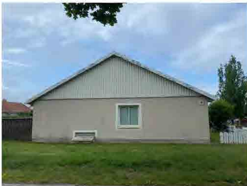
Gavel i puts och plåtinklätt gavelröste.
