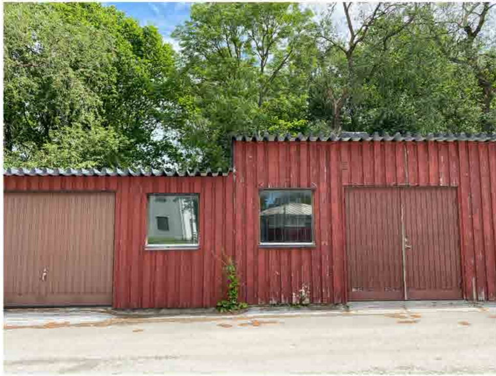
Servicebyggnad med fasader i slamfärgad träpanel.
