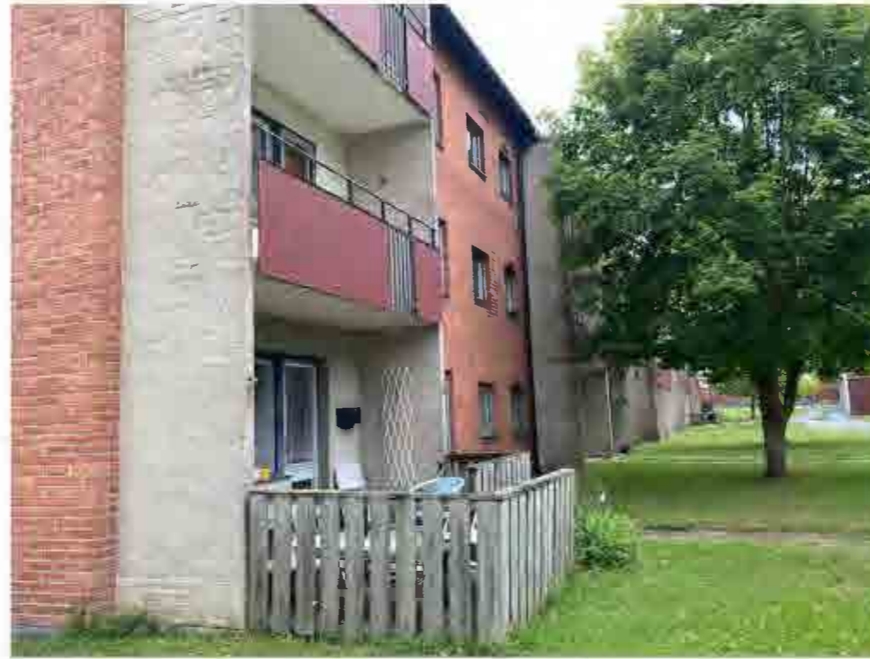
Balkonger med sidoväggar i kalksandsten/silikattegel.
