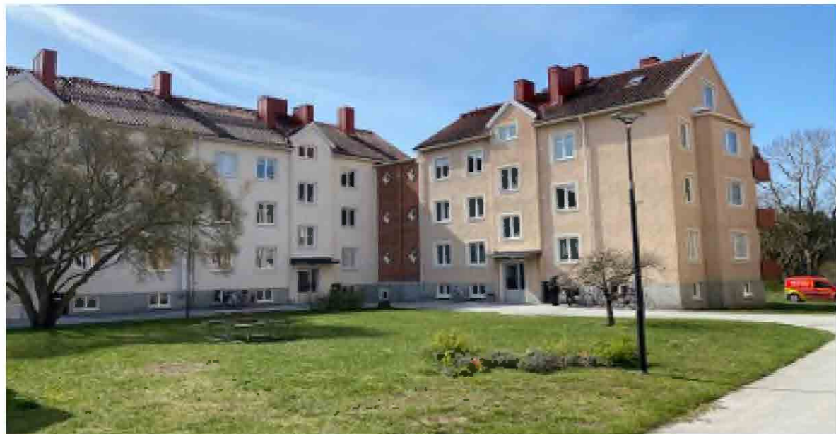
Huskropparna är placerade i vinkel och sammanbyggda med en länk murad i tegel.
