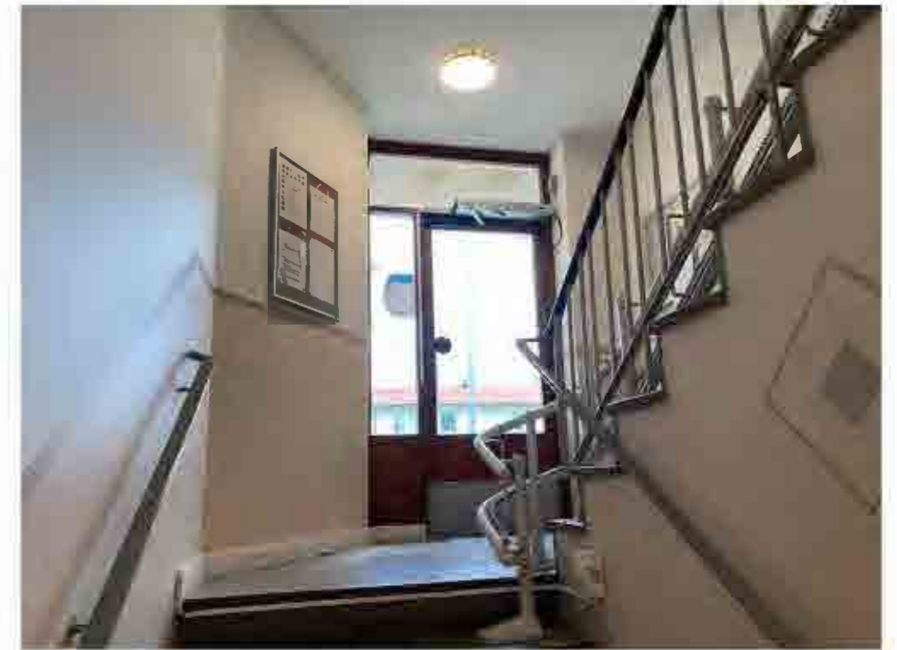
Vy mot entrén från trapploppet.
