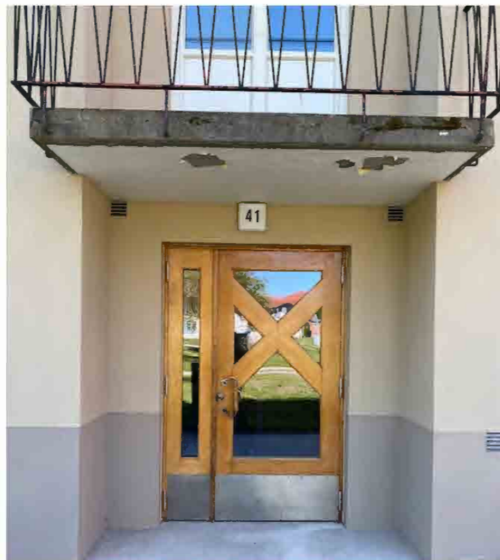
Ursprunglig port med ovanförliggande piskbalkong. Nedfällt skrapgaller framför porten.
