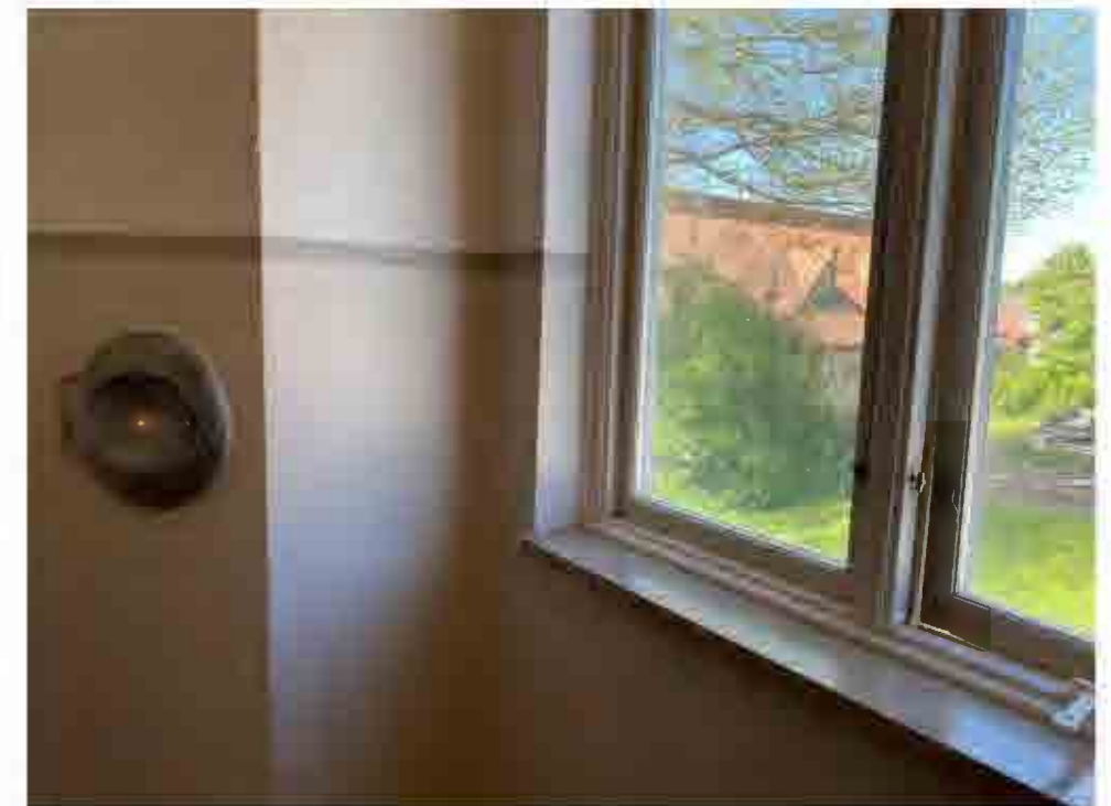
Ursprungliga fönster och bevarad lucka till sopnedkast.
