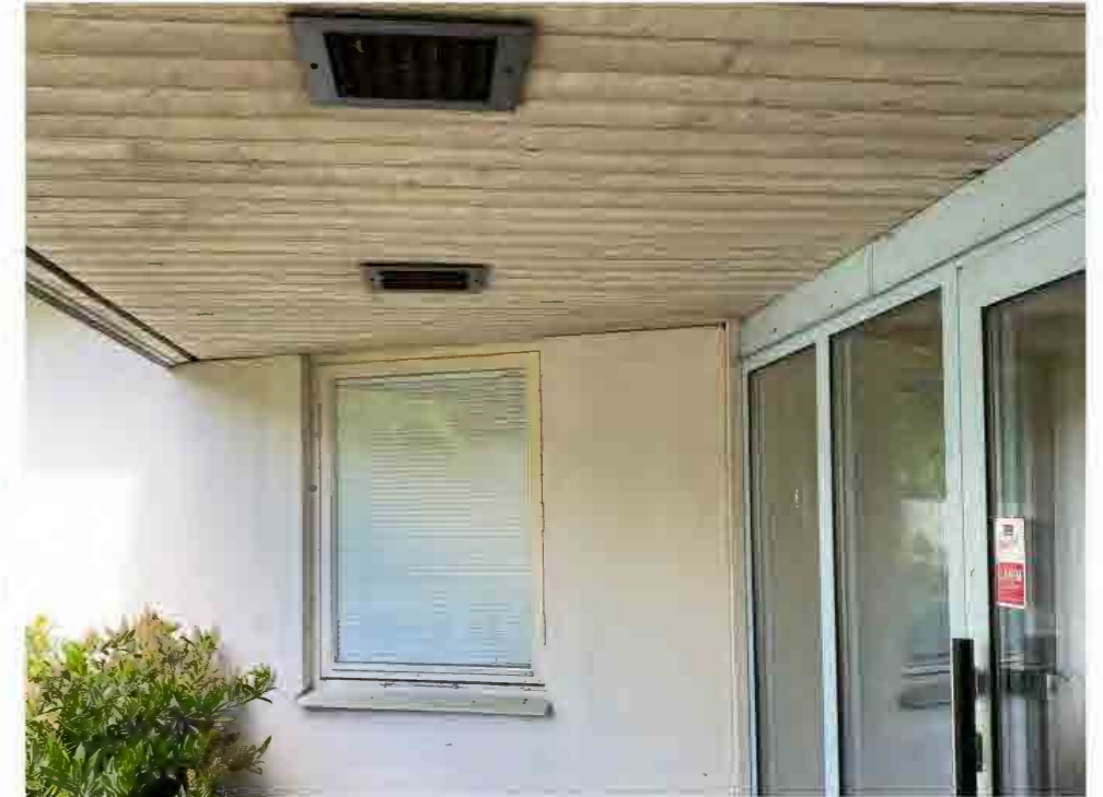
Undertak med träpanel och infällda armaturer.
