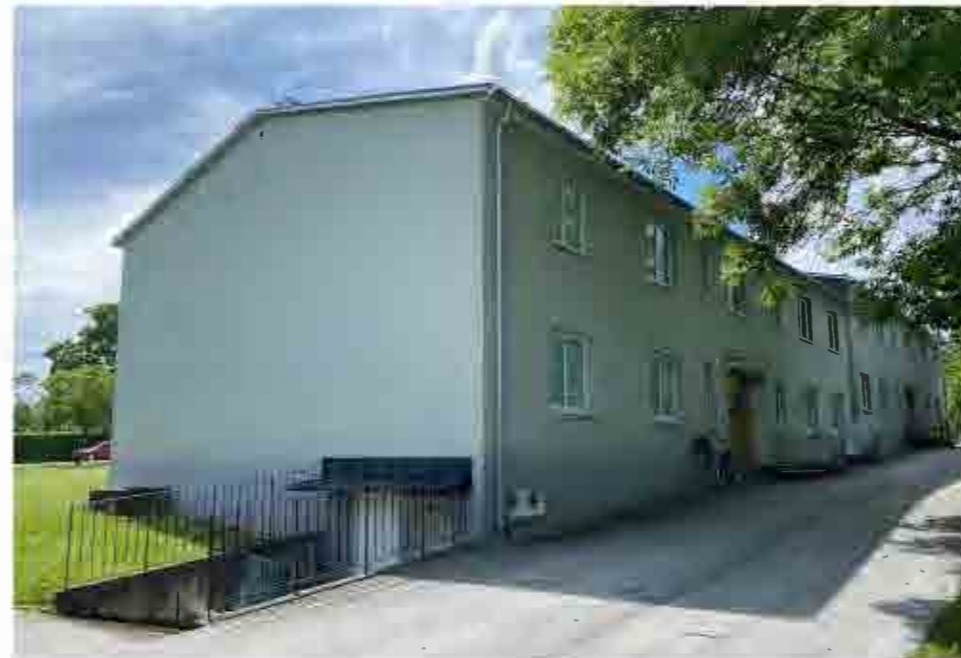
Huset som uppfördes 1966 har putsade fasader avfärgade i en grön kulör. Sockeln är också putsad och i liv med fasaden i övrigt och entréfasaden vetter mot väster.
