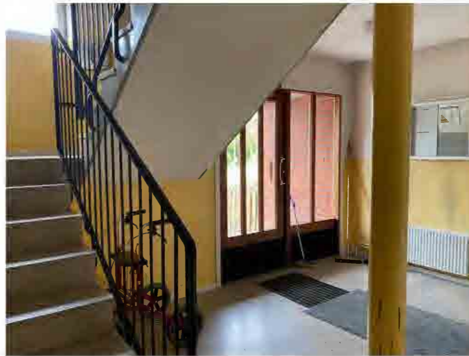
Trapphus med ursprunglig entréport. Golv samt trappornas plan- och sättsteg i kalksten, innanför entrén finns ett nedsänkt skrapjärn.
