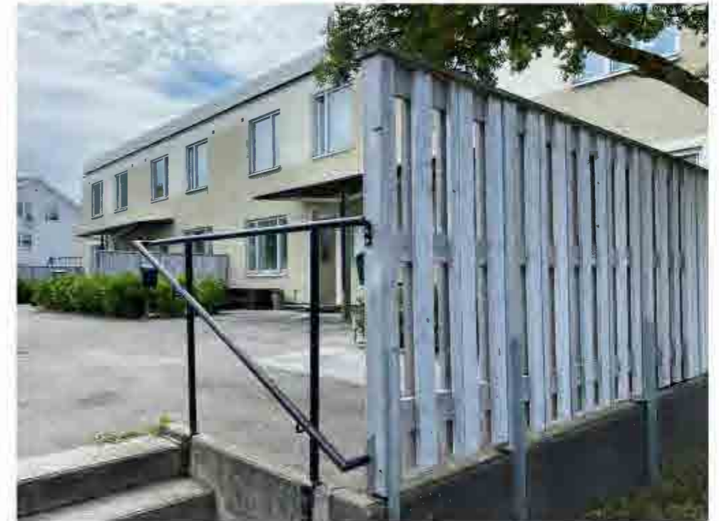
Detalj av trappa och insynsskyddande räcke.
