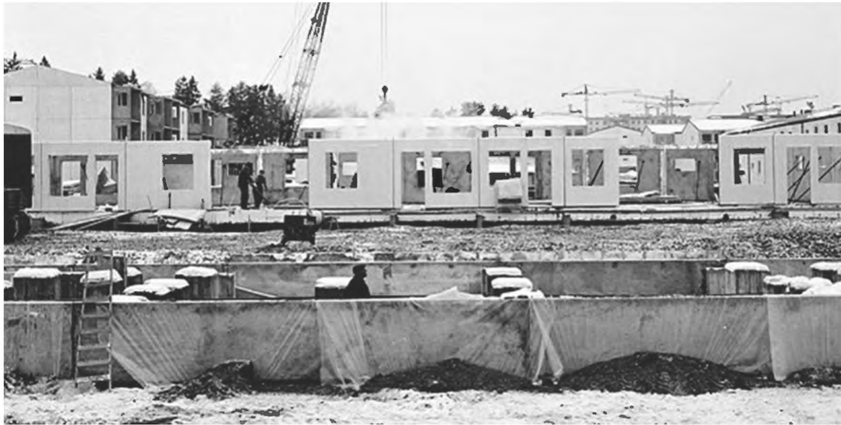
Prefabricerade betongelement lyfts på plats med kranar i Tensta, 1969. Källa: Stockholms stadsmuseum.
