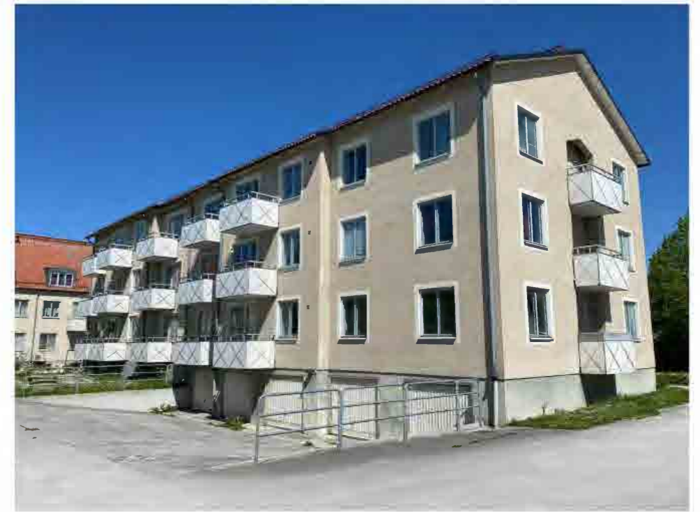
Fasad mot söder och parkeringen i centrala Hemse. Nedfart till garageutrymmen.
