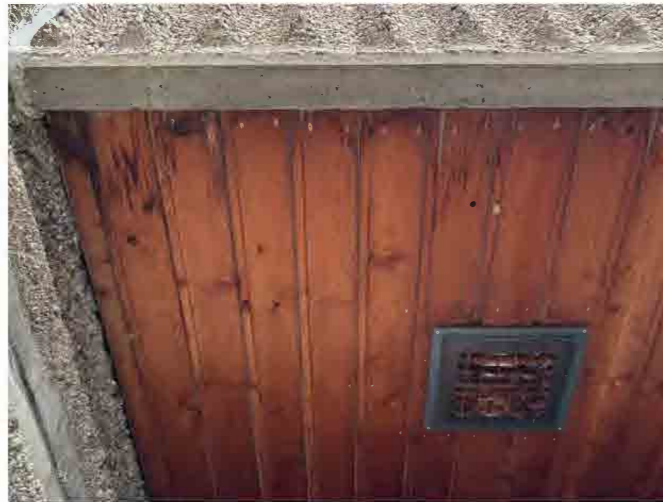
Detalj av undertak.
