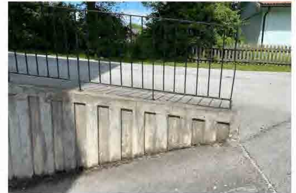
Ursprungligt räcke längs med nedfarten till husets garage, med spåren av gjutformen som dekorativt element i betongen.
