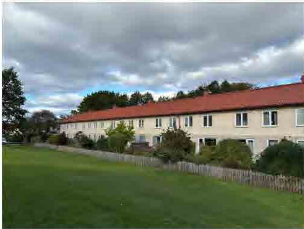
Vy längs med en av huskropparnas fasader mot gården.
