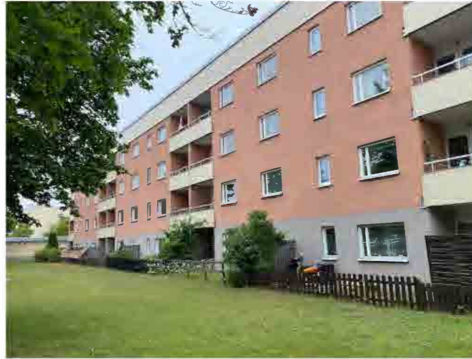
Balkongerna ligger indragna från fasadliv. Bottenvåningens lägenheter har en liten uteplats i markplan.
