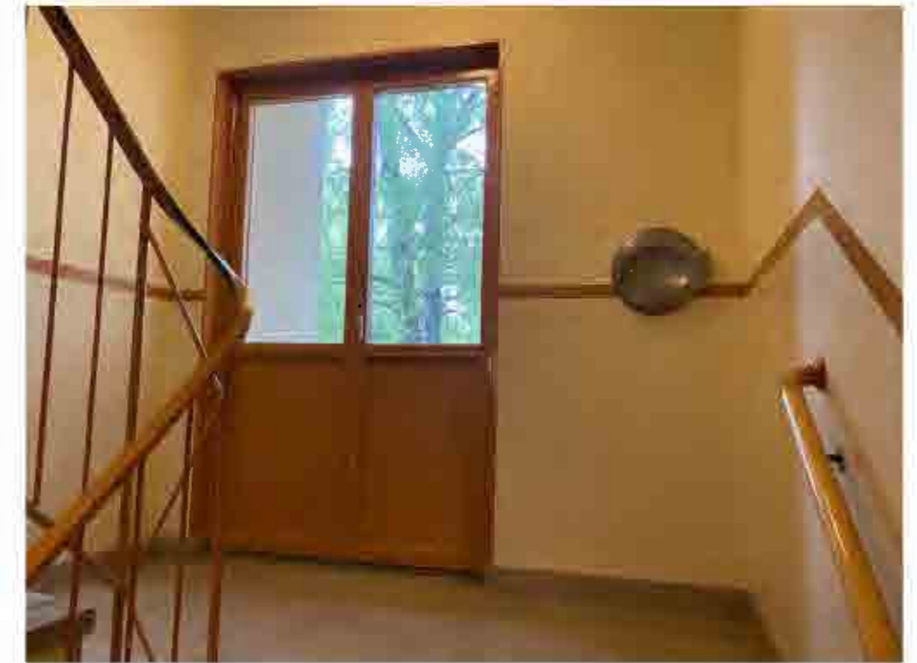
Bevarad, ursprunglig balkongdörr till gemensam piskbalkong. På bilden syns också luckan till sopnedkast.
