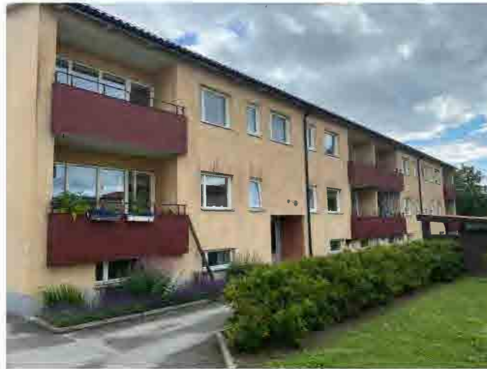
Balkongfronter i sinuskorrugerad plåt med överliggare i svart metall.
