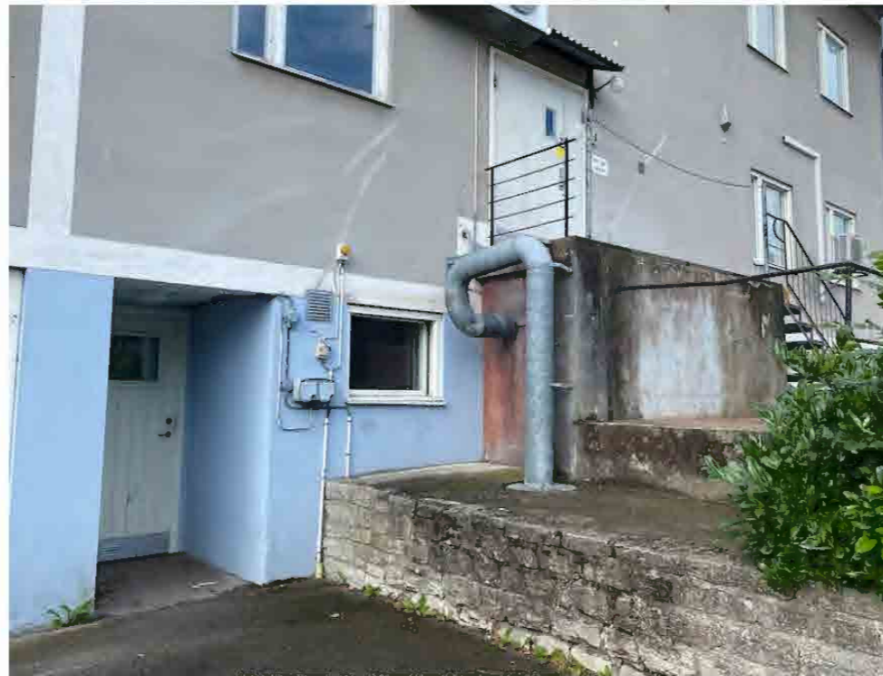
Stödmur i sten invid lastkaj. Dörr till källarutrymme.
