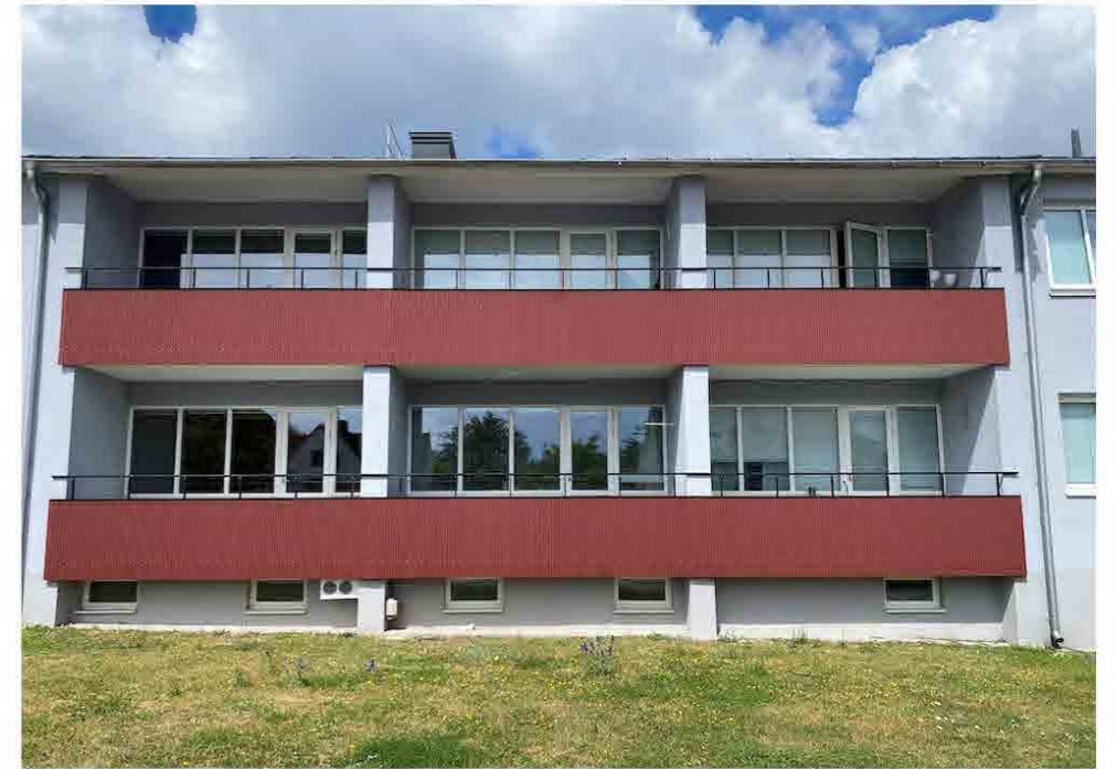
Lägenheterna mot Backvägen har generösa balkonger. Samtliga fönster och dörrpartier är utbytta.
