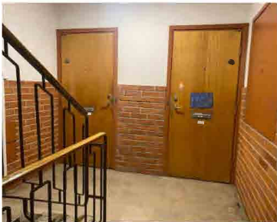
Trapphusen har fått bibehålla sina ursprungliga dörrblad. Väggarna har en bröstning i rödtegel.
