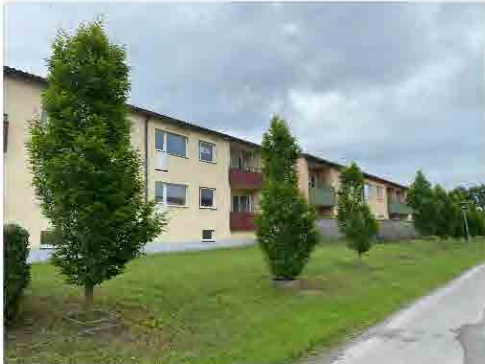
Bostadshuset har både balkonger indragna från fasadliv och franska balkonger.
