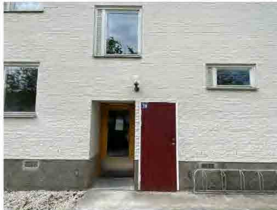
Exempel på ursprunglig entréport i trä, med sparkskydd i plåt.
