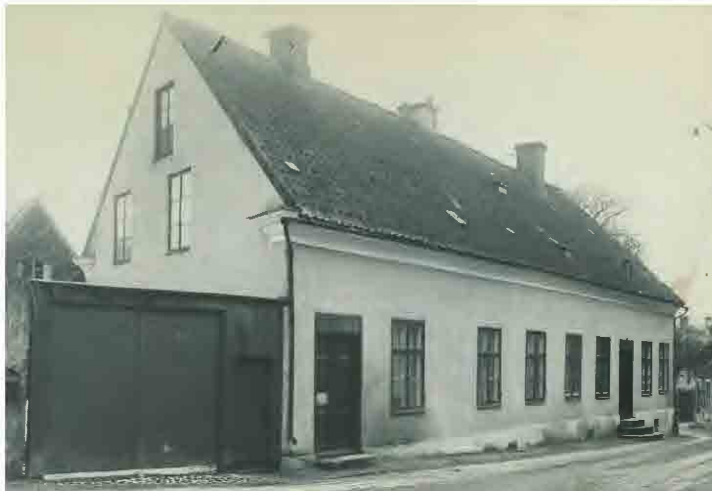
Fasaden utmed Smedjegatan innan renoveringen och ombyggnationen till lägenheter inleddes. Källa: Gotlands Museums arkiv.
