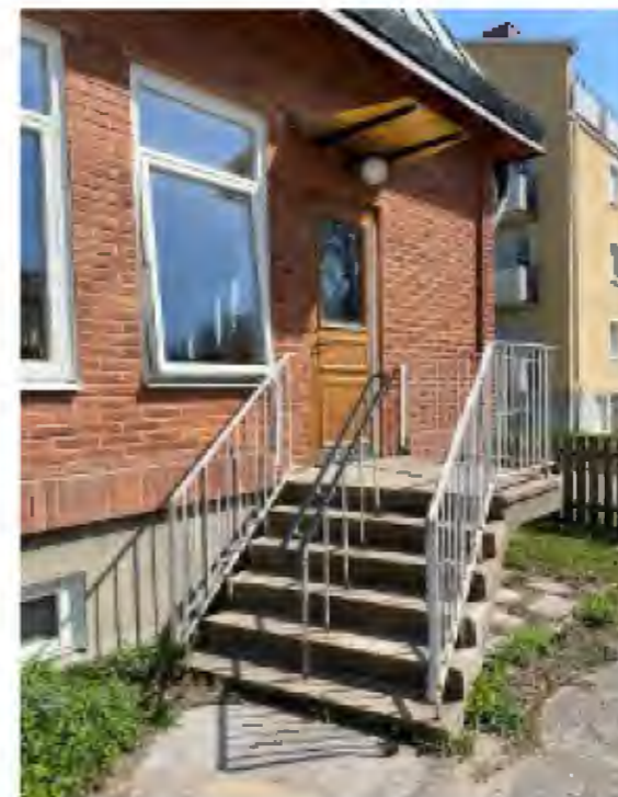
Huset har kvar många ursprungliga byggnadsdelar, som baksidornas trappor, dörrblad och det lilla skärmtaket. Fönstren är nyligen utbytta.
