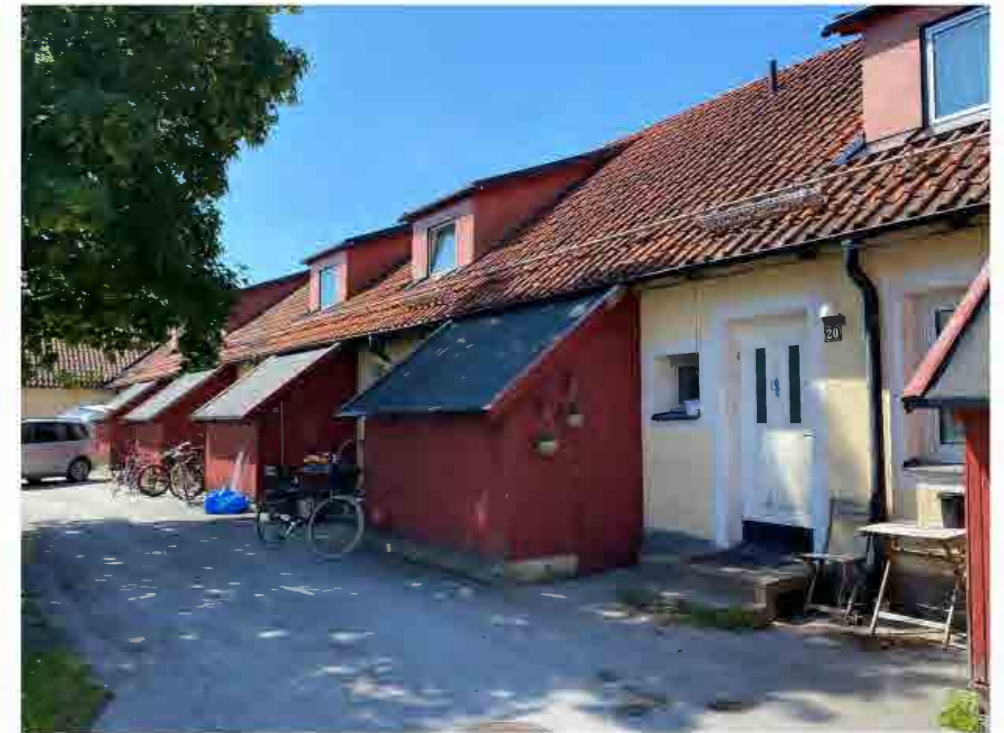
Invid bostadshusens entréer finns vidbyggda förråd i rödmålad panel med pappklädda, branta pulpeltak. Tilläggsisoleringen har medfört att såväl entrédörrar som fönster ligger indragna från fasad.
