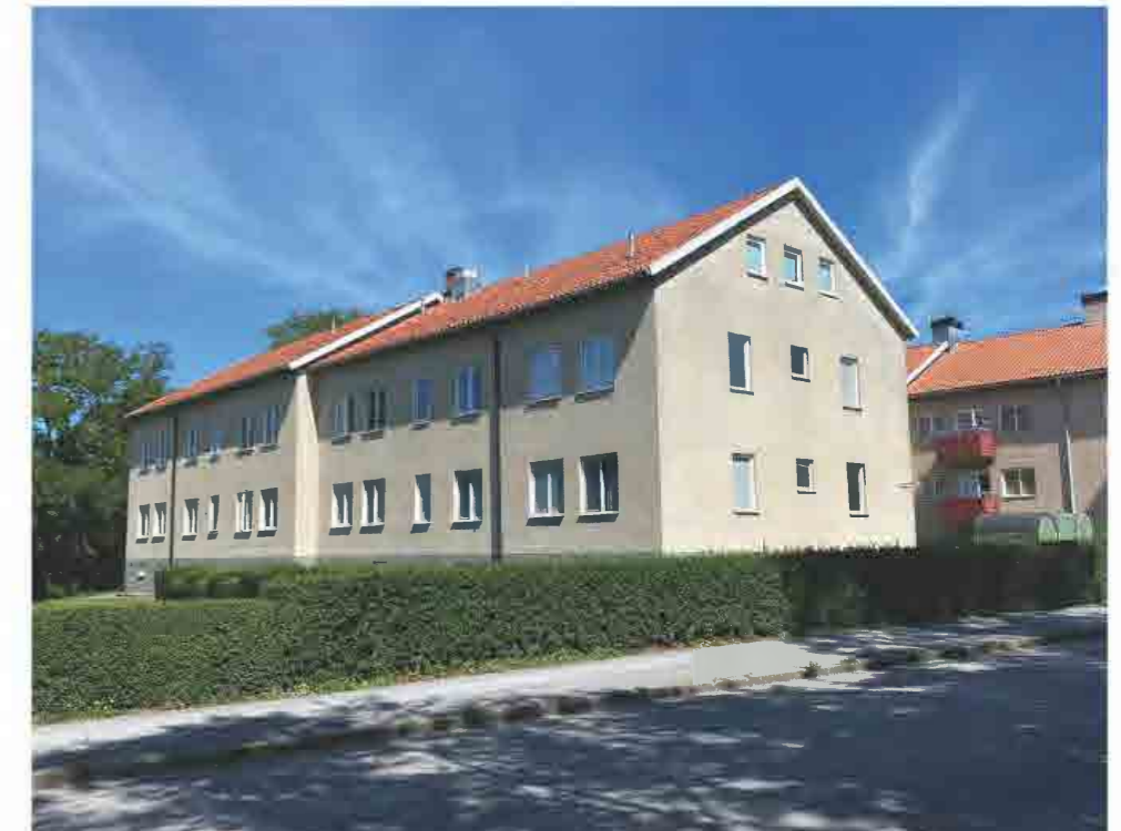
Bostadshusets fasad åt väster, med gaveln åt söder.
