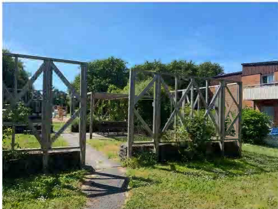
Gestaltad utemiljö med låga kalkstensmurar, spaljéer och pergola.
