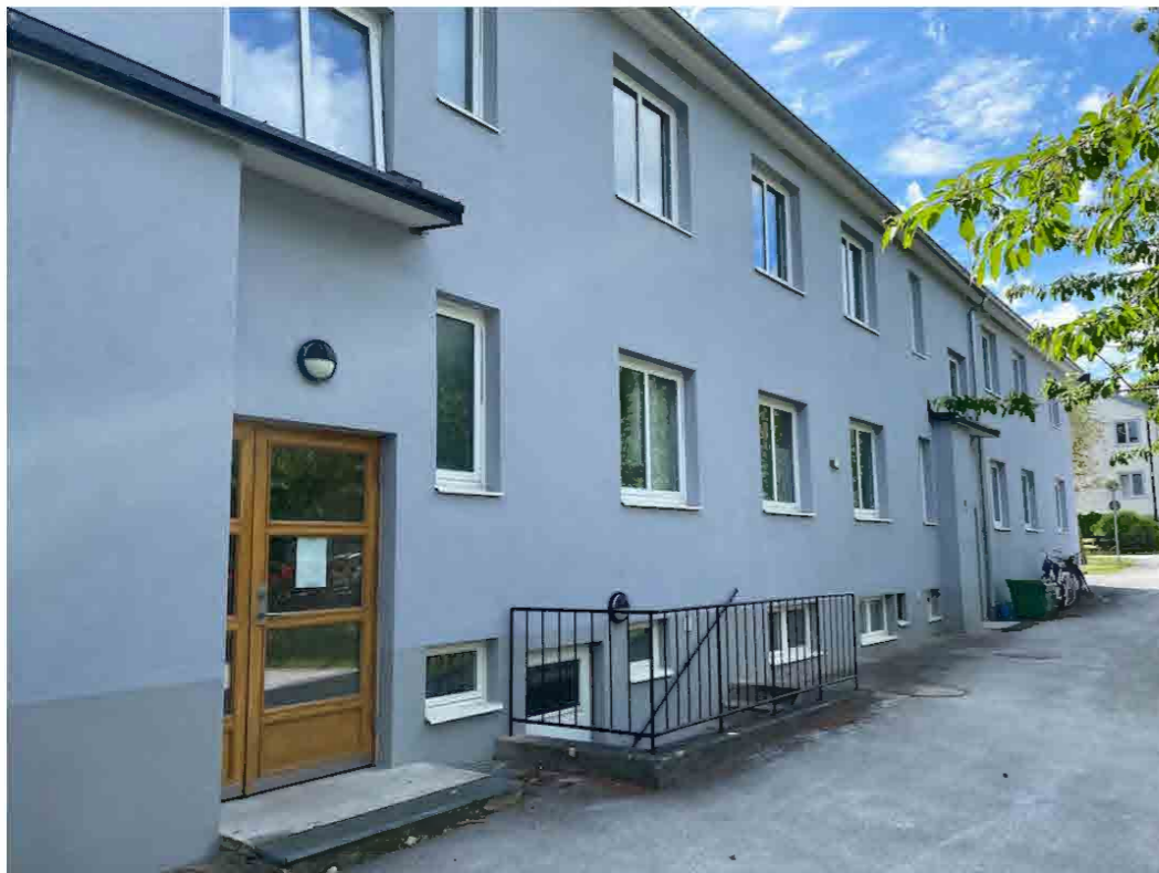
Entréfasaden vetter in mot fastigheten. De ursprungliga entréportarna har bibehållits, liksom de äldre smidesräckena till källartrappan.
