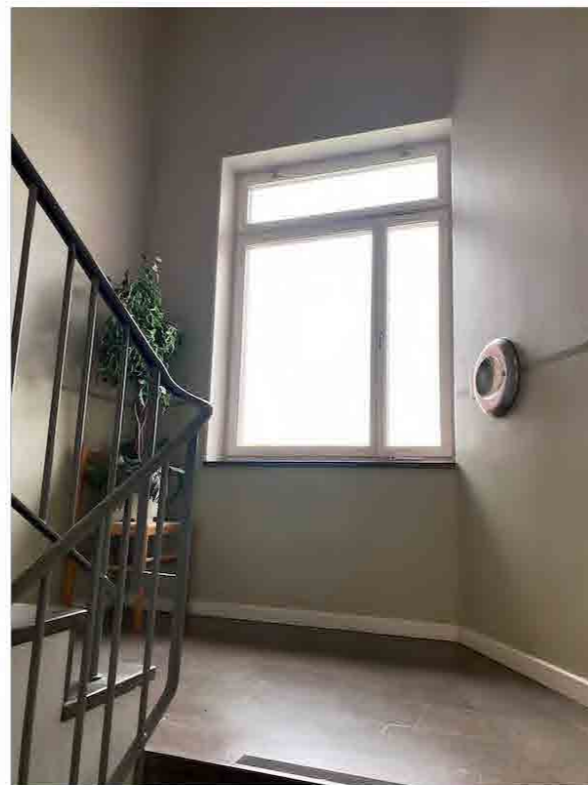
Trapplopp med ursprungligt fönster och lucka för sopnedkast.
