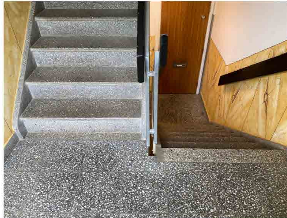
Trapphusens golv, vangstycken samt plan- och sättsteg är utförda i terrazzo.
