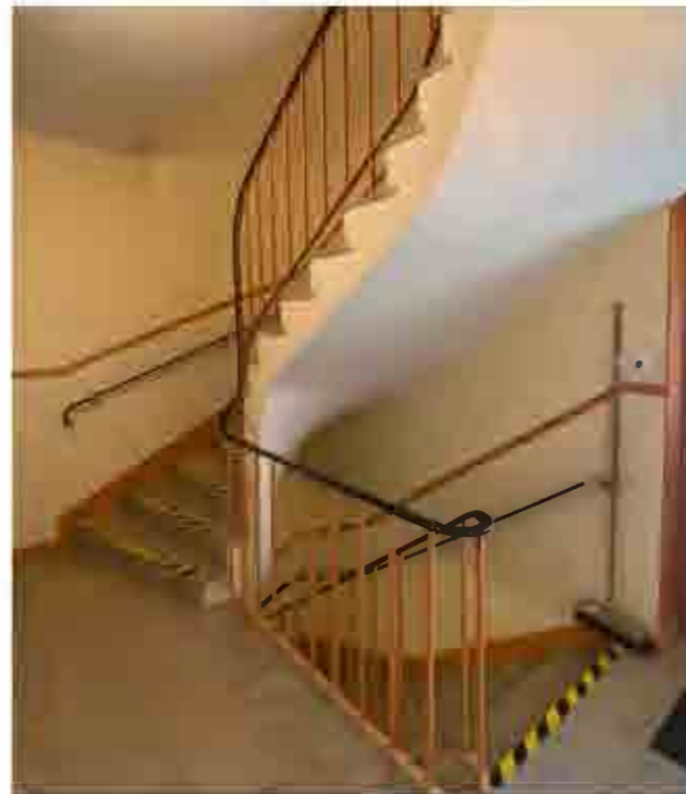
Tidstypiskt trapplopp med smidesräcken med överliggare i krympplast.
