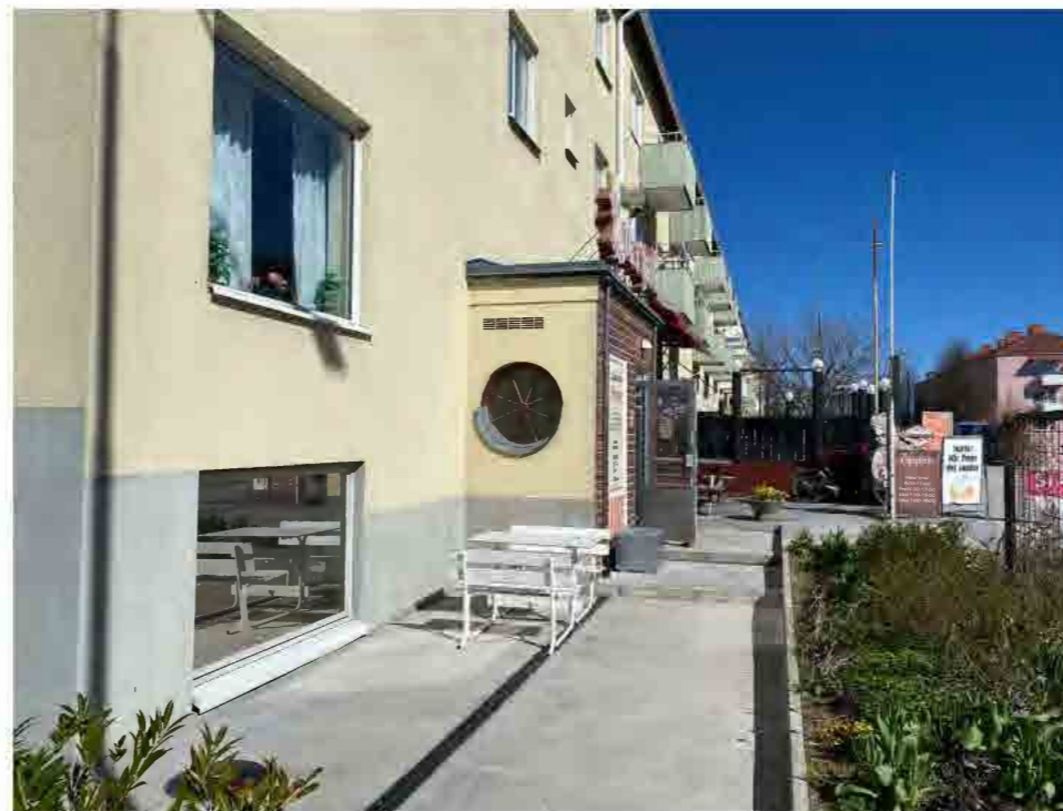
Entréparti med ursprungligt runt fönster, Konditori Norrgatt. Den äldre kalkstensläggningen har ersatts av en gjuten stenimitation.
