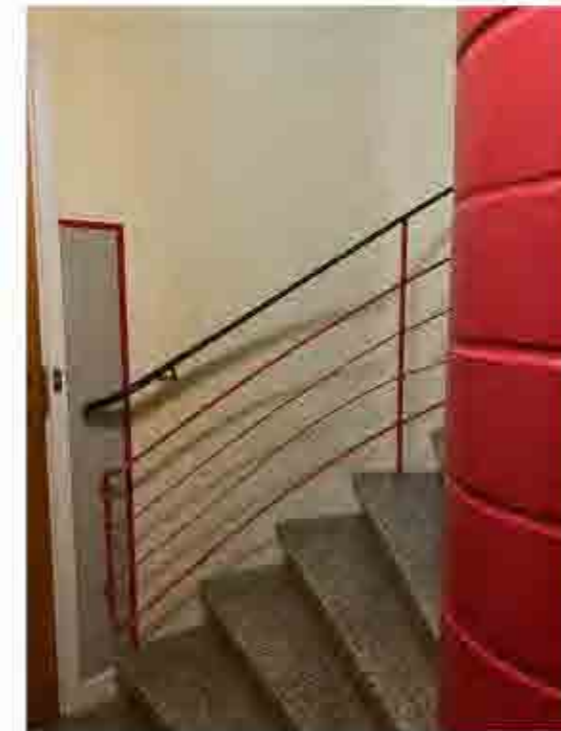
Trappornas plan- och sättsteg i grå terrazzo.
