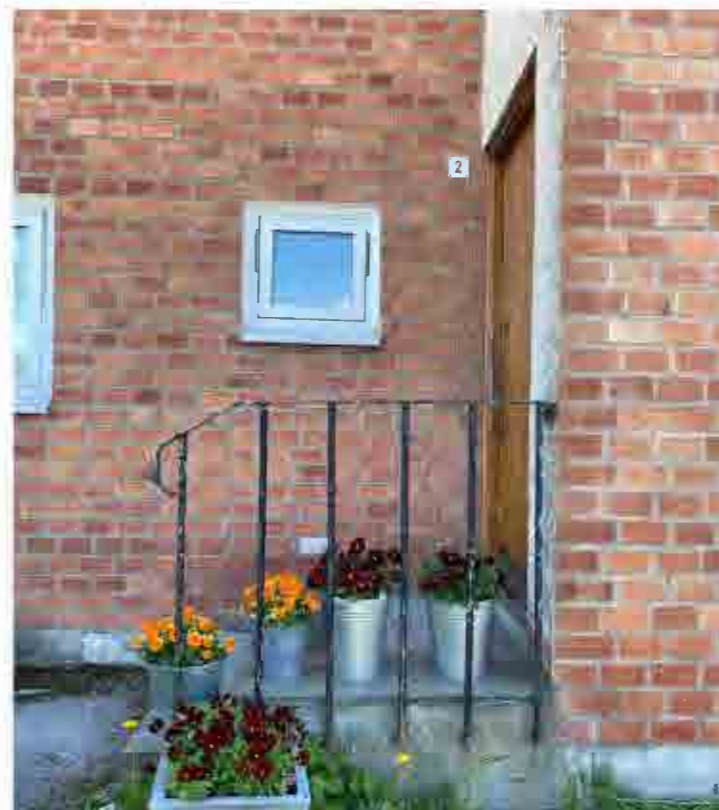
Ursprungligt räcke upp till entré.
