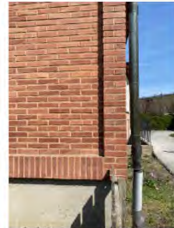
Tegelfasaderna har en murad ram, som diskret dekorativt inslag.
