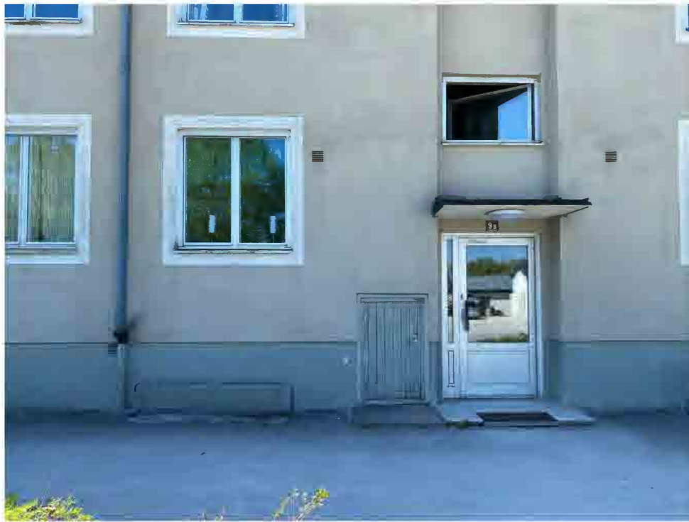
Husens fönster är utbytta till båg- och karmar i lättmetall.
