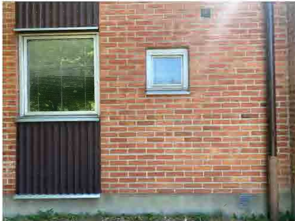
Byggnadens fönsteraxlar är markerade i fasad med bröstning i brun plåt.
