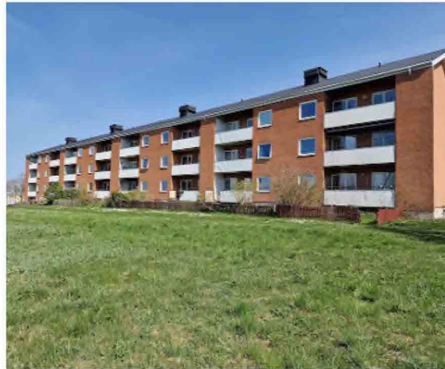
Lägenheternas balkonger ligger indragna från fasadliv, med fronter i plåt.
