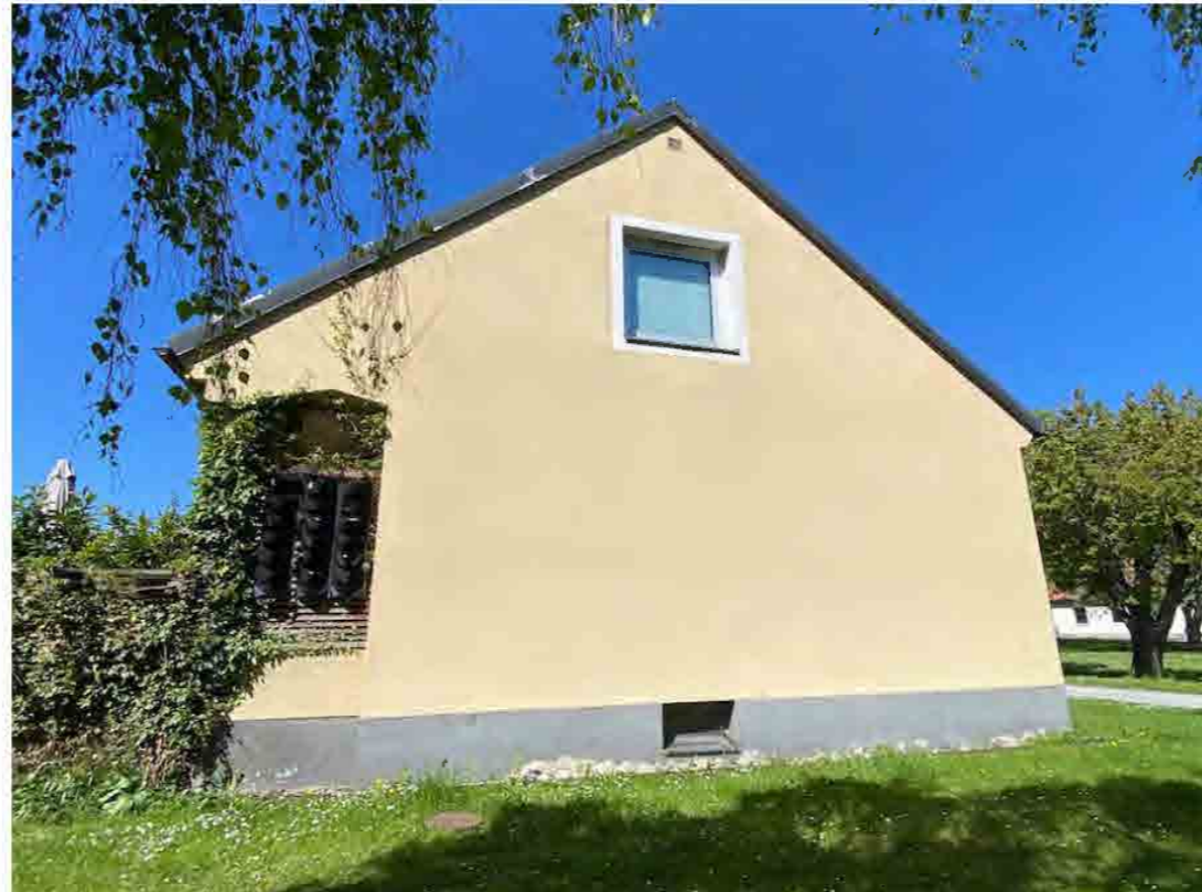
Kedjehusets ena gavel. Fasaden är tilläggsisolerad och putsad. Fönstret i gavelröset är utbytt och har båg och karm i lättmetall.
