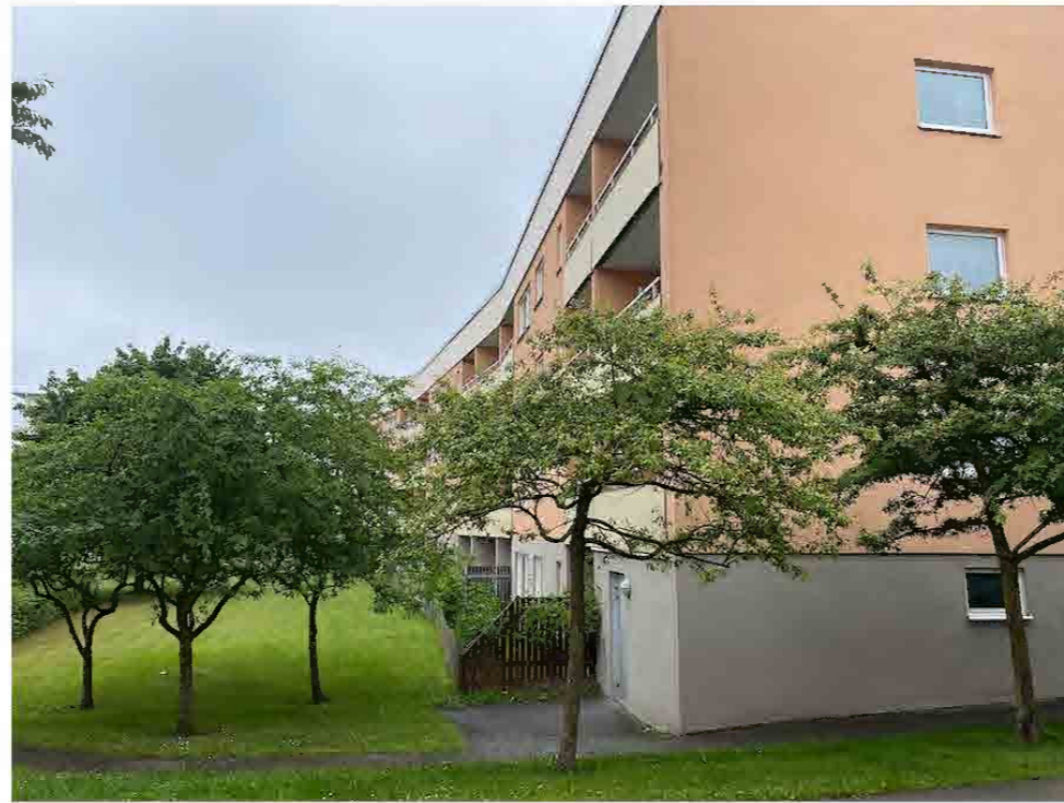
Ett av de krökta bostadshusens fasader mot gemensam innergård.
