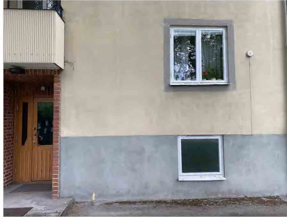
Entré till trapphus och ovanförliggande gemensam piskbalkong.
