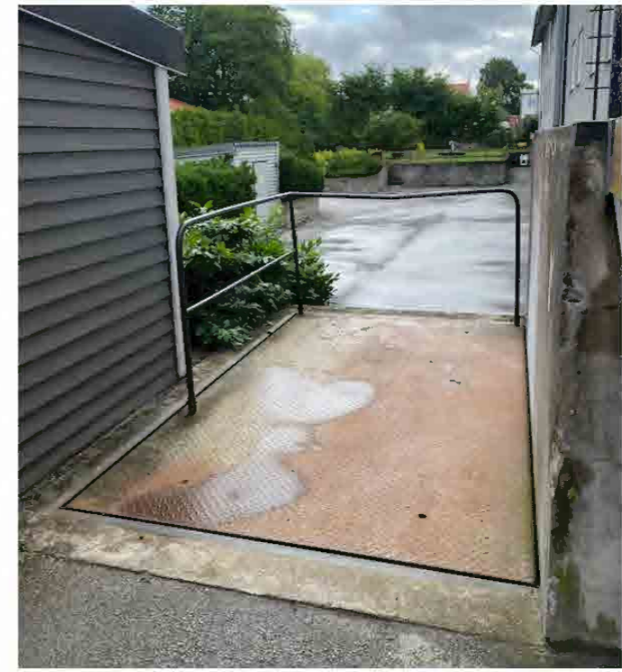
Plattformshiss med smidesräcke i anslutning till lastkaj.
