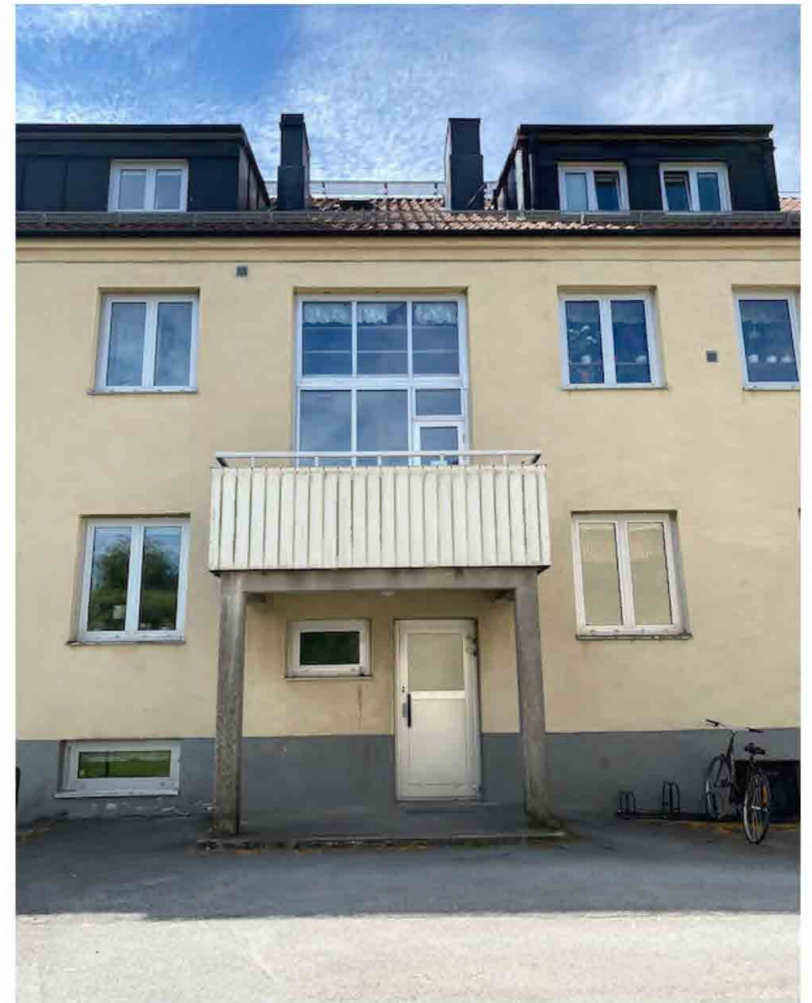
Det ursprungligen mycket välgestaltade balkongpartiet har genom ovarsamma byten av byggnadsdetaljer fått ett helt annat uttryck.
