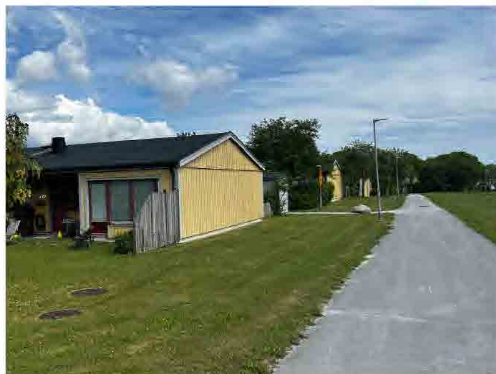
Fastighetens bostadsbebyggelse utgörs av låga enplanshus med fasader klädda med gulmålad panel under flacka sadeltak klädda med svart plåt.
