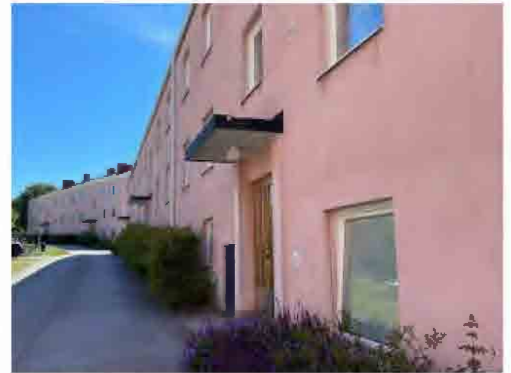
Kvarterets entréfasader mot innergården, med planteringar närmast fasad.
