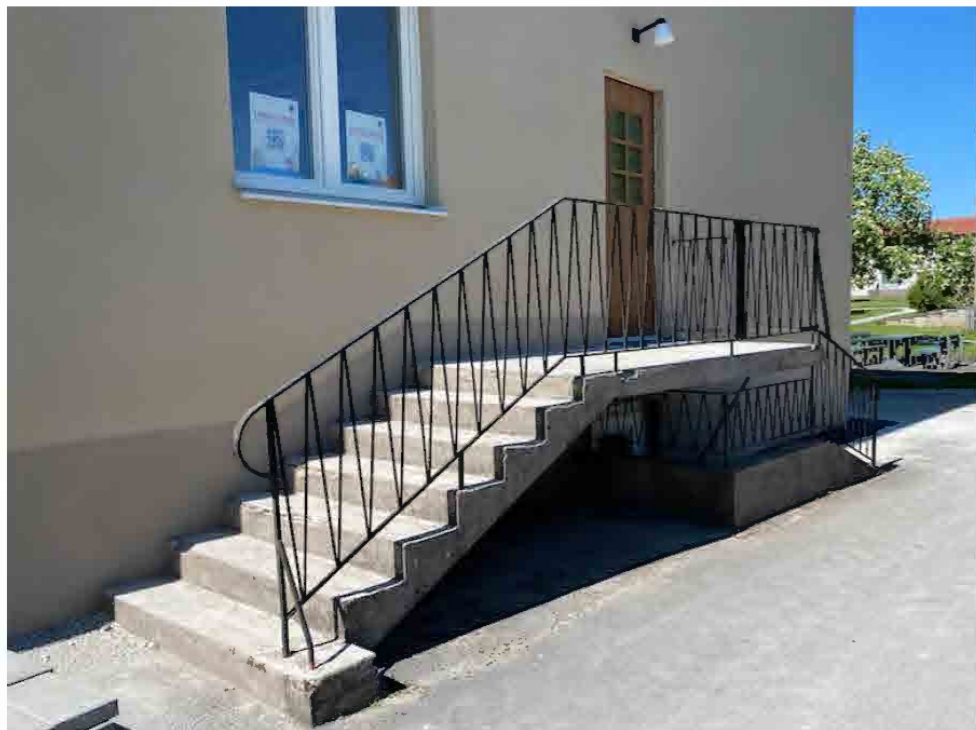
Trappa på gaveln med ursprungligt, tidstypiskt räcke.
