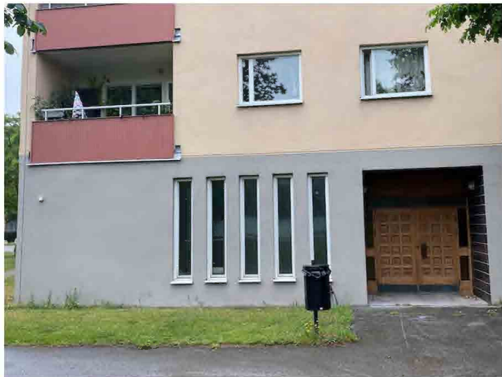
Läget för kyrkolokalen som ursprungligen fanns i kvarteret är fortfarande läsbart i fasad, med höga smala fönster och omsorgsfullt gestaltad entréport i trä.
