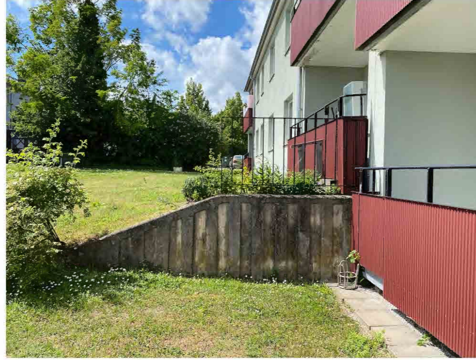
Till stödmuren mellan den högre respektive den lägre belägna huskroppen har samma typ av gjutform som vid garagedriften använts.
