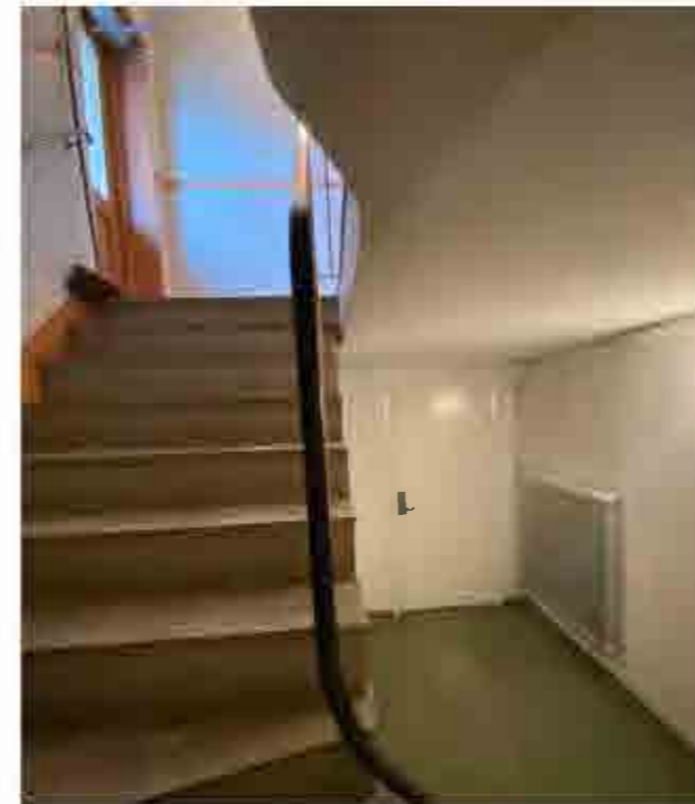
Källartrappa och tak av brädgjuten betong.
