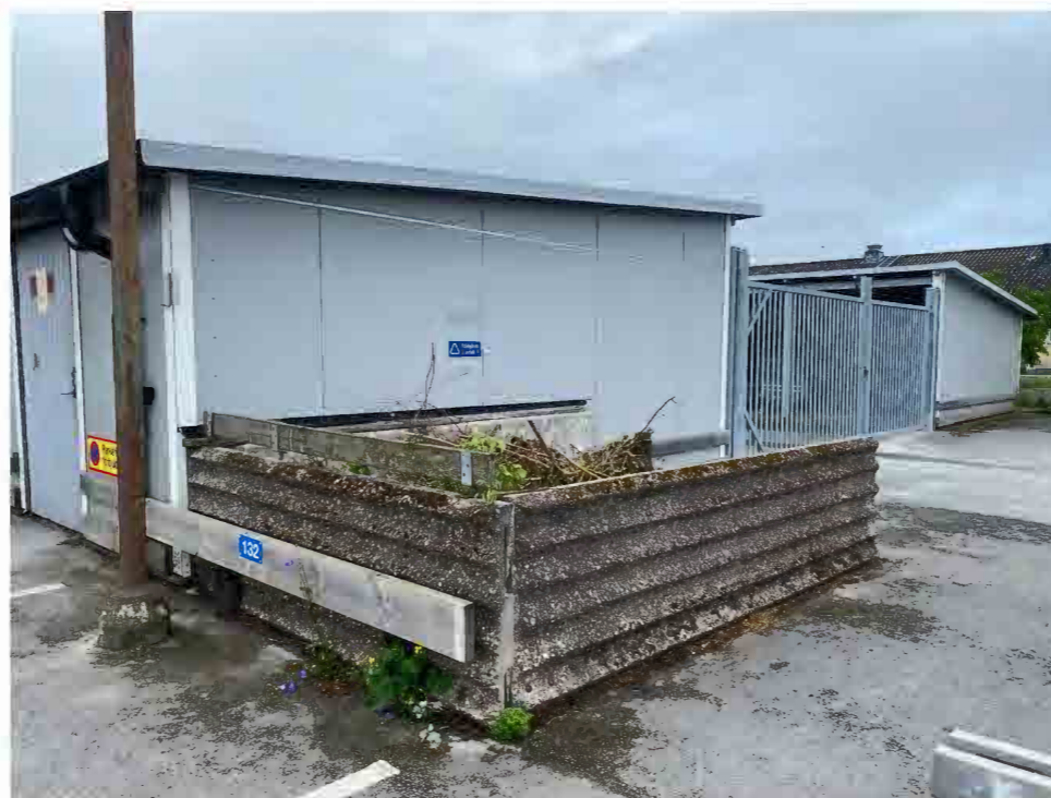
Kompoststation i formgjuten sjöstensbetong.
