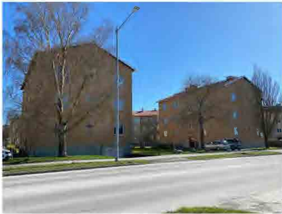
Byggnadskropparna sedda från norr, längs Lummelundsväg.
