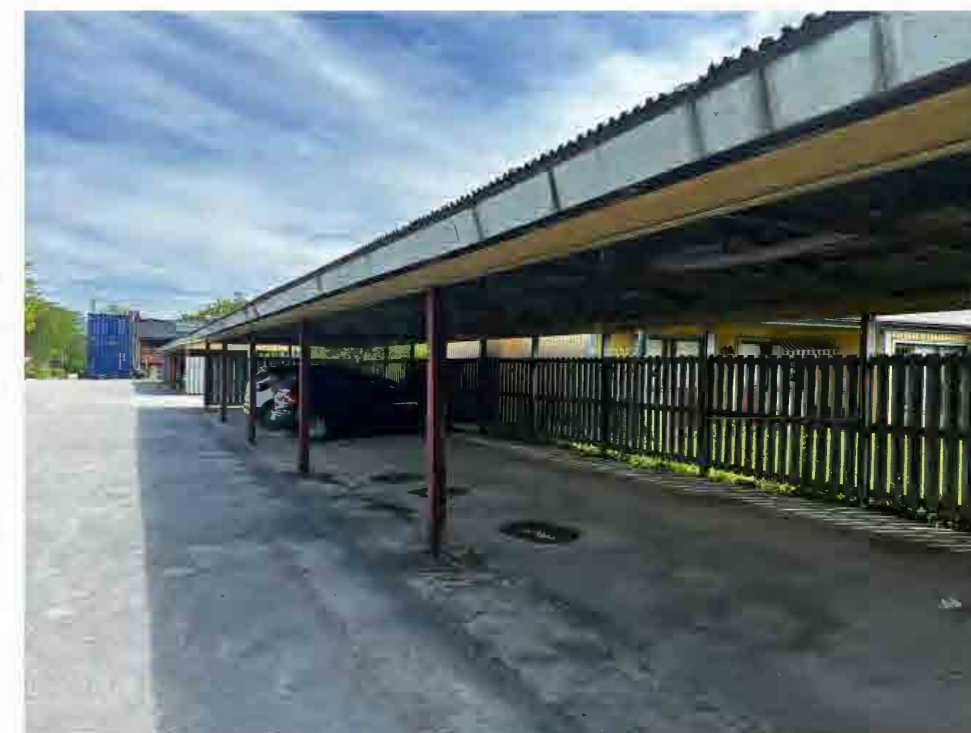
I anslutning till bostadshuset finns en carportlänga med glesmonterad panel åt tre väder- streck. Taket bärs av en fackverkskonstruktion i metall.
