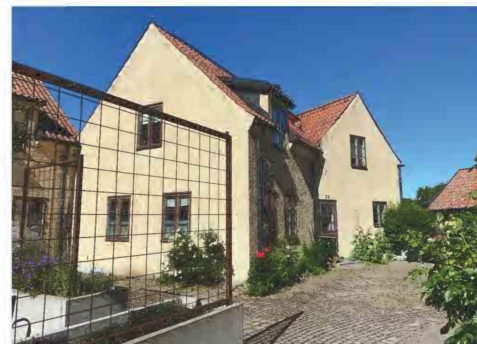
Gårdshusets fasader mot den stenlagda innergården.
