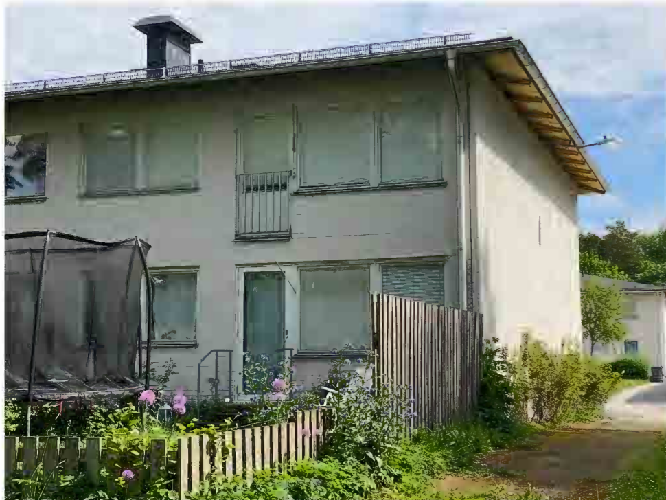
Utbytta fönster i lättmetall.
