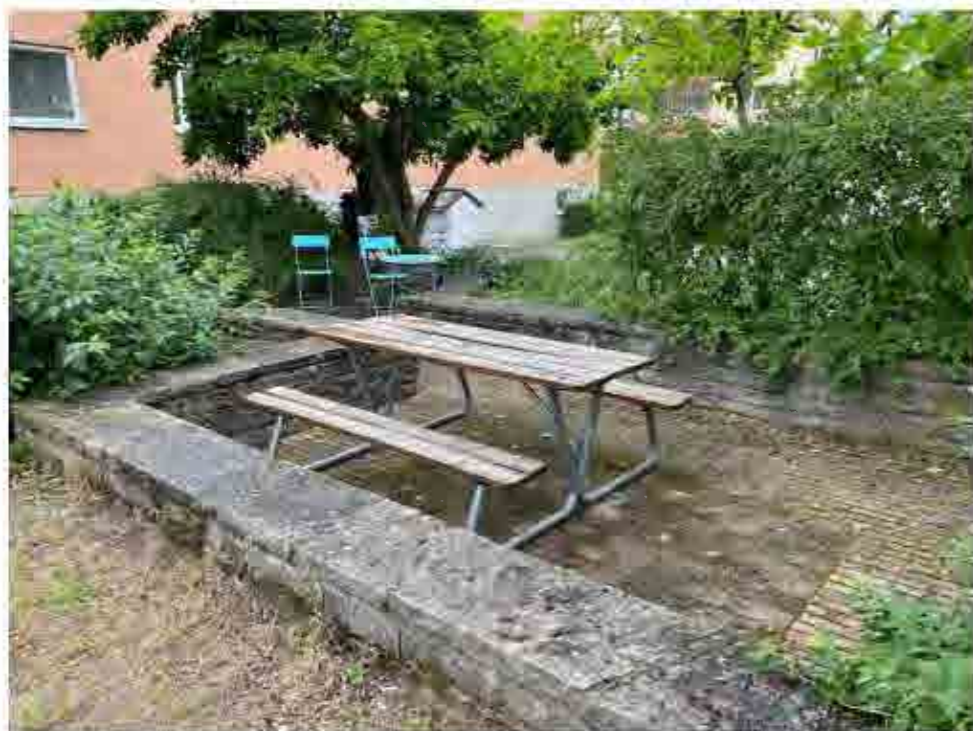
Gestaltad uteplats med stenläggning och stödmurar i kalksten.
