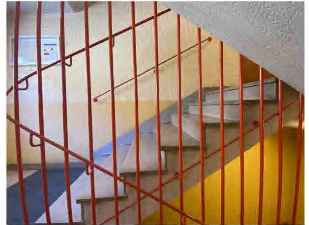
Karaktäristiskt smidesräcke i trapphuset, målat kulört rött.
