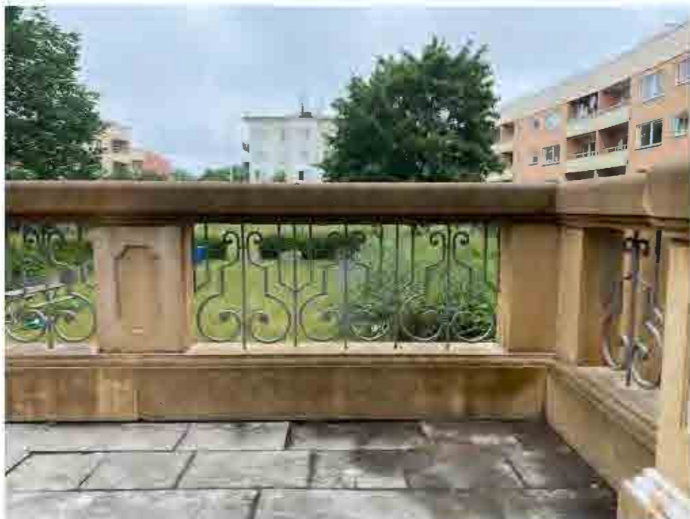
Del av balustraden med formgjutna överliggare och bärande delar, och dekorativt smidesrärke.
