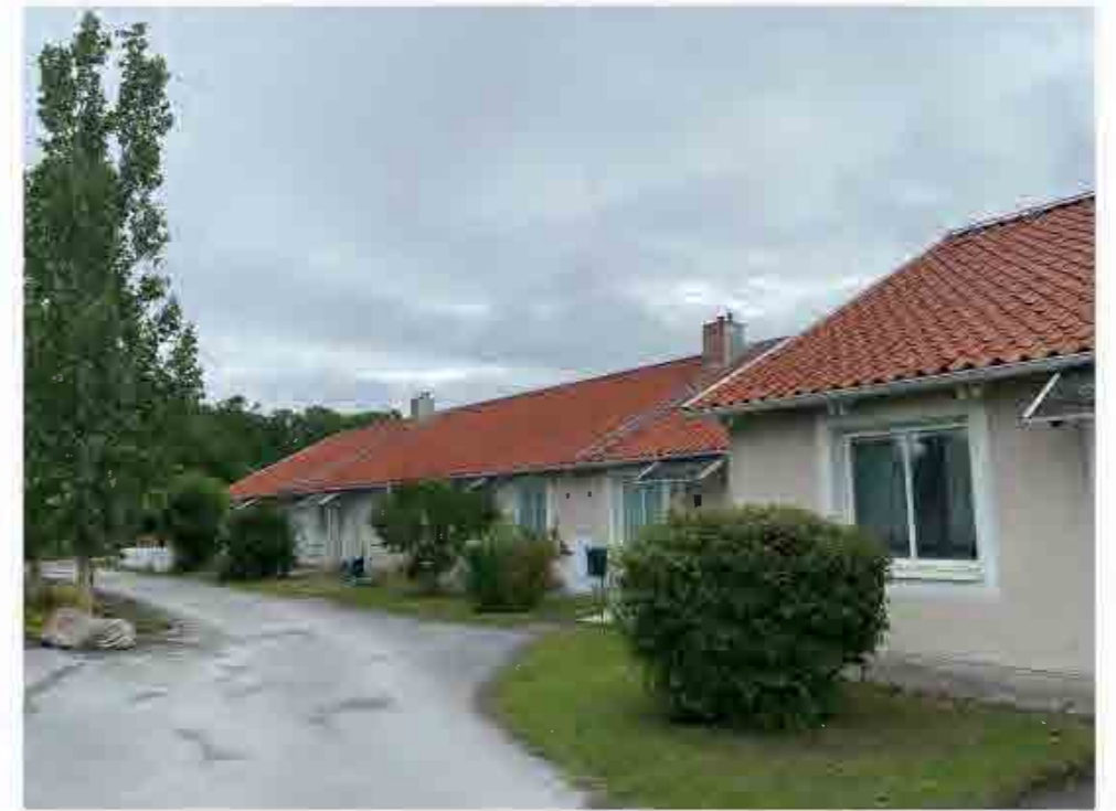
Asfalterad gångstig framför entréer. Huskropparna är placerade förskjutna till varandra.
