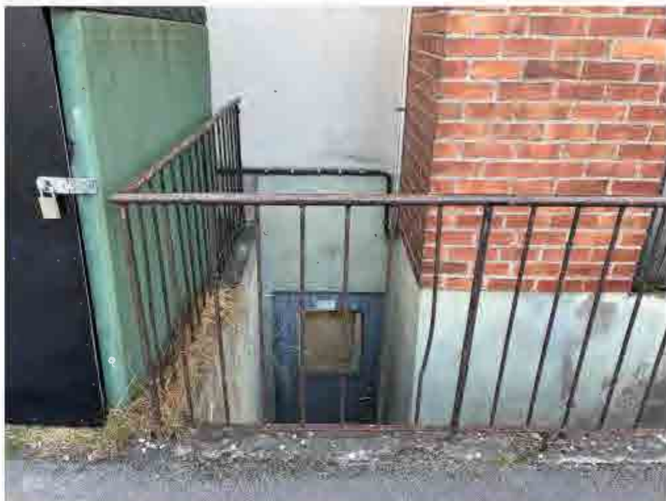
Ursprungligt smidesräcke och källardörr intill pannskorstenen i rödtegel.
