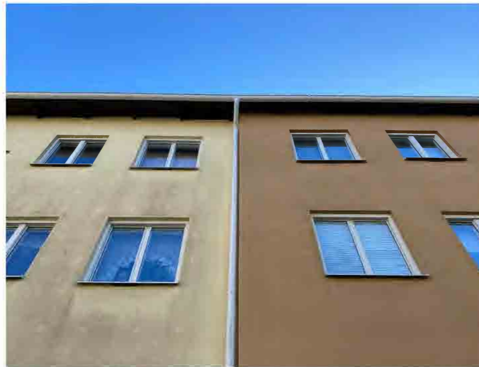
Olika putskulörer och inplåtade fönster.
