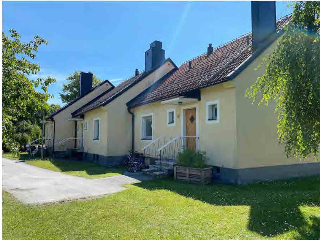
Bostadshuset utgörs av tre sammanbyggda, och i förhållande till varandra förskjutna, enheter under sadeltak klätt med enkupigt tegel.
