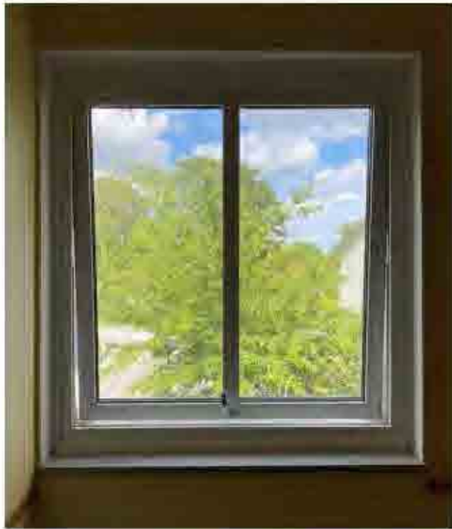
Samtliga fönster är utbytta till pivothängda aluminiumfönster.
