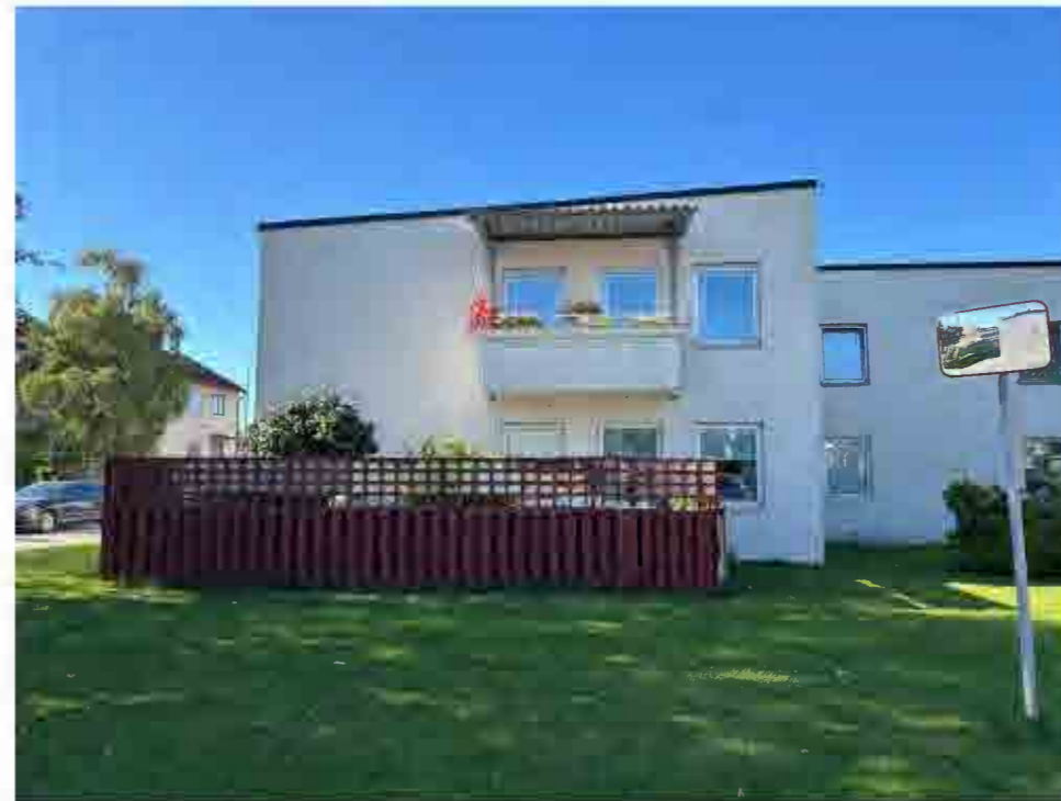
Husen har flacka tak, och har sekundärt kompletterats med balkonger i glasfiber.
