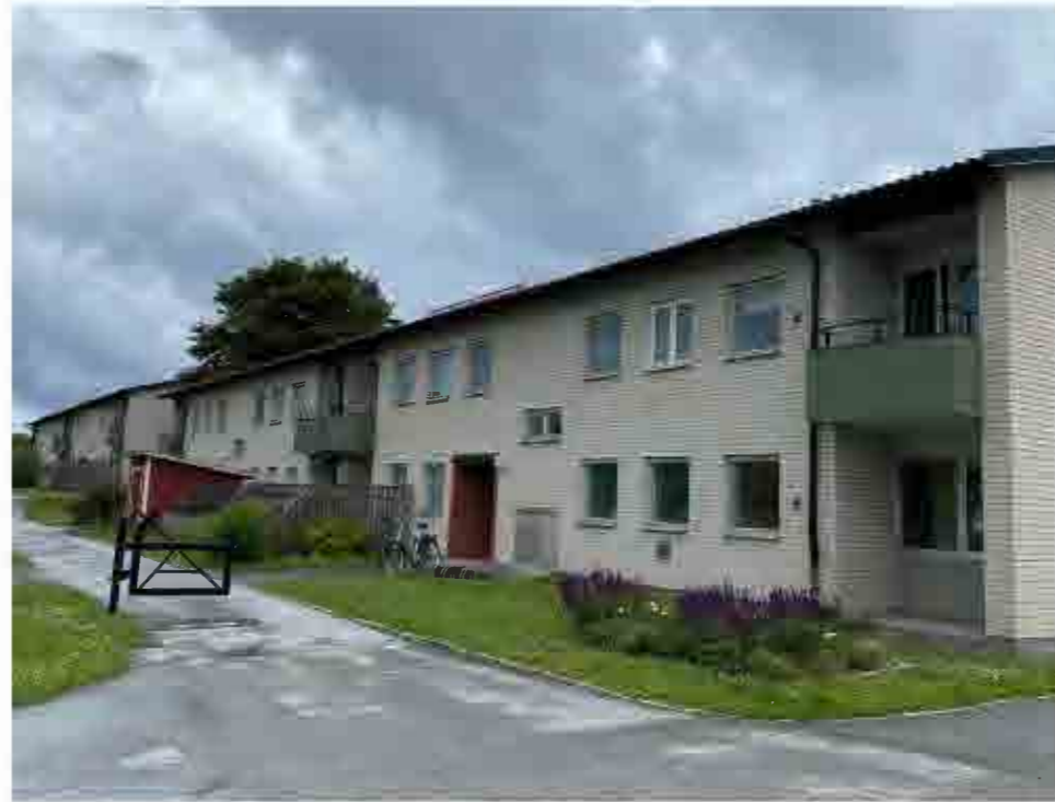
Entréfasaden murad i kalksandsten.
