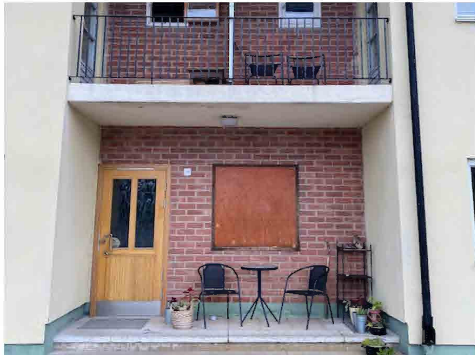
Ursprungligt entréparti, med igensatt fönster.
