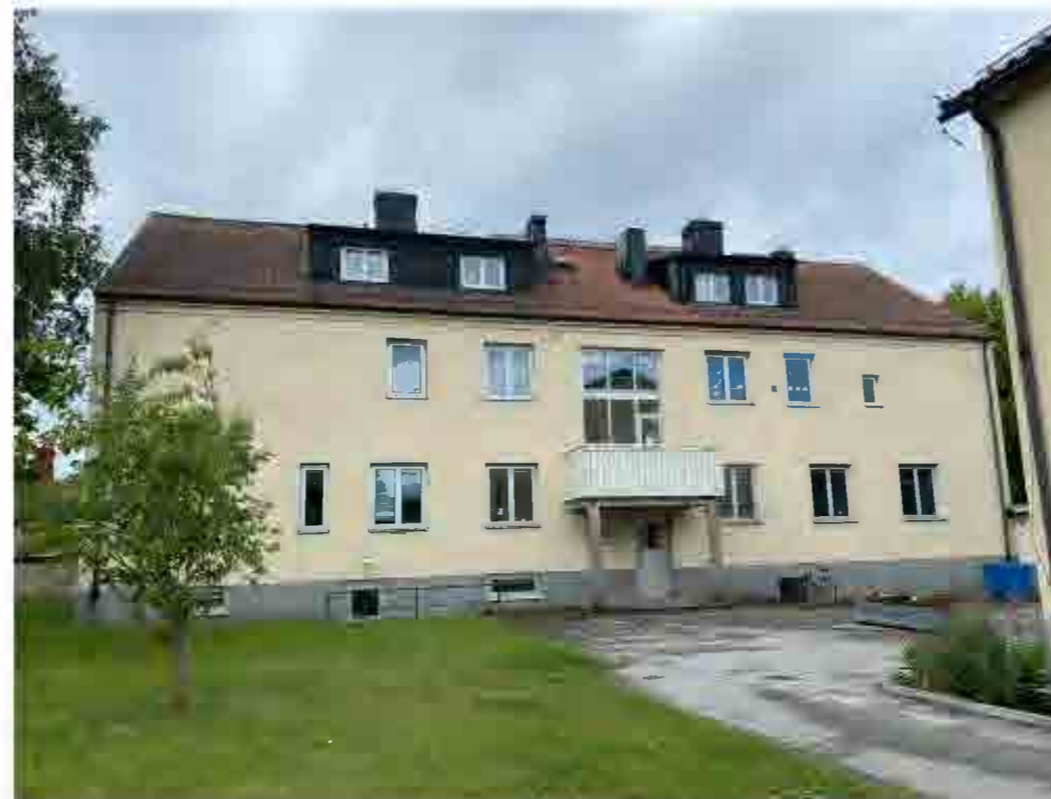
Gårdsfasaden. Fönster, dörrblad och balkongfronten är utbytt till varianter i lättmetall med grövre dimensioner och förenklad profilering.
