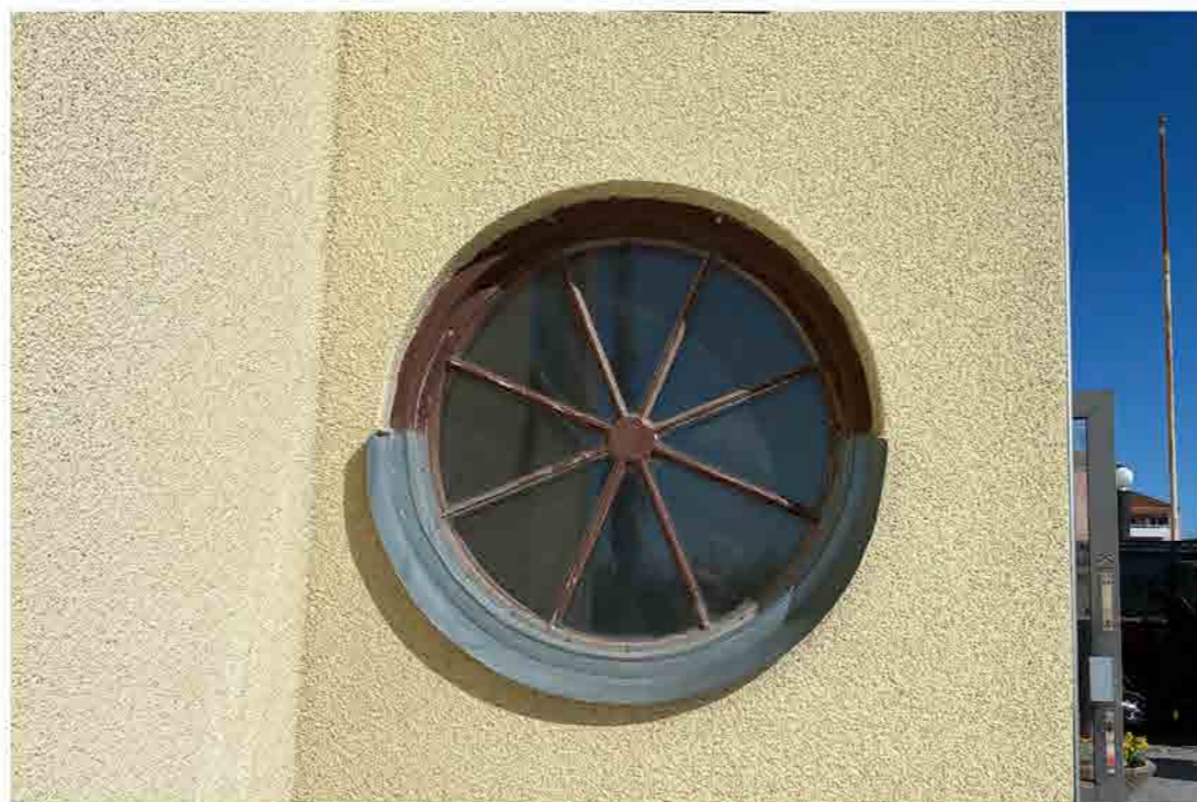
Detaljbild runt fönster i vindfånf vid Norrgatt.
