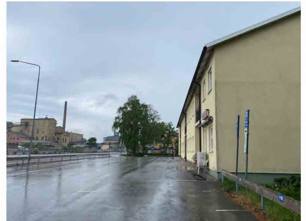
Vy längs med fasaden med det gamla sockerbruket i bakgrunden.
