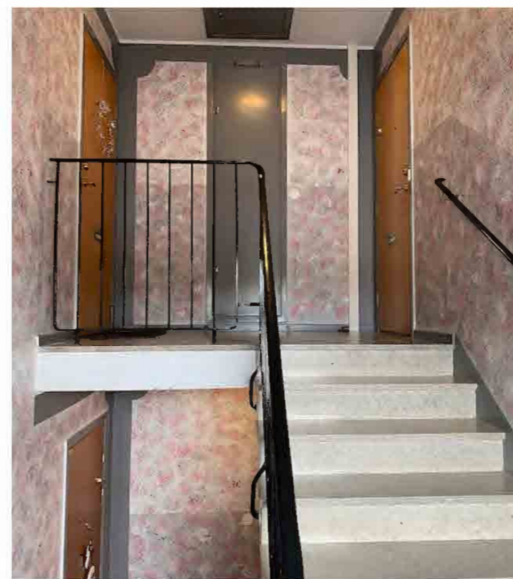
Högst upp i trapphuset finns en taklucka som nås via en steg infälld i väggsåpet strax intill.
