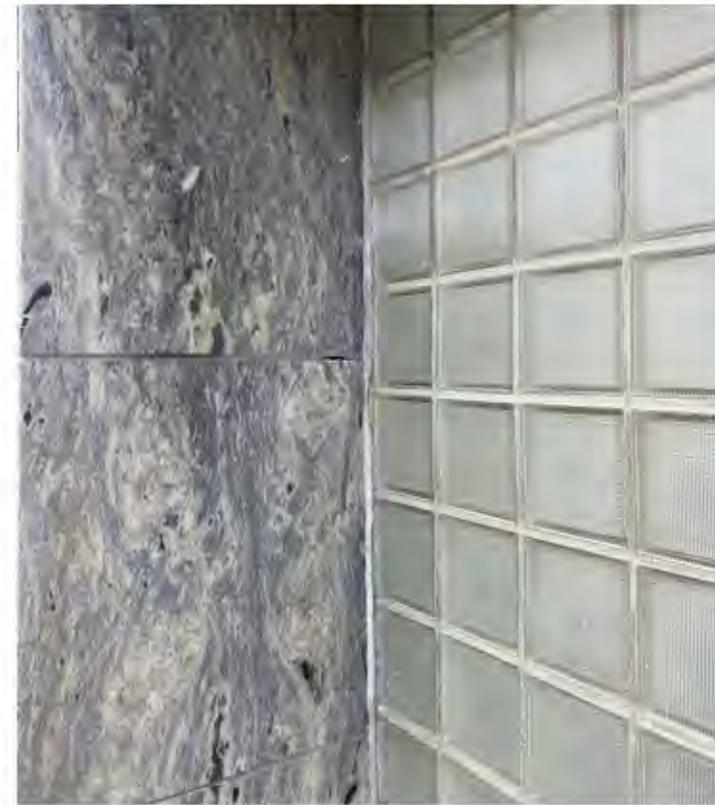
Möte mellan glasbetong och entrénischens stenskivor.
