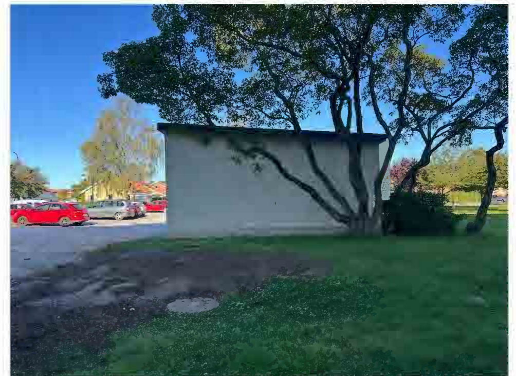
Områdets parkering och garagebyggnad med flackt pulpettak.
