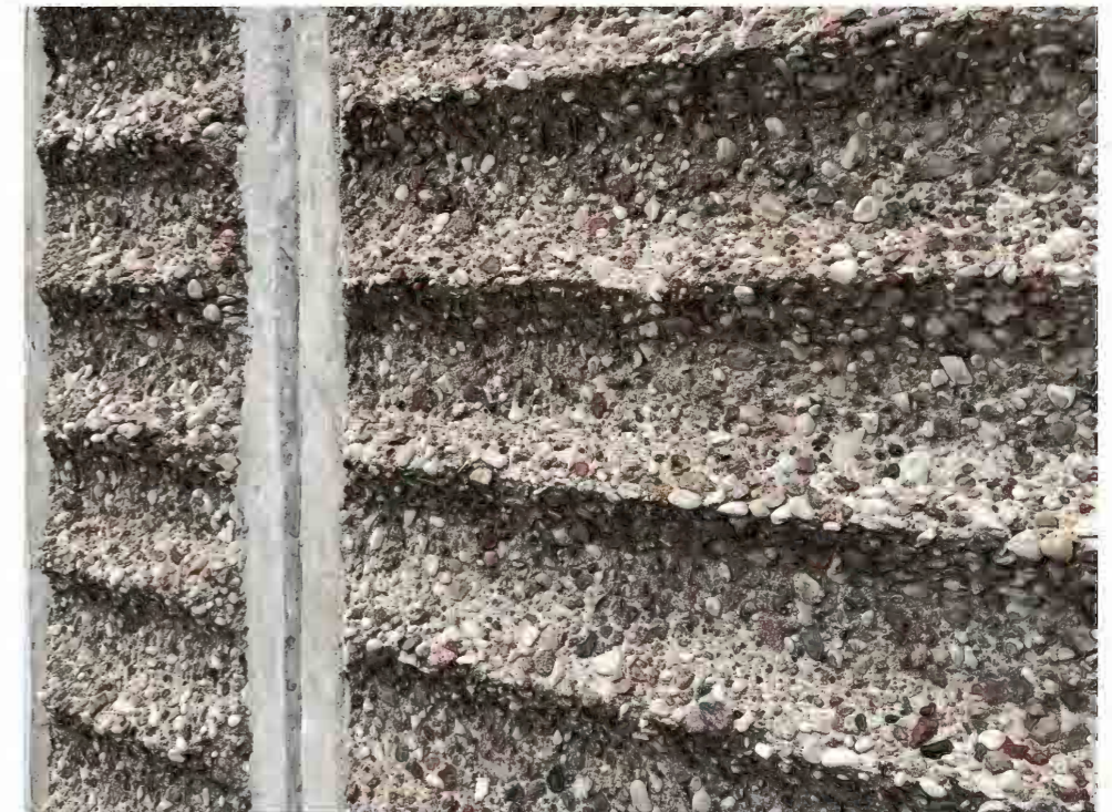
Detalj av den formgjutna sjöstensbetongen.
