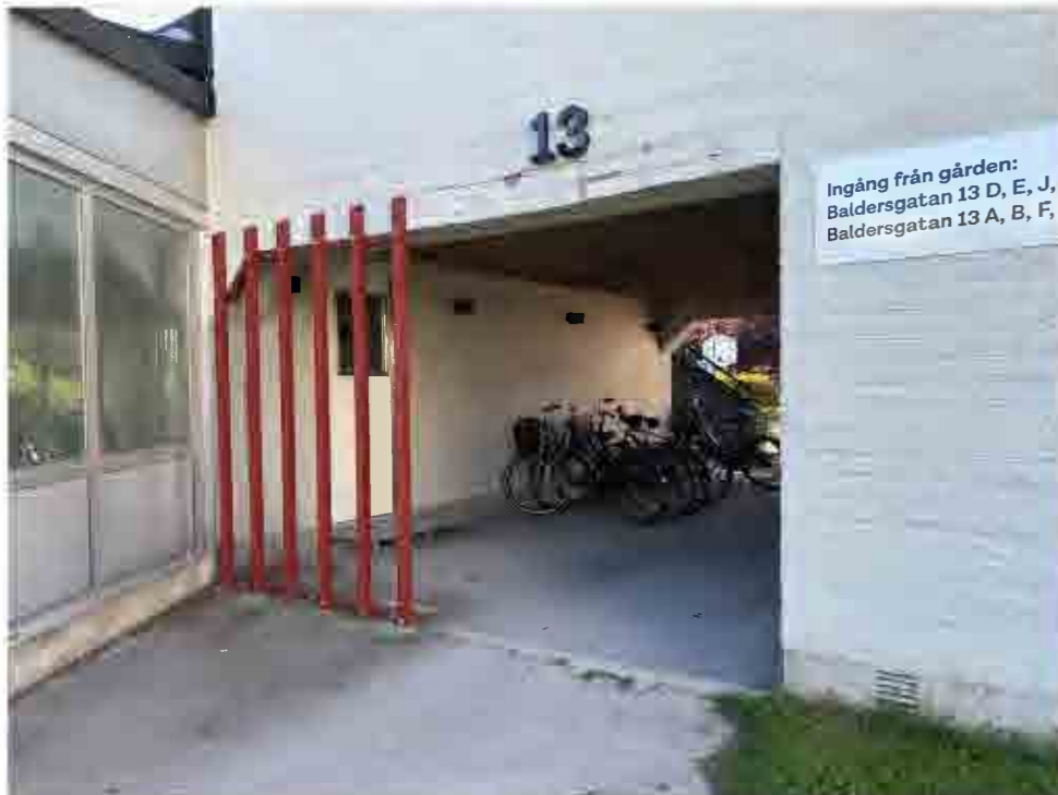
Gång- och cykeltunnel med bilhinder i form av vertikalt monterade stolpar.
