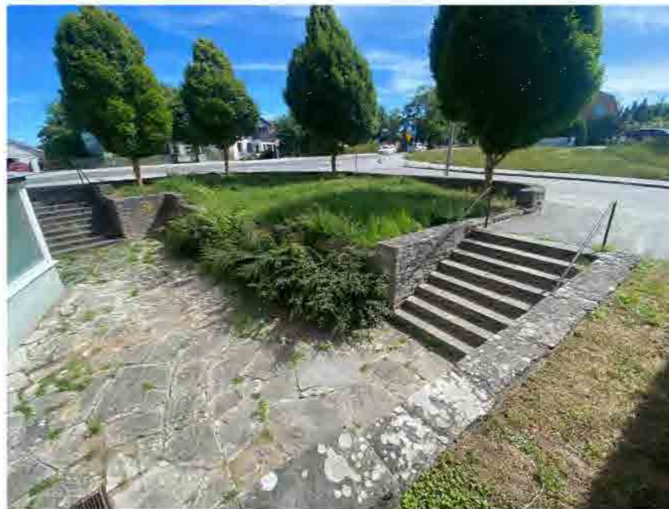
Stenlagd uteplats vid källarlokal, omgiven av stödmurar i kalksten och äldre, idag igenvuxen, plantering.
