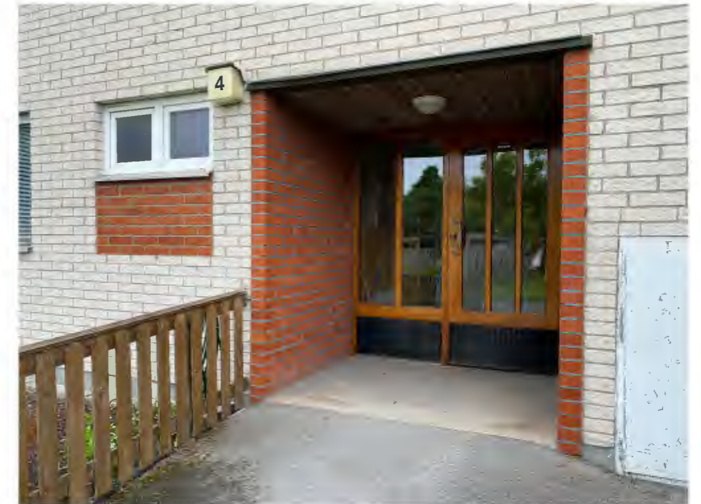
Trapphusentréerna ligger djupt indragna från fasad, markerade med väggar av rödtegel. Portarna i glas och trä, med sparkskydd av räfflat gummi är ursprungliga. Teglet återkommer också under badrumsfönstren, varav ett syns i bild.
