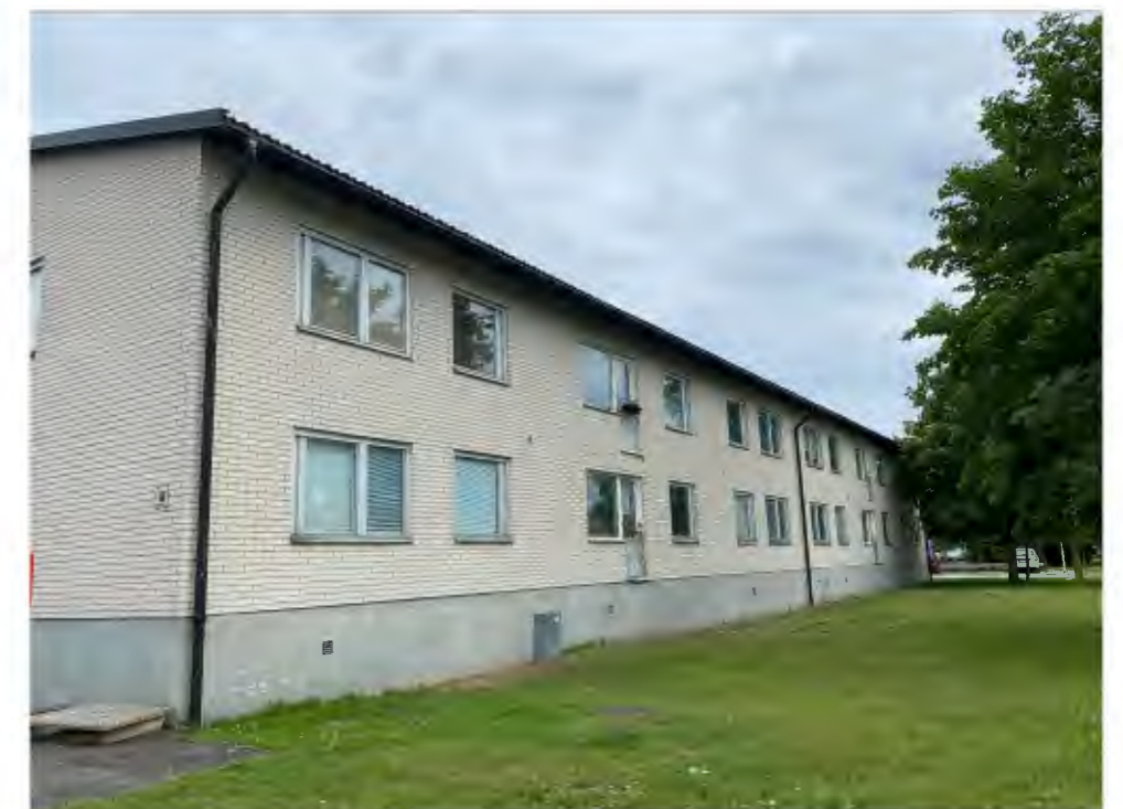
Husets baksida saknar entréer, men några av lägenheterna har en fransk balkong. Fönstren är utbytta och har idag bågar och karmar i aluminiumfärgad lättmetall.
