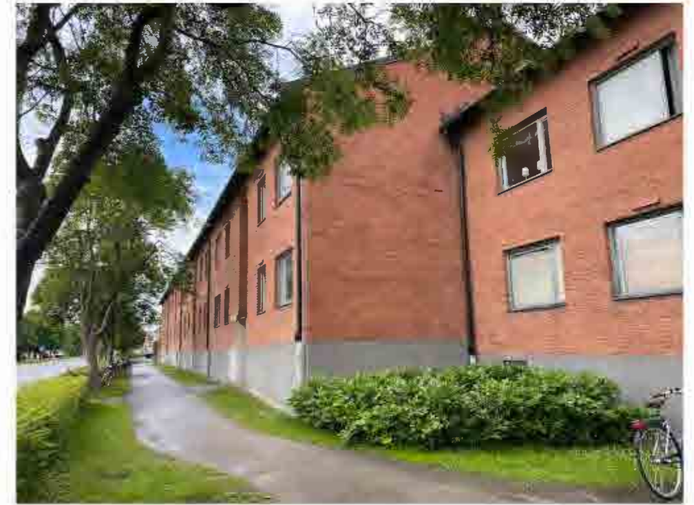
Vy längs med entréfasaden.
