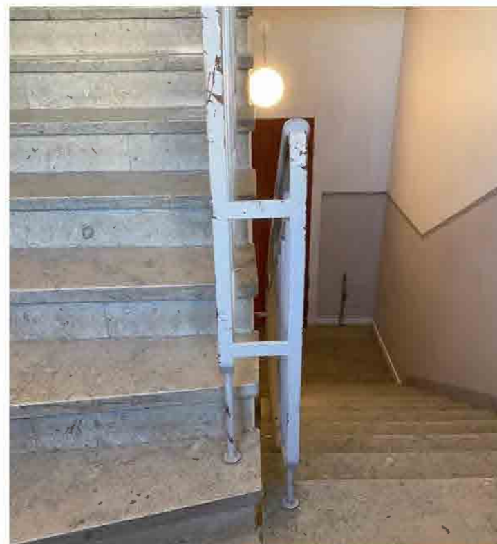
Golv och trappor belagda med lokal kalksten.
