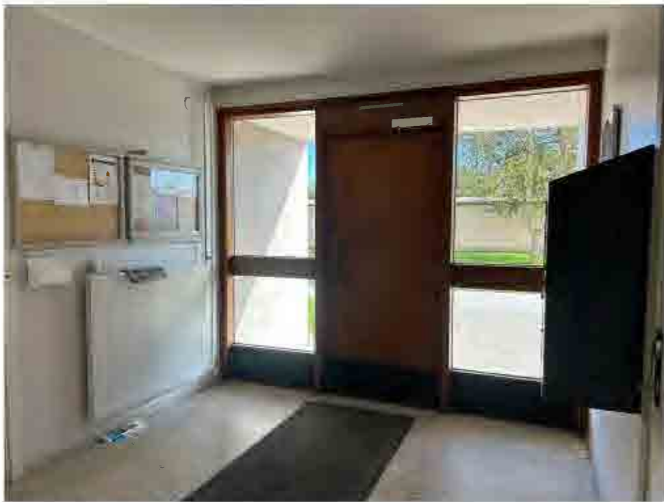
Vy mot entréporten inifrån förstugan. Golv, vilplan och trappornas plan och sättsteg är klädda med ljus terrazzo.
