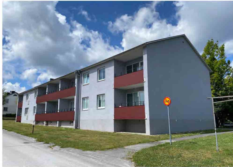
Fasaden mot Backvägen, till höger skymtar piskställningen. Huskroppen ligger lite indragen på fastigheten, med en bred remsa gräsmatta som buffertzonen mot vägen.
