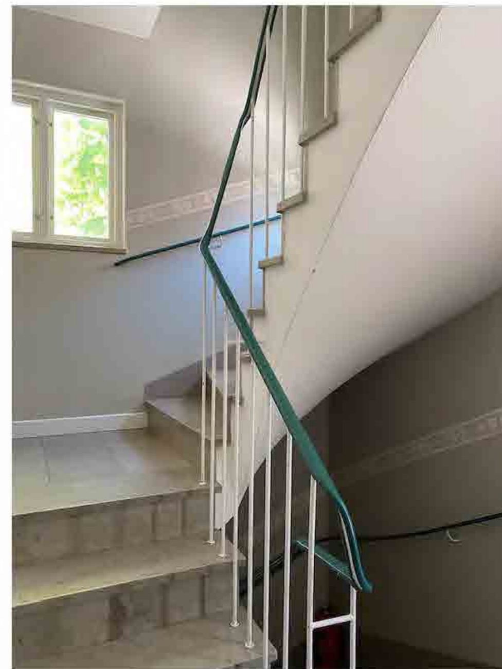
Ursprungligt trappräcke. Smidet är idag täckmålrat vitt och överliggaren utgörs av grön krympplast.
