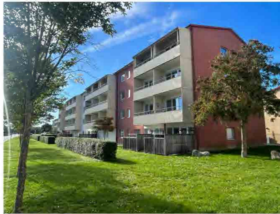
Balkongerna är utanpåliggande med fronter och sidoväggar i plåt.
