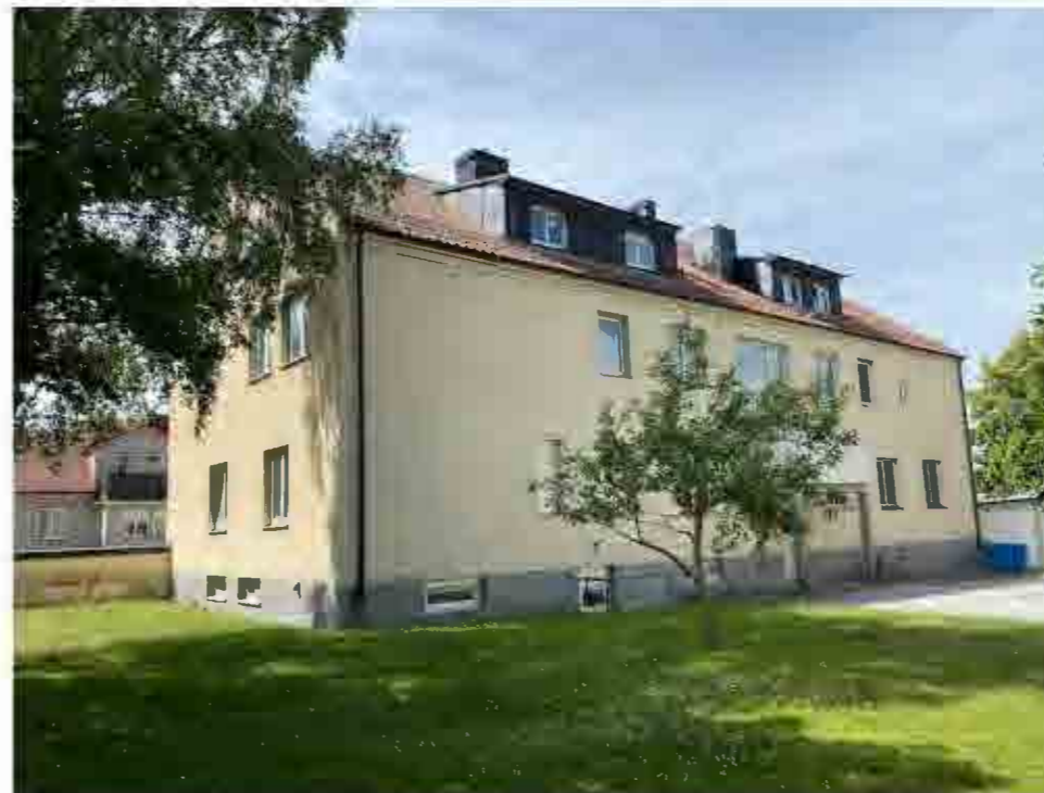
Gårdsmiljön är delvis asfalterad, delvis utgörs den av en klippt gräsyta med träd.
