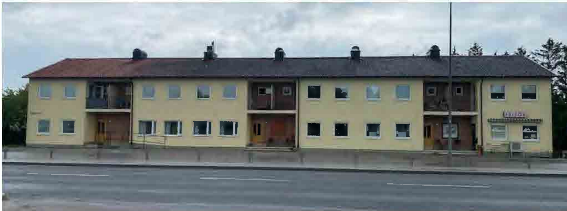
Fasad utmed Visbyvägen.
