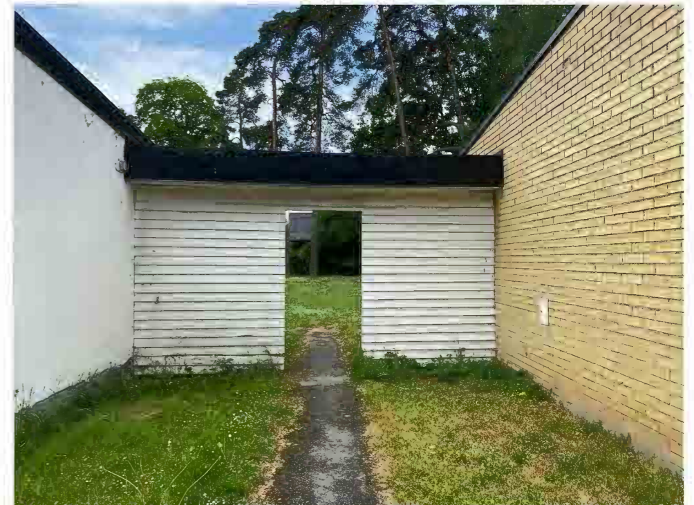
Ett plank med en enkel smal öppning länkar samman respektive bostadslänga med servicebyggnaden i mitten.
