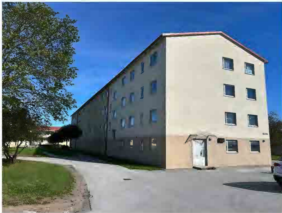
Vy mot byggnadskroppen längst i söder.
