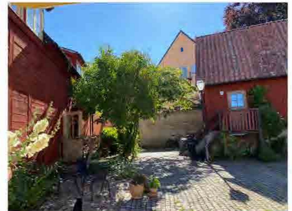
Fasaderna är målade med röd slamfärg.
