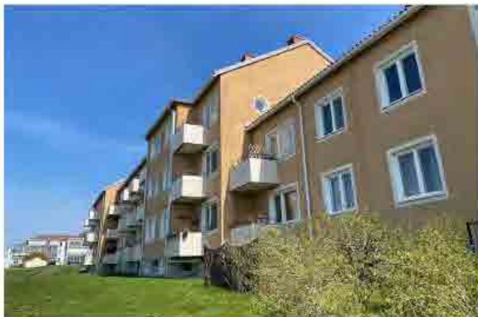
Lägenheternas balkonger är förlagda åt väster. I högdelen gavelröste finns ett hexagonformat fönster.
