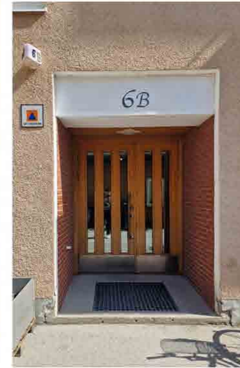
Entréparti i västra fasaden.
