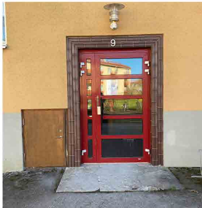
Trappusentré med postmodernistiskt dörrparti.
