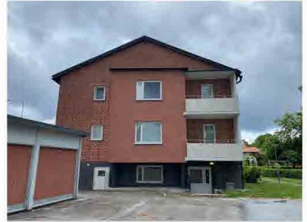
Gavelfasad med balkonger och burspråk.
