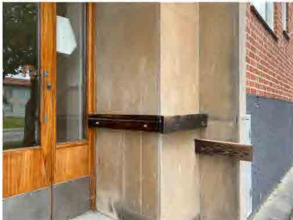
Portomfattning klädd i kalksten. Ursprunglig port i trä och glas.
