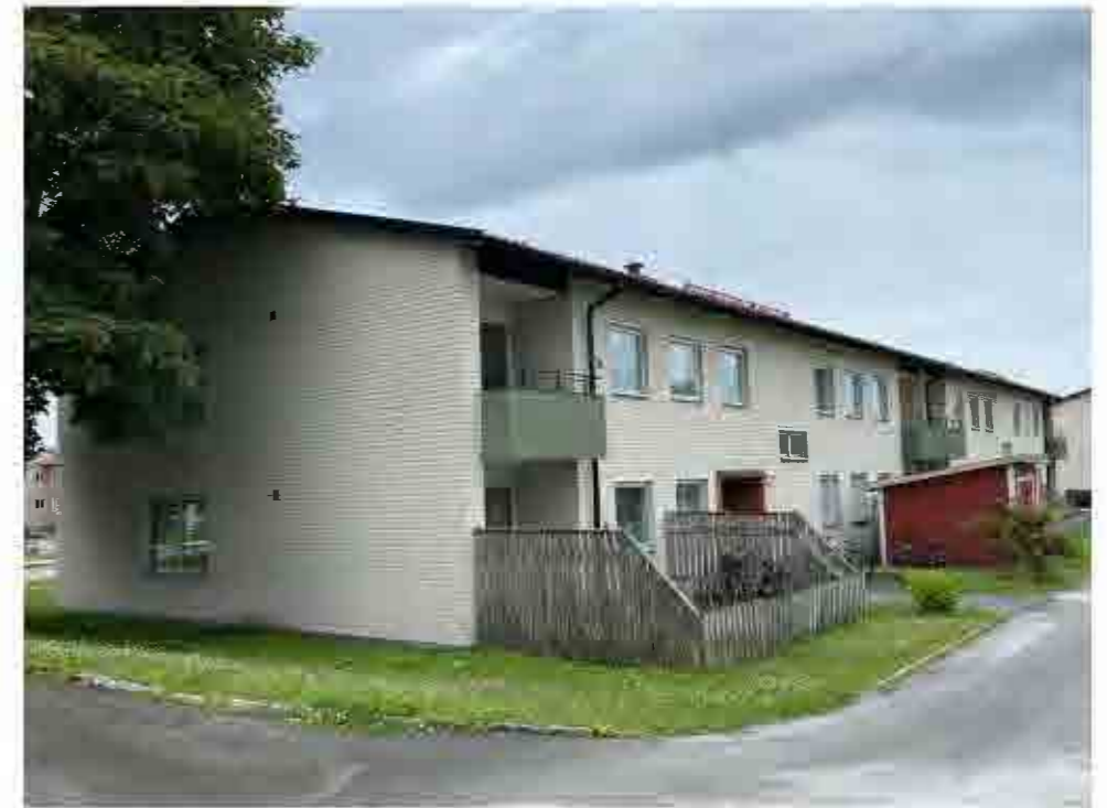
Bostadshusen är uppförda i två våningsplan, med balkong respektive uteplats i markplan.
