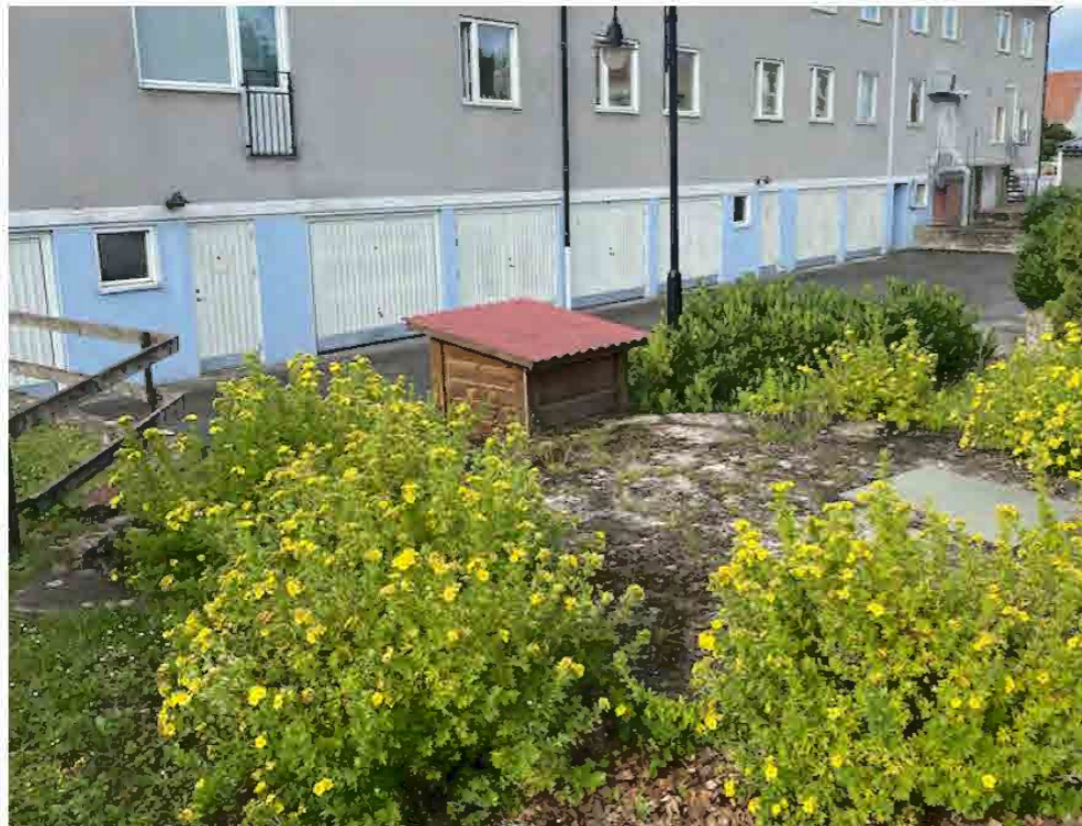
Ölandstok och stenläggning ovanför garage.
