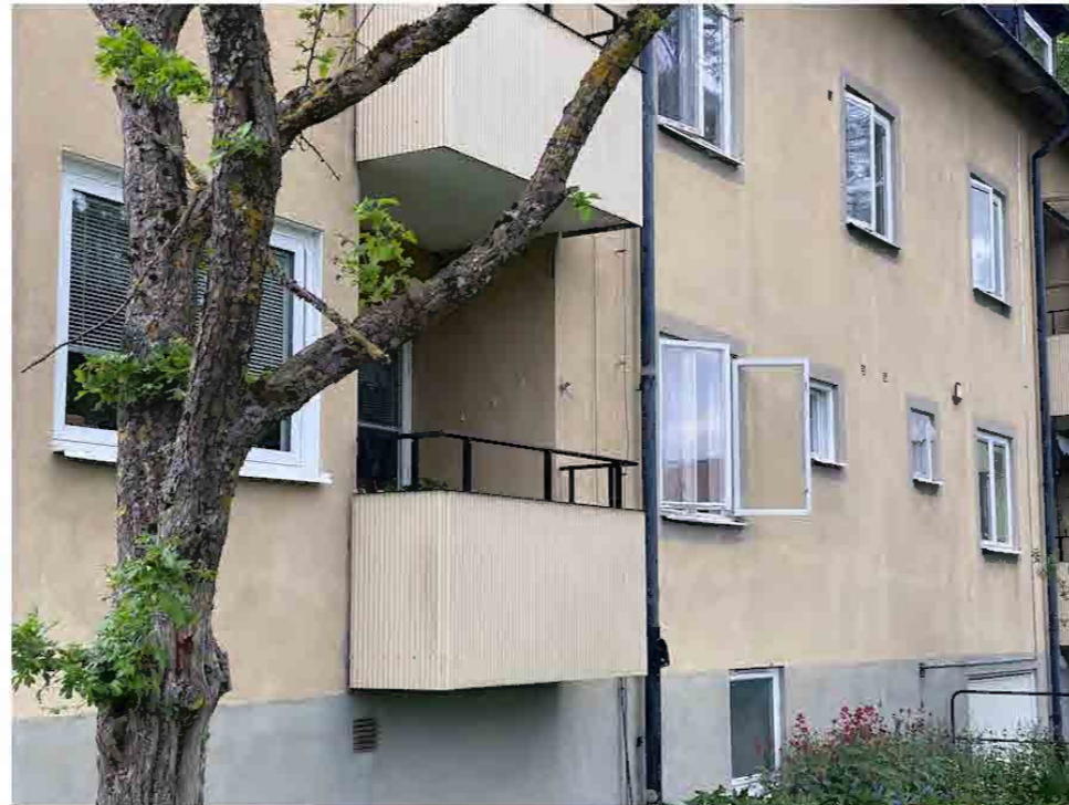
Huset har några bevarade, ursprungliga fönster.
