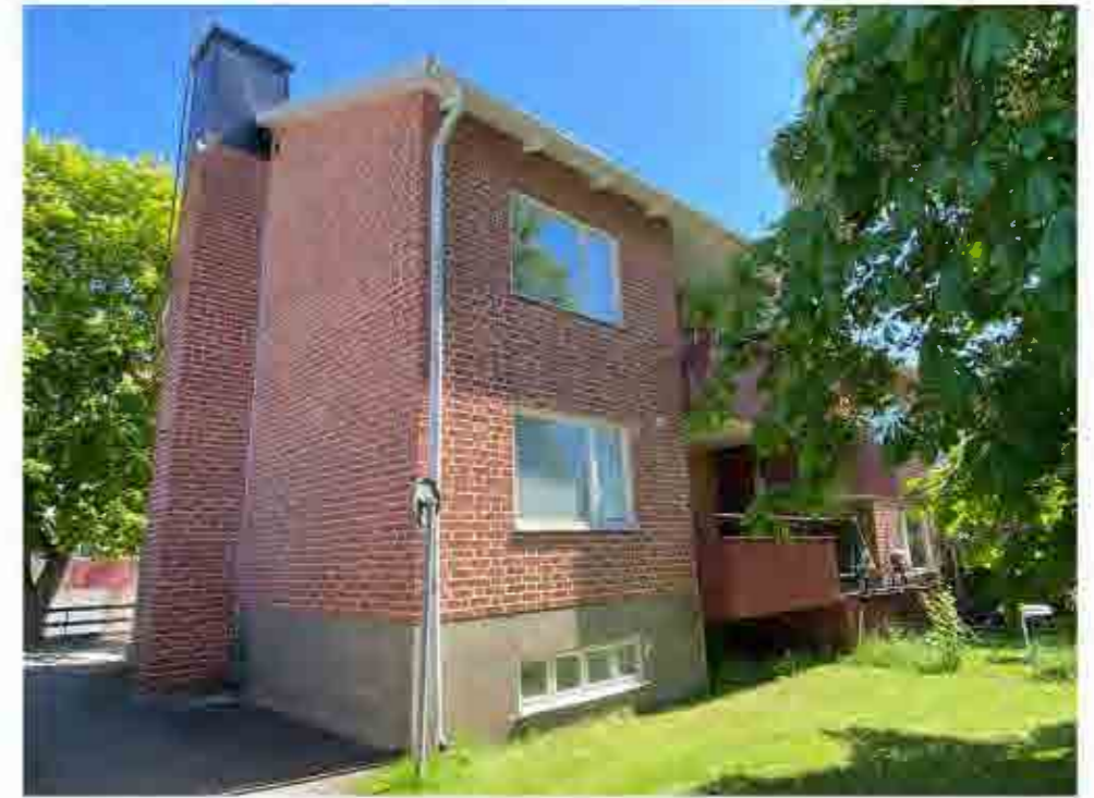
Fasader murade i rödtegel med motbyggd pannskorsten.
