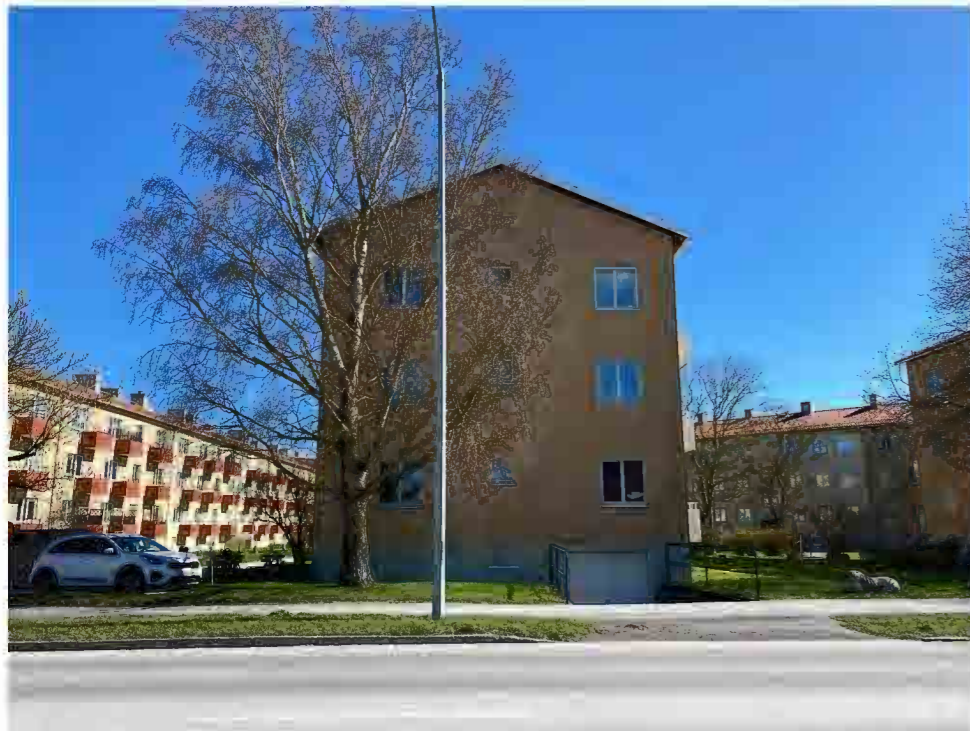
Gavelparti mot Lummelundsväg.
