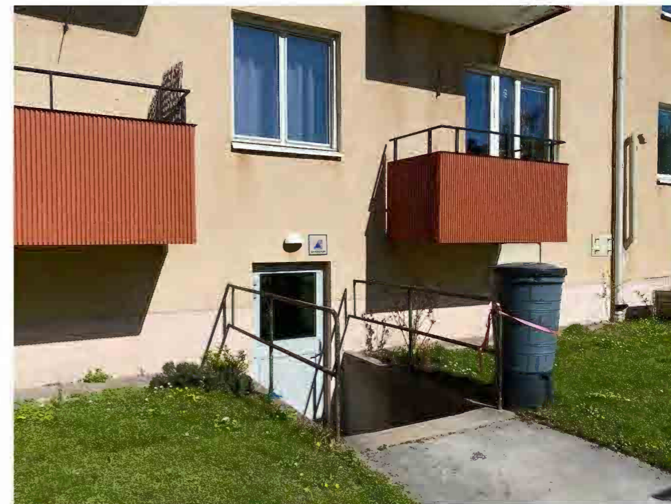
Källarlokal med skyddsrum mot gårdssidan.
