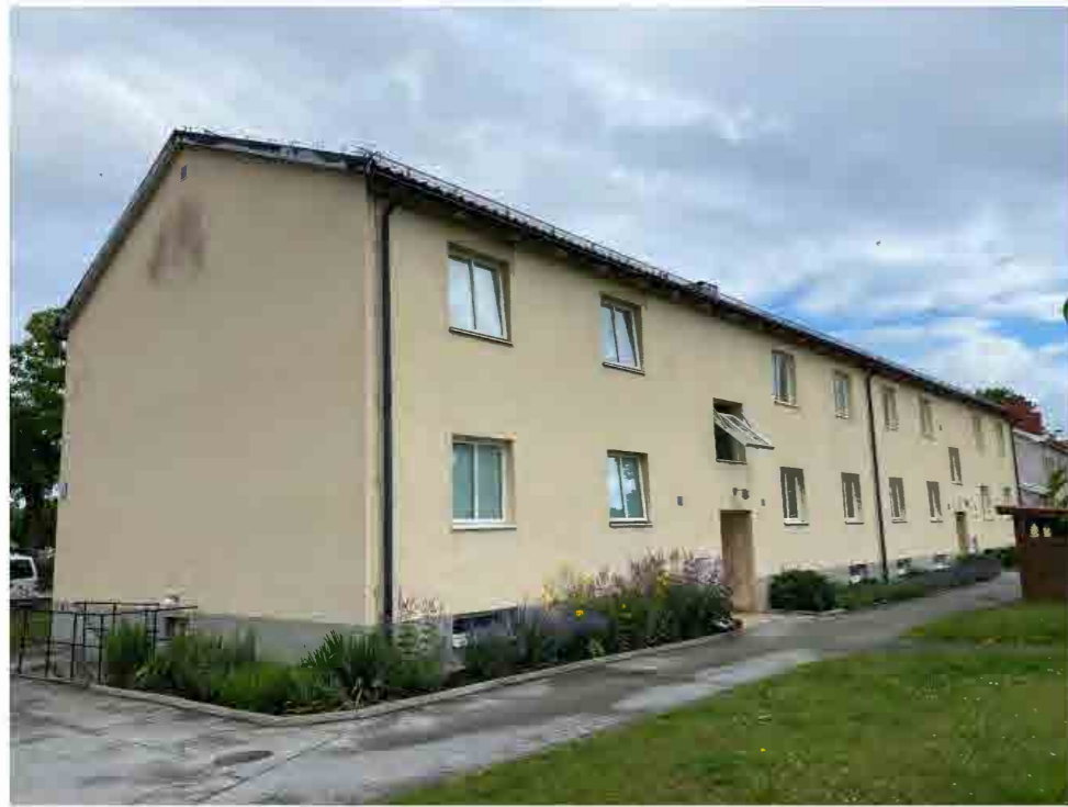
Entréfasad mot gården. Fönstren är utbytta till pivothängda lättmetallbågar.
