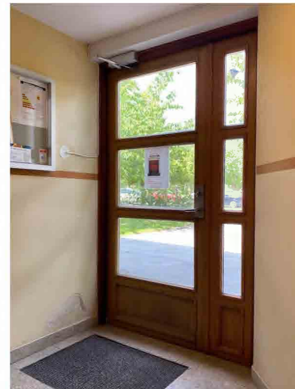
Ursprunglig port sedd från insidan. Strax innanför porten finns en matta nedfälld i kalkstensgolvet.
