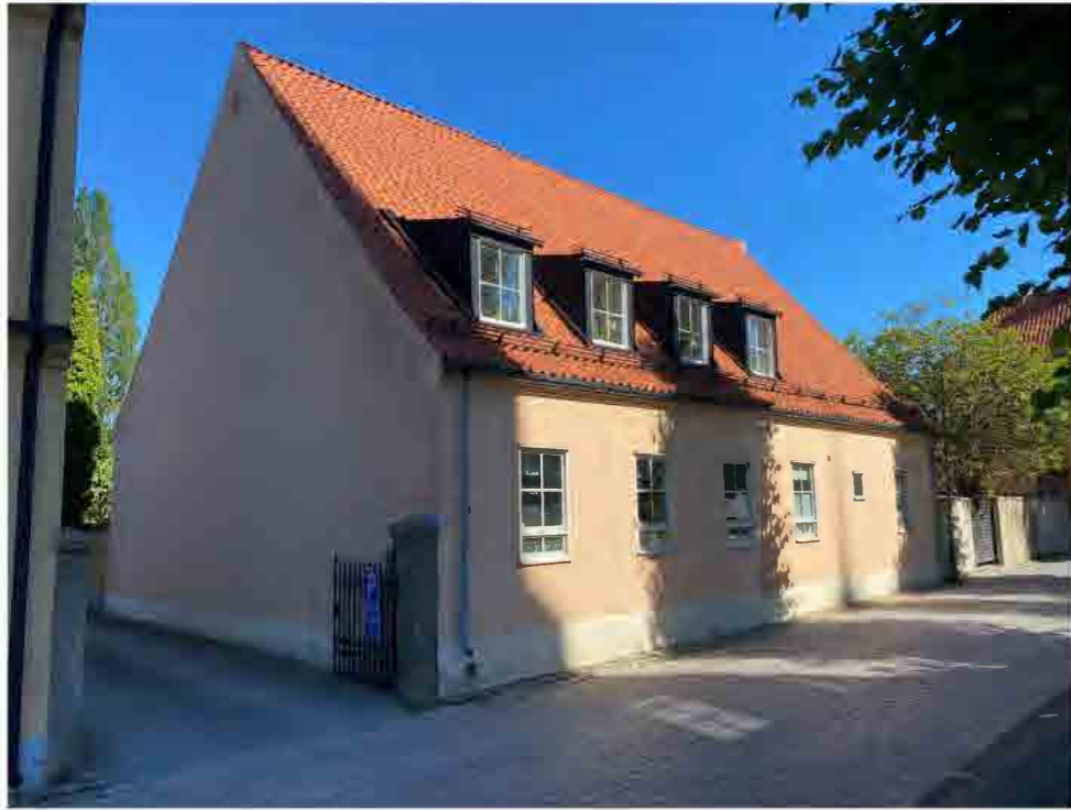
Fasaden utmed Västra Kyrkogatan.
