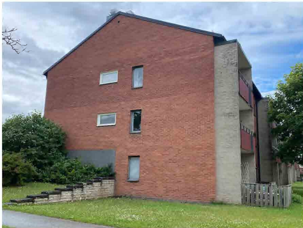
Gavelfasad mot vilken marken är ordnad med en stödmur i tegel.
