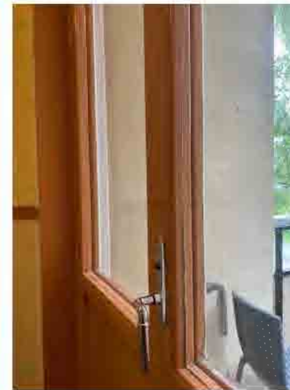
Detalj på dörrparti till piskbalkong.
