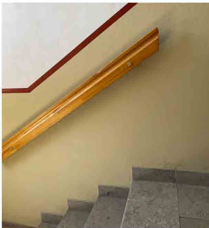
Trapplopp mellan förstuga och trapphus, med sekundärt tillkommen handledare i furu.
