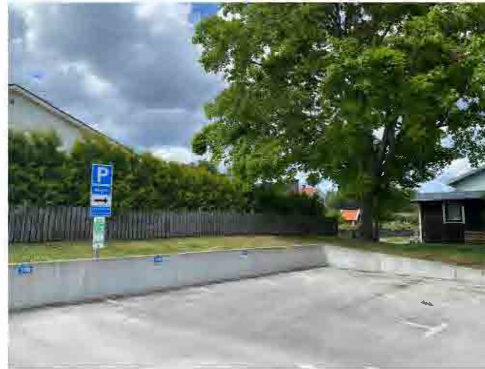
Asfalterad parkeringsplats i anslutning till bostäderna, med stödmurar i gjuten betong.
