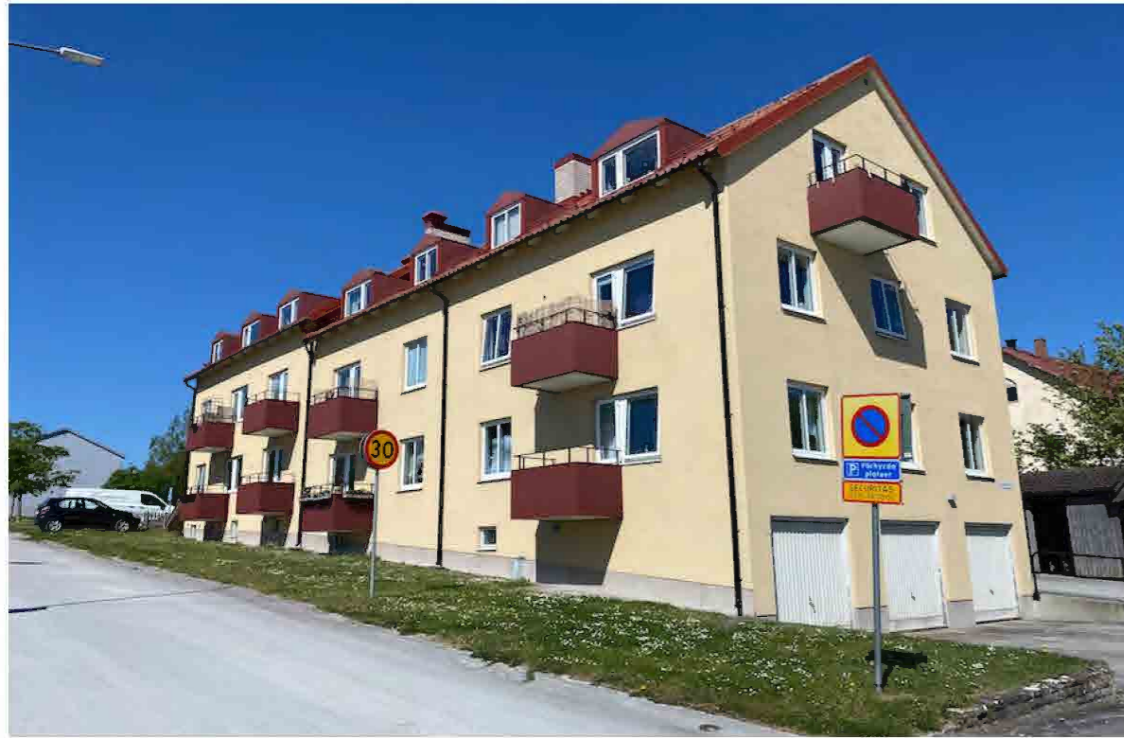
Fasaden mot Backvägen och gavelfasaden åt söder med garageportar.
