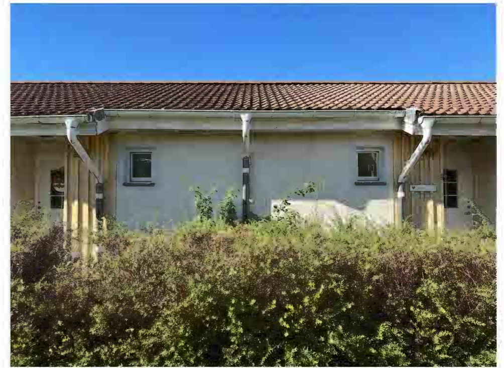
Radhusen i ett plan i kvarterets mitt har putsade fasader med panelade avsnitt. Taken är flacka sadeltak klädda med betongpannor.
