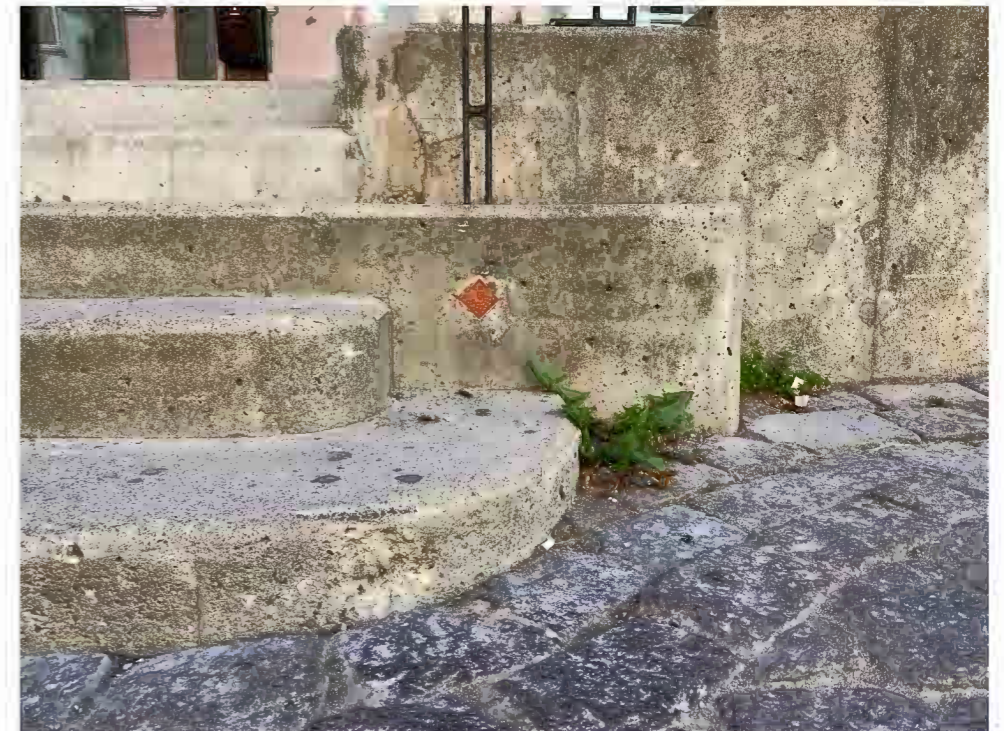
Detalj av formgjutna steg till trappan upp till gångstråket utmed Hästgatan.
