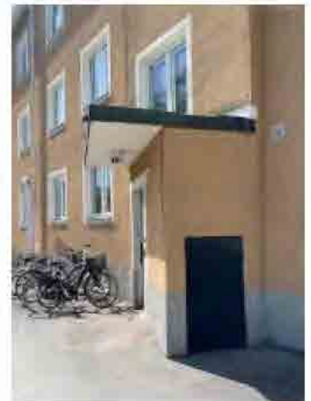
Entréerna är lekfullt snedställda och har fått bibehålla sina ursprungliga, kopparklädda tak.
