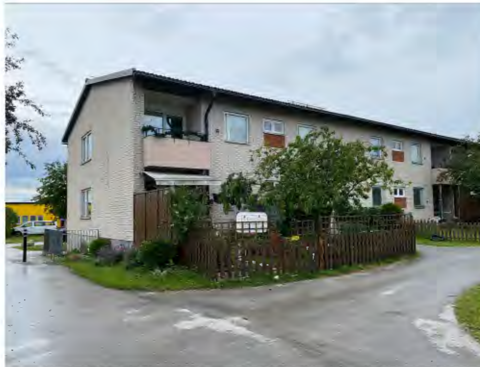
En av huskropparna, med fasader i kalksandsten. Entréfasaden vänder sig in mot gården och åt samma håll finns också lägenheternas balkonger och uteplatser.
