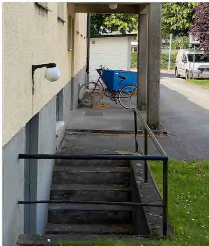
Vy längs med gårdsfasaden, under balkongen. Bevarad ursprunglig utombusarmatur.
