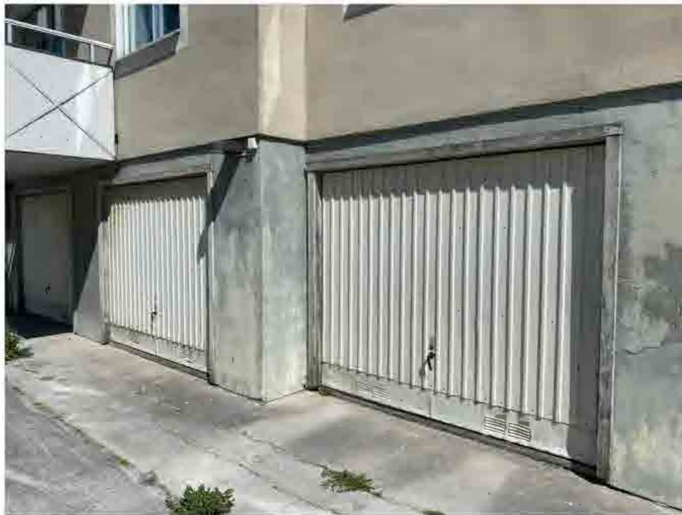
Detalj av garageportar.
