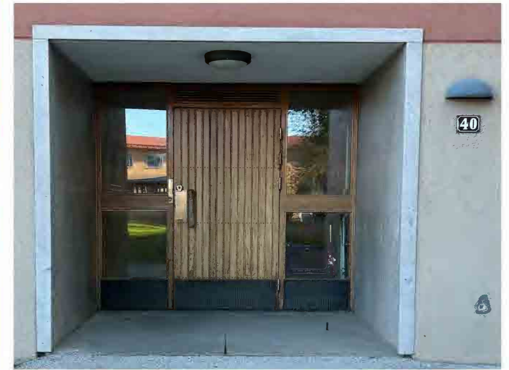
Ursprunglig entréport i trä och glas. Portnischen är klädd med kalkstensskivor.
