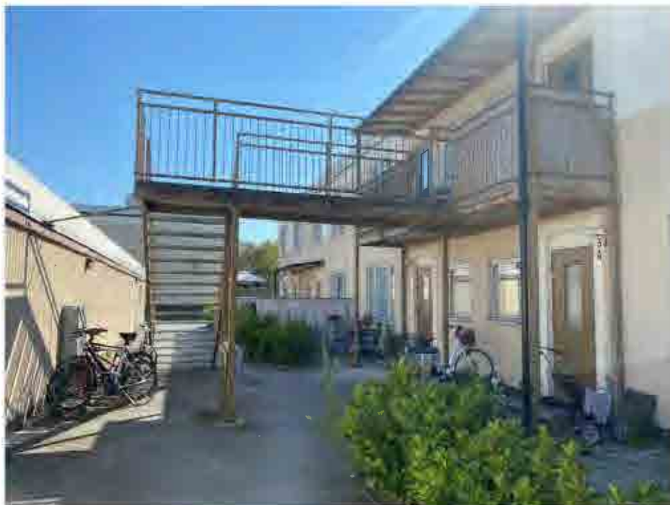
Extern trappa till lägenheter som iordningställdes på 1980-talet.
